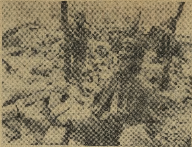
Wskutek tragicznego trzęsienia ziemi, jakie nawiedziło północno-wschodni Iran, 175 osób zginęło, a 450 zostało rannych. Wiele miejscowości uległo zniszczeniu. Na zdjęciu: ranny mieszkaniec jednej z wiosek na gruzach swego domu.
