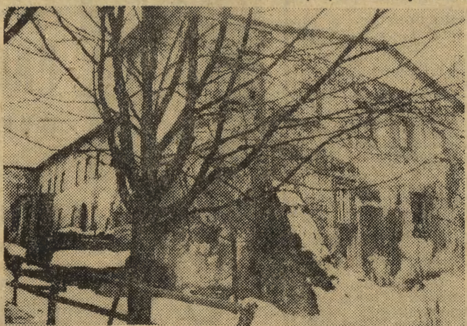
Pałac w Głębowicach, po pożarze.
