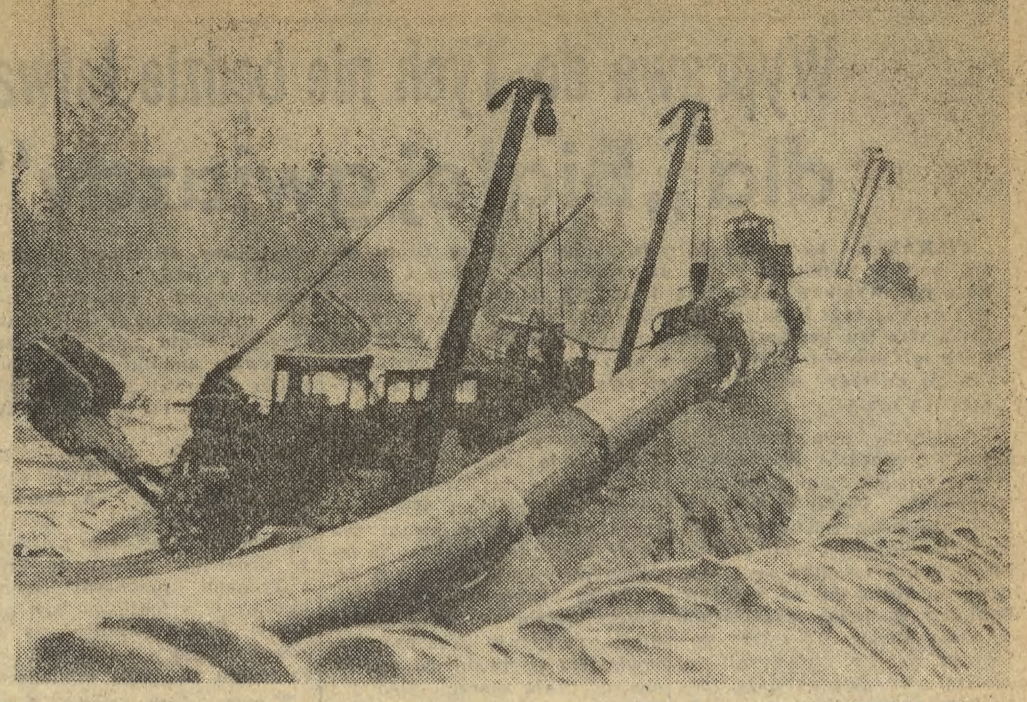
Prace przy budowie gazociągu na trasie Niżniewortowsk — Parabel — Kuzbas (ZSRR). Gazociągiem tym popłynie gaz ze złóż tiumeńskich do zakładów przemysłowych Kuzbasu.
