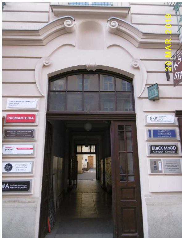
Fot. nr 168. Odnowione drzwi.
