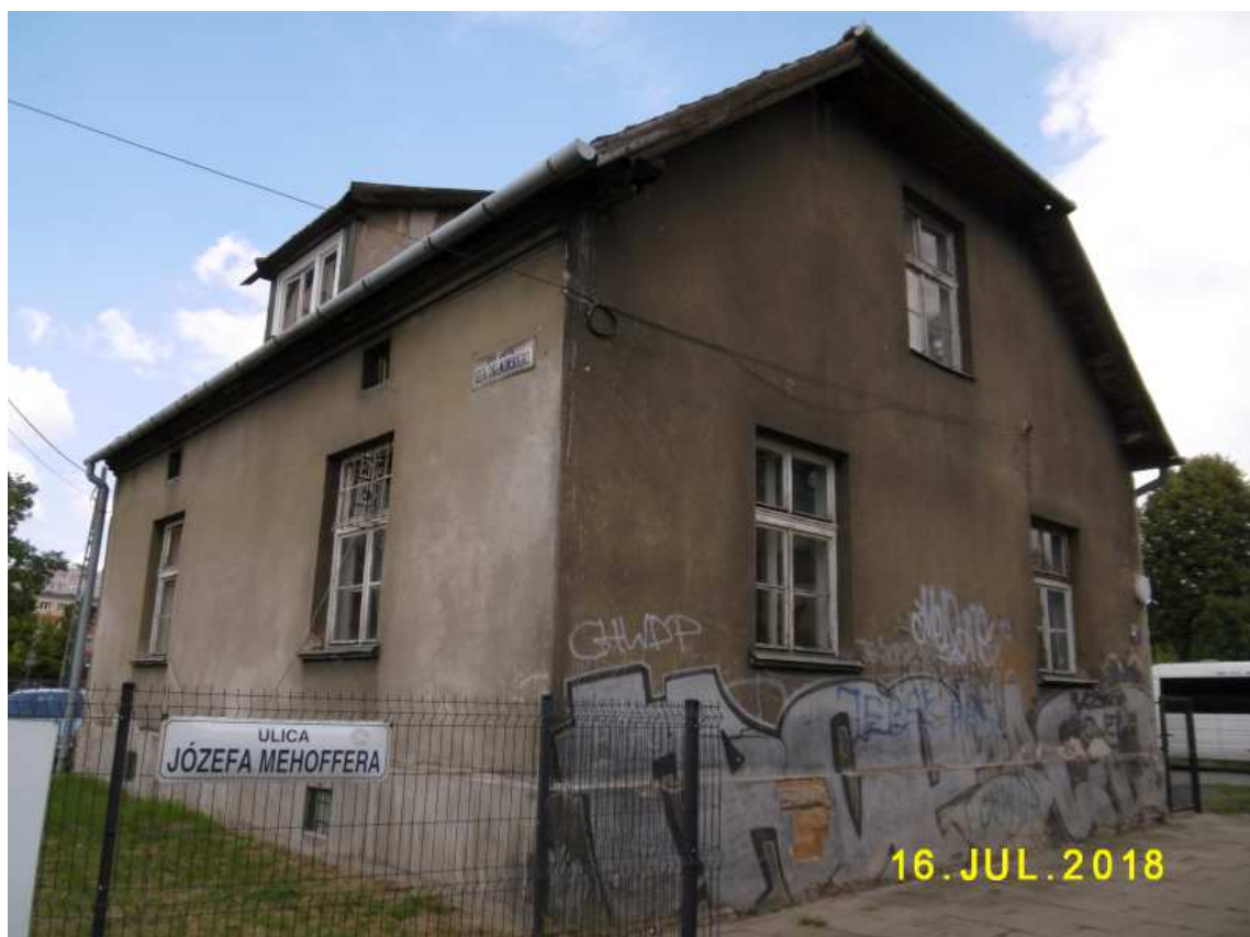
Fot. nr 188 (188-190). Kolejny relikw przedwojennej zabudowy z ulicy Mefofera 2.
