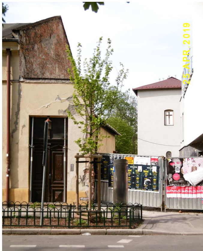
Fot. nr 181. Po wyburzeniu muru i bramy wjazdowej na teren dziedzińca dawnej ochronki odśloniła się wcześniej niewidoczna kaplica.
