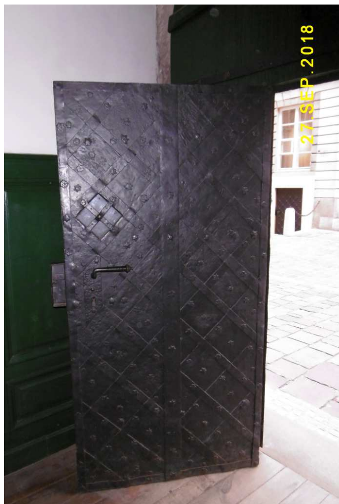
Fot. nr 48. Metalowe skrzydło drzwi.
