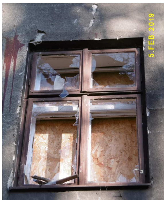
Fot. nr 219. Oryginalne okno nad wejściem od strony ulicy Estońskiej.
