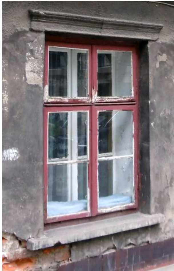
Fot. nr 217a. Oryginalne okna o cienkich szprosach, otwierane na zewnątrz.
