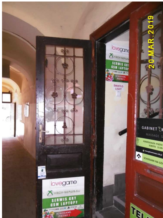
Fot. nr 120. Drzwi wiodące z sieni na klatkę schodową.
