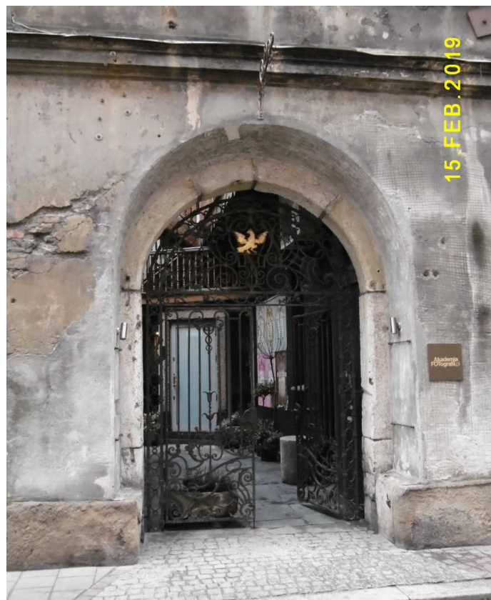
Fot. nr 80. Kute w metalu drzwi wejściowe do kamienicy.
