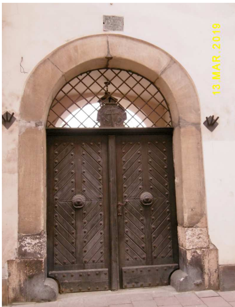
Fot. nr 89 (89-92). Detale dobudówki do Domu Pod Krzyżem od strony ul. św. Marka 24.
