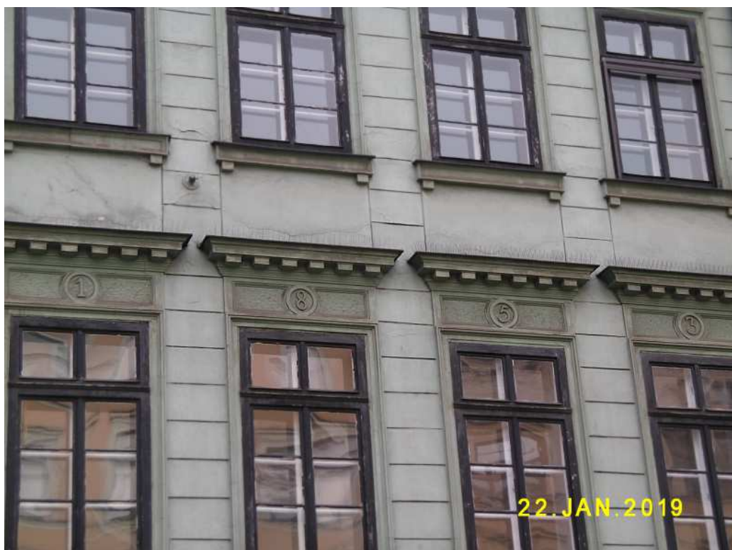
Fot. nr 26. Data odbudowy kamienicy z ulicy Dominikańskiej 5 po pożarze z roku 1850 nad oknami I piętra - 1853.
