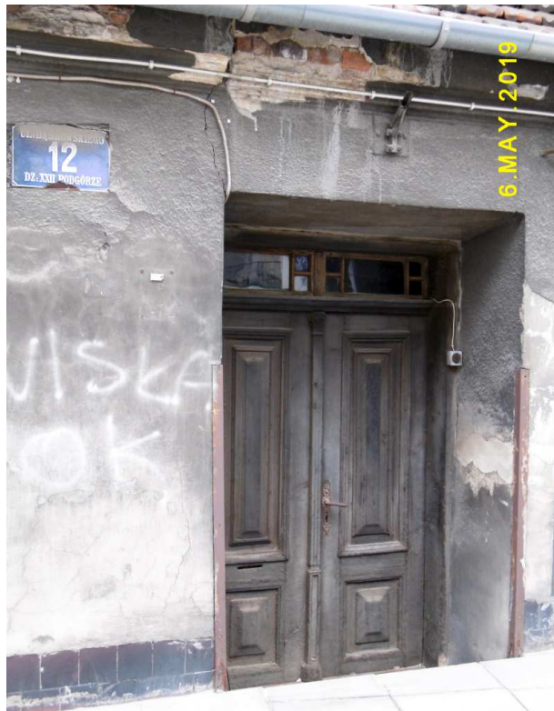
Fot. nr 217b. Drzwi i mozaikowy kiedyś świetlik w ich górnej części.
