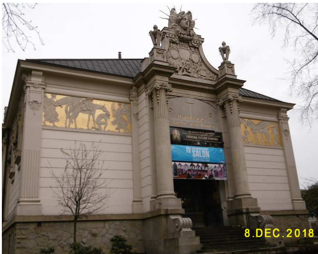
Fot. nr 63 (63-64). Detale Pałacu Sztuki z placu Szczepańskiego 4 Gorgona Meduza w zwieńczeniu ponad kolumnowym portykiem od strony bocznej.
