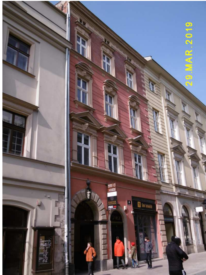
Fot. nr 73 (73-75). Kamienica z ulicy Sławkowskiej 4 i jej detale.
