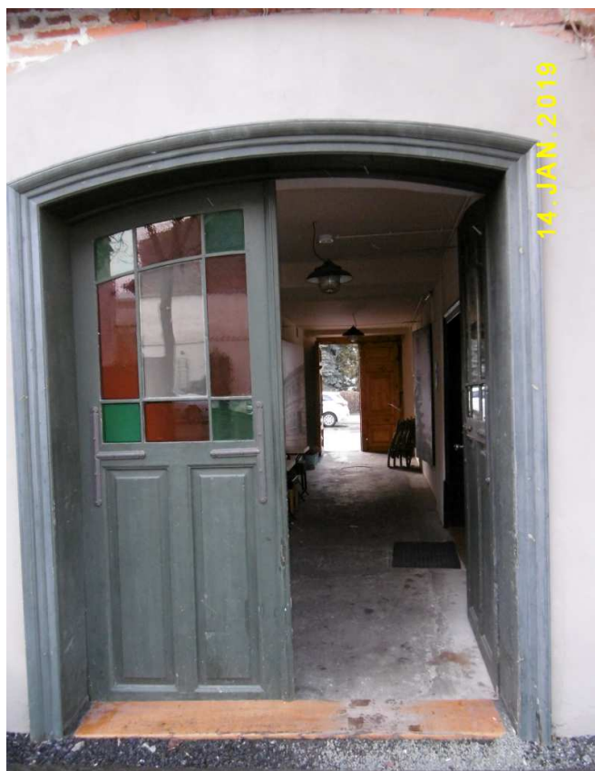
Fot. nr 141. Mozaikowe drzwi wewnętrzne od strony podwórza.
