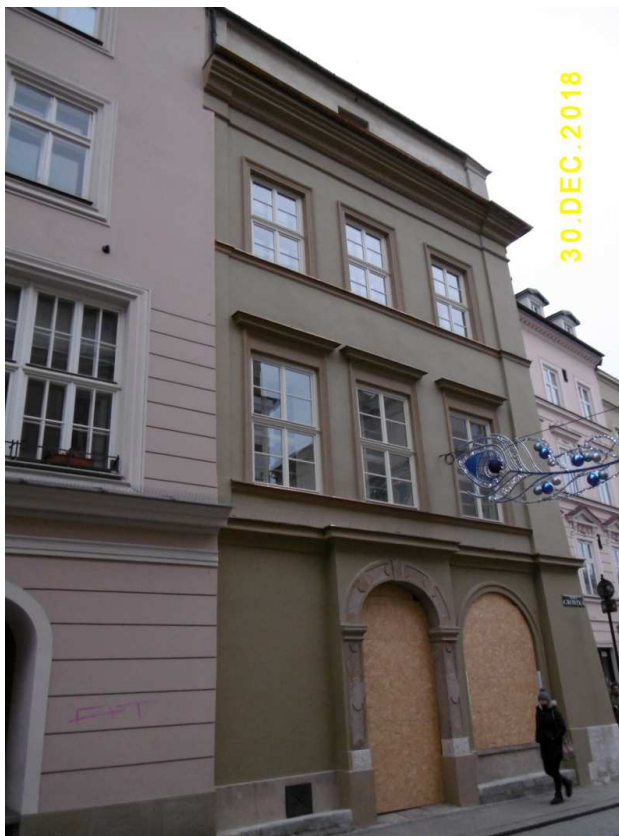
Fot. nr 33. Świeżo odnowiona kamieniczka z ulicy Grodzkiej 44, której przywrócono dawne, ośmiopolewe okna.
