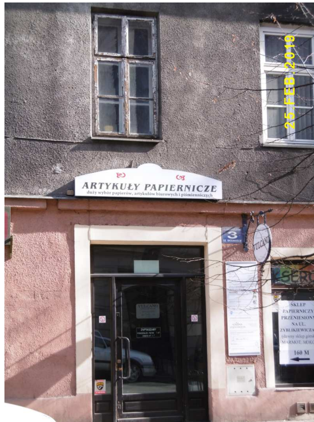
Fot. nr 109. Ostatnie oryginalne okno w domu przy ulicy Librowszczyzna 3.
