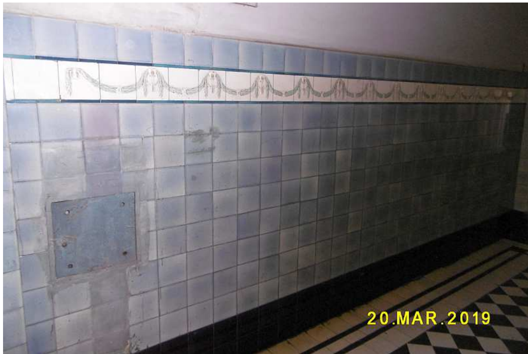
Fot. nr 169 (169-172). Oryginalne płytki na podłodzei ścianach w sieni kamienicy.
