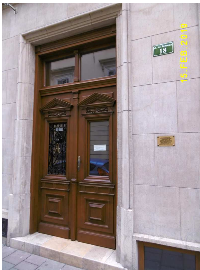
Fot. nr 84. Odnowione drzwi kamienicy z ulicy św. Tomasza 18.
