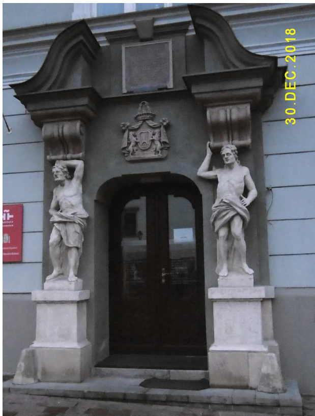
Fot. nr 34. Portal kamienicy „Zerwikaptur” przy placu św. Marii Magdaleny 2.
