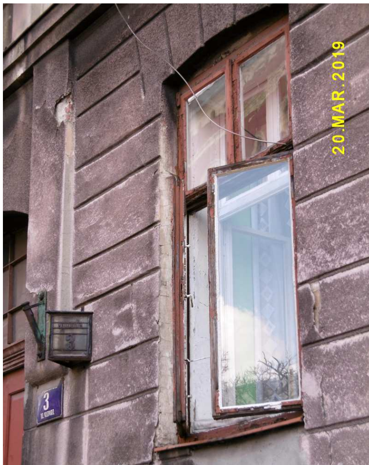
Fot. nr 97 (97-98). Nieczęsty już przykład okna otwieranego na zewnątrz i blokującego przez zamykaniem skrzydeł haczyka.
