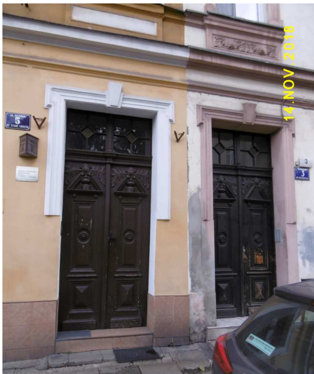
Fot. nr 204. Oryginalne drzwi kamienic przy ulicy Gazowej 3 i 5.
