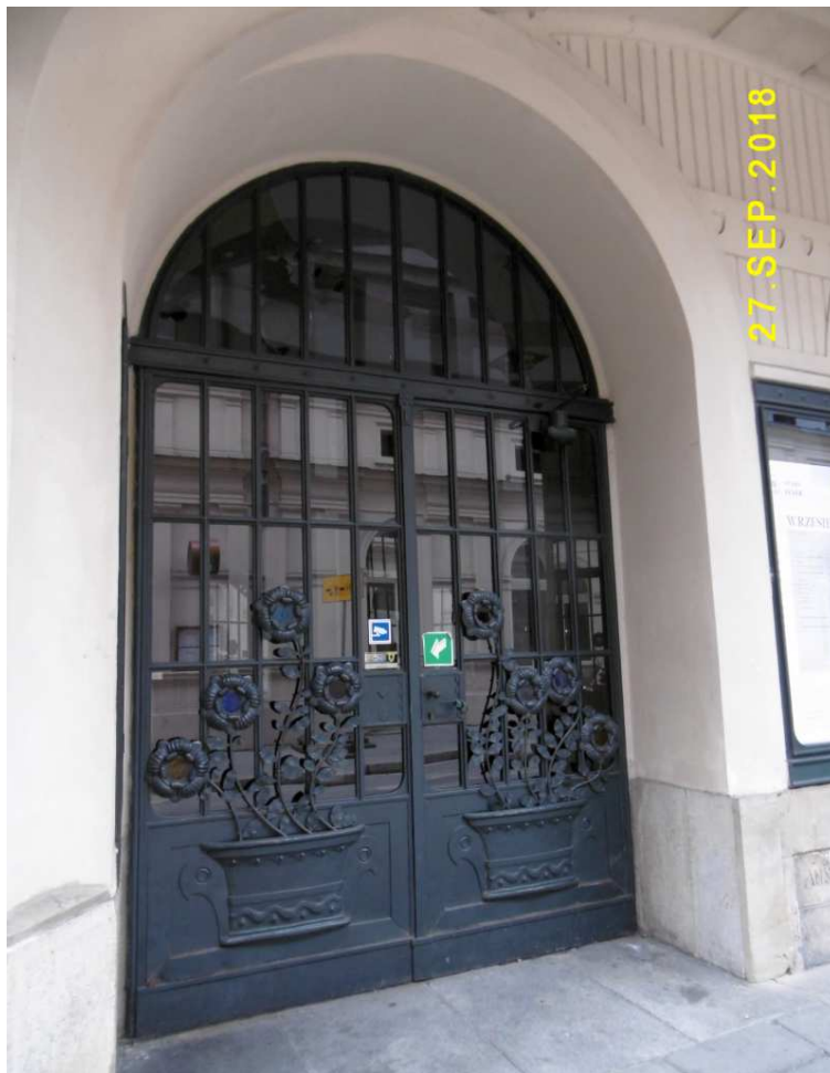
Fot. nr 65 (65-67). Detale Teatru Starego. Tu secesyjne drzwi.
