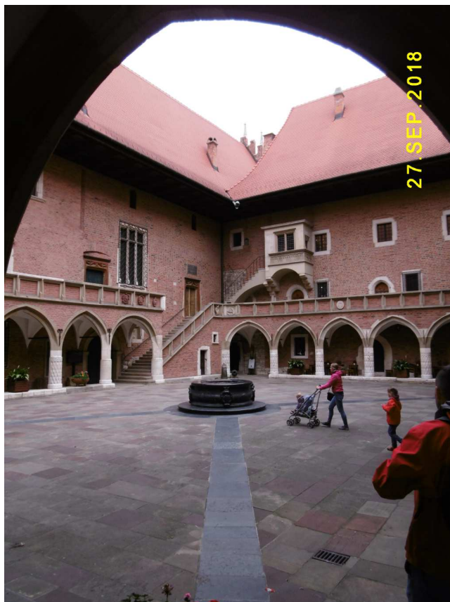
Fot. nr 53. Narożnik północno-wschodni.
