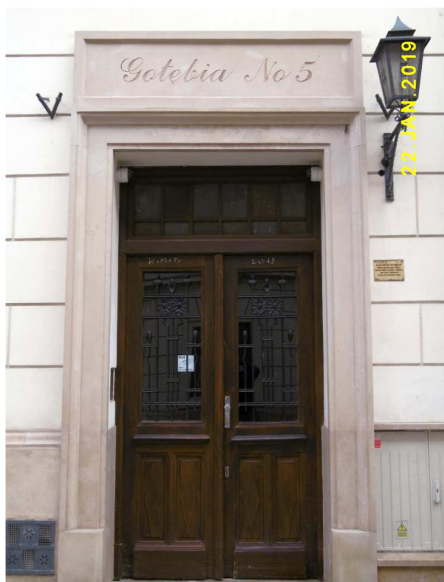
Fot. nr 42. Nieco zmieniony po remoncie w stosunku do oryginału portal kamienicy z ulicy Gołębiej 5 (napis Gołębia 5 jest współczesny) i jej oryginalne drzwi, niestety bez klamki.
