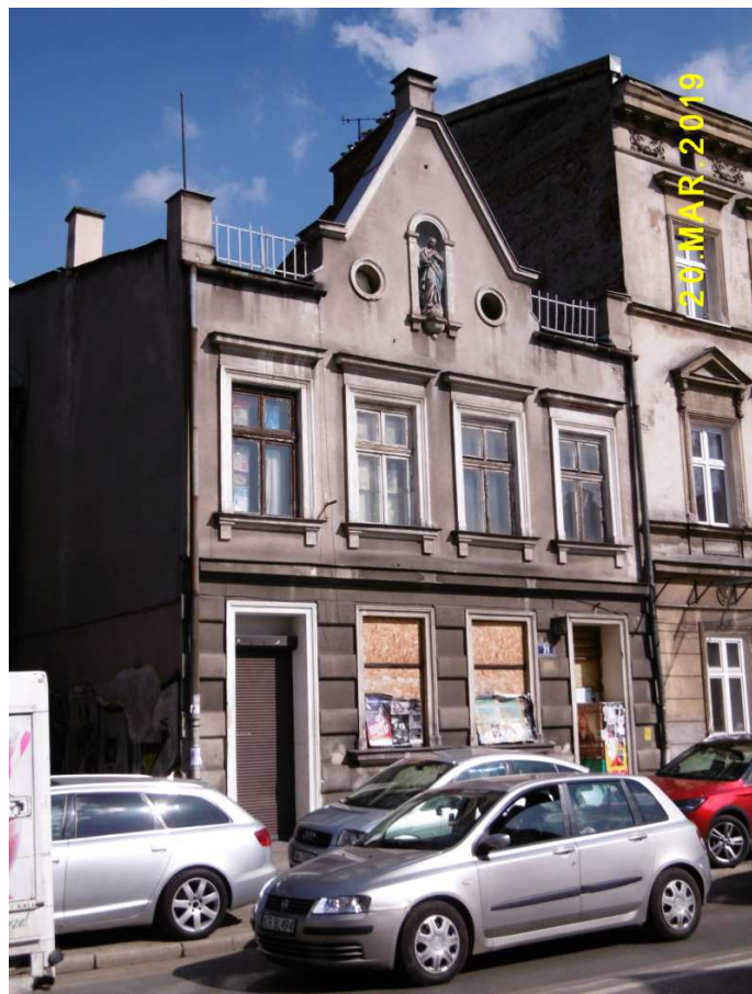
Fot. nr 157 (157-158). Kamieniczka z ul. Czarnowiejskiej 21, której byt jest zagrożony.
