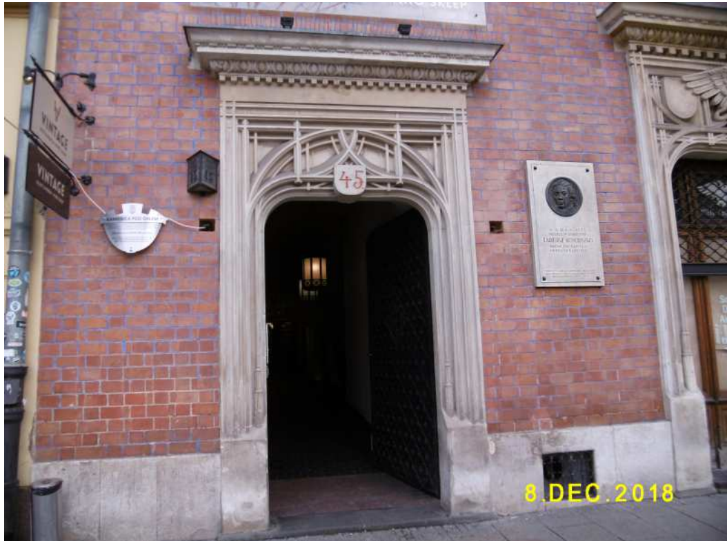
Fot. nr 7. Portal kamienicy, której fasadę stworzył pod koniec XIX wieku Wł. Ekielski.
