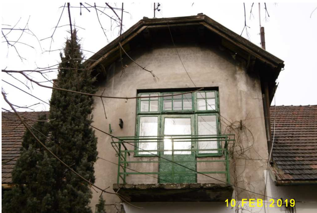
Fot. nr 223. Originalne drzwi w mansardzie dachu.
