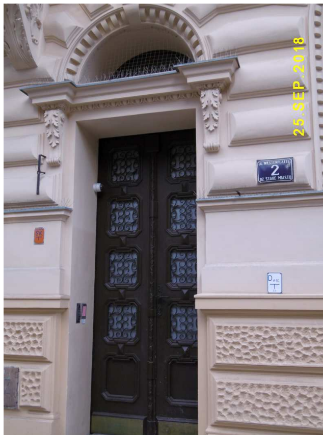
Fot. nr 110 (110-111). Odnowione drzwi kamienicy przy ulicy Westerplatte 2.
