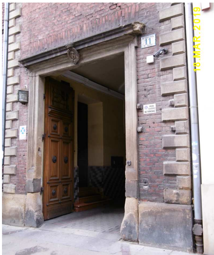
Fot. nr 131 (131-133). Pałac Mioszowskich z ulicy Krupniczej 11. Brama wjazdowa.
