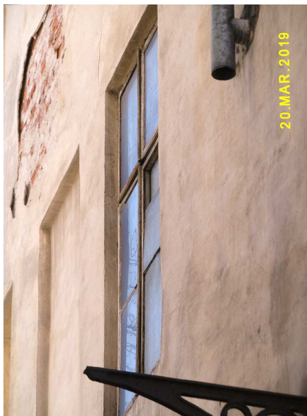
Fot. nr 161. Zachowane do dziś oryginalne okno o cienkich szprosach, otwierane na zewnątrz, które liczy sobie ponad sto lat.
