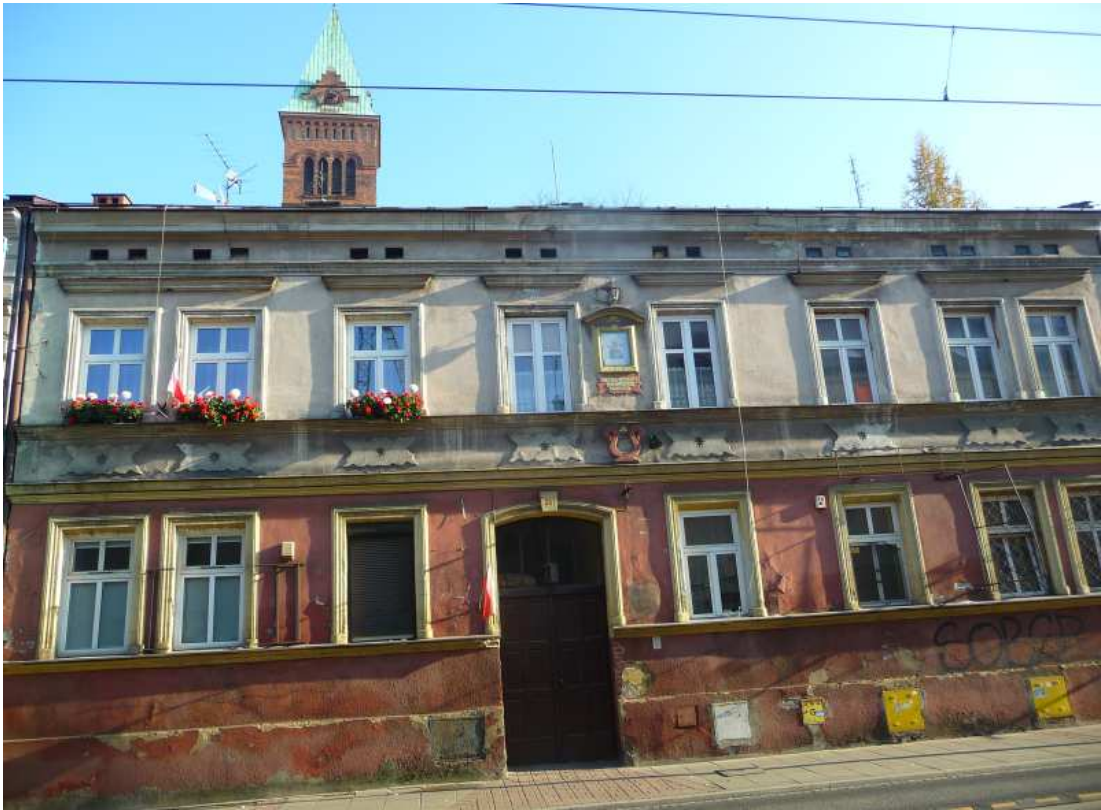
Fot. nr 212 (212-212a). Dom z ulicy Kalwaryjskiej 53. (11.11.2018)
