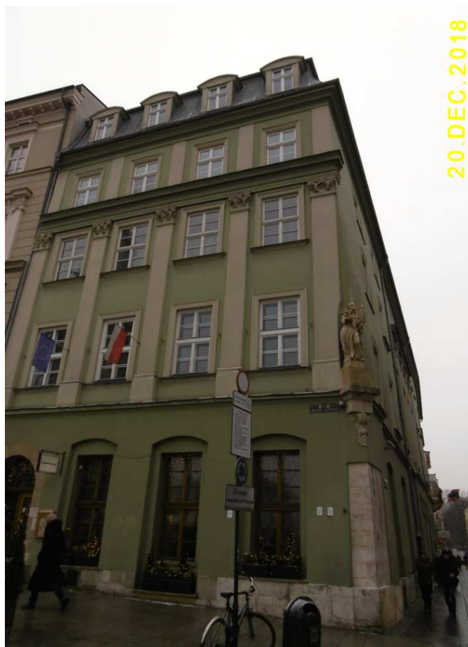
Fot. nr 19 (19-20). Kamienica Pod św. Janem Kapistranem spod nr 26.
