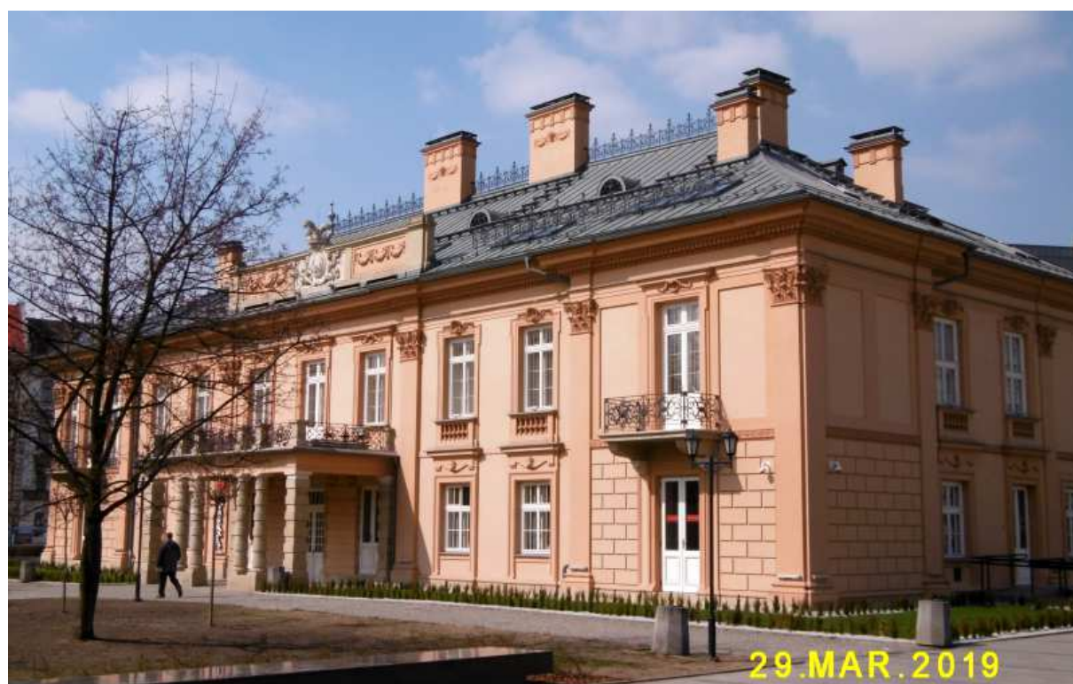
Fot. nr 116 (116-117). Pałac Wolodkowiczów tuż po zakończonym remoncie, gdzie zostały zachowane dawne detale, m.in. podziały okienne.
