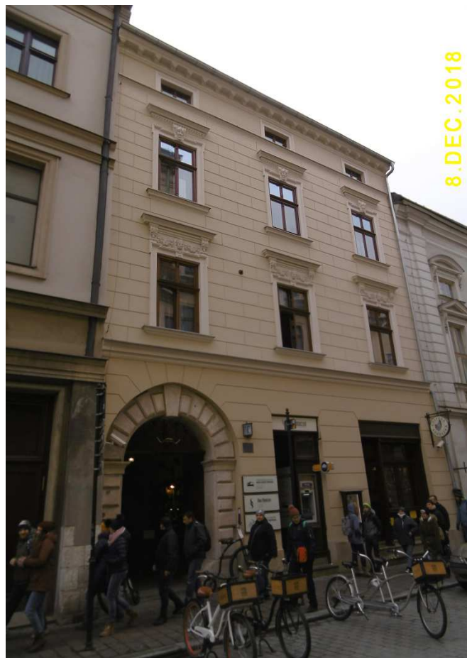
Fot. nr 60 (60-61). Odnowiona kamienica z ulicy św. Anny 4 i jej detale.
