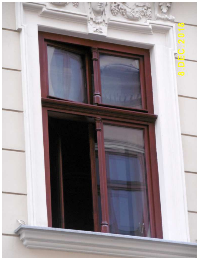
Fot. nr 61. Bliskie oryginałowi nowe okno, które jest już otwierane do wnętrza.
