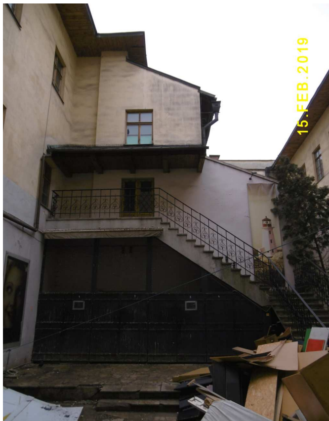
Fot. nr 77. Podwórk kamienicy.
