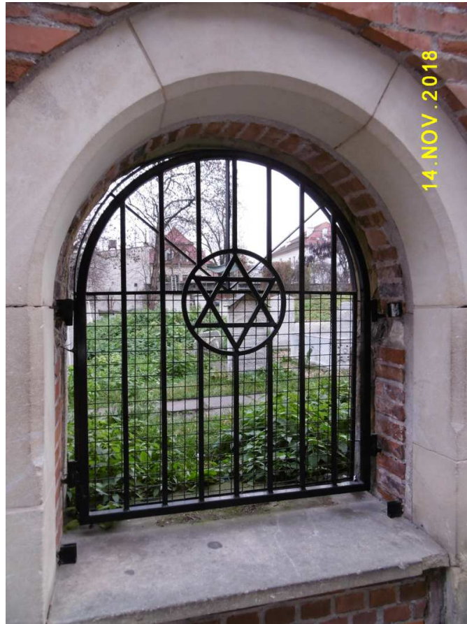
Fot. nr 210. Krata w murze cmentarza Remuh od strony ulicy Jakuba.
