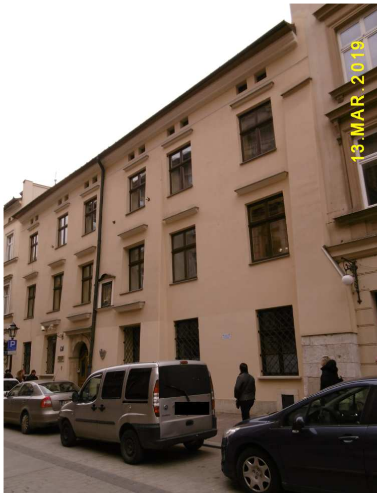
Fot. nr 85 (85-86). Kamienica z ulicy Szpitalnej 20 i jej detale.
