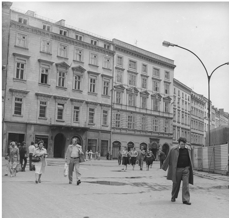
Fot. nr 1a. Kamienica Louisów pod nr 13 (z prawej) wg stanu z roku 1980. (NAC)
