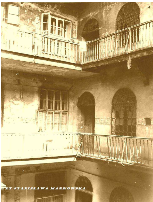
Fot. nr 24. „Przerażona jestem tymi zdjęciami, ale to było jak kamienica już nie była zamieszkała i popadła w ruinę”. Opis S.M.
