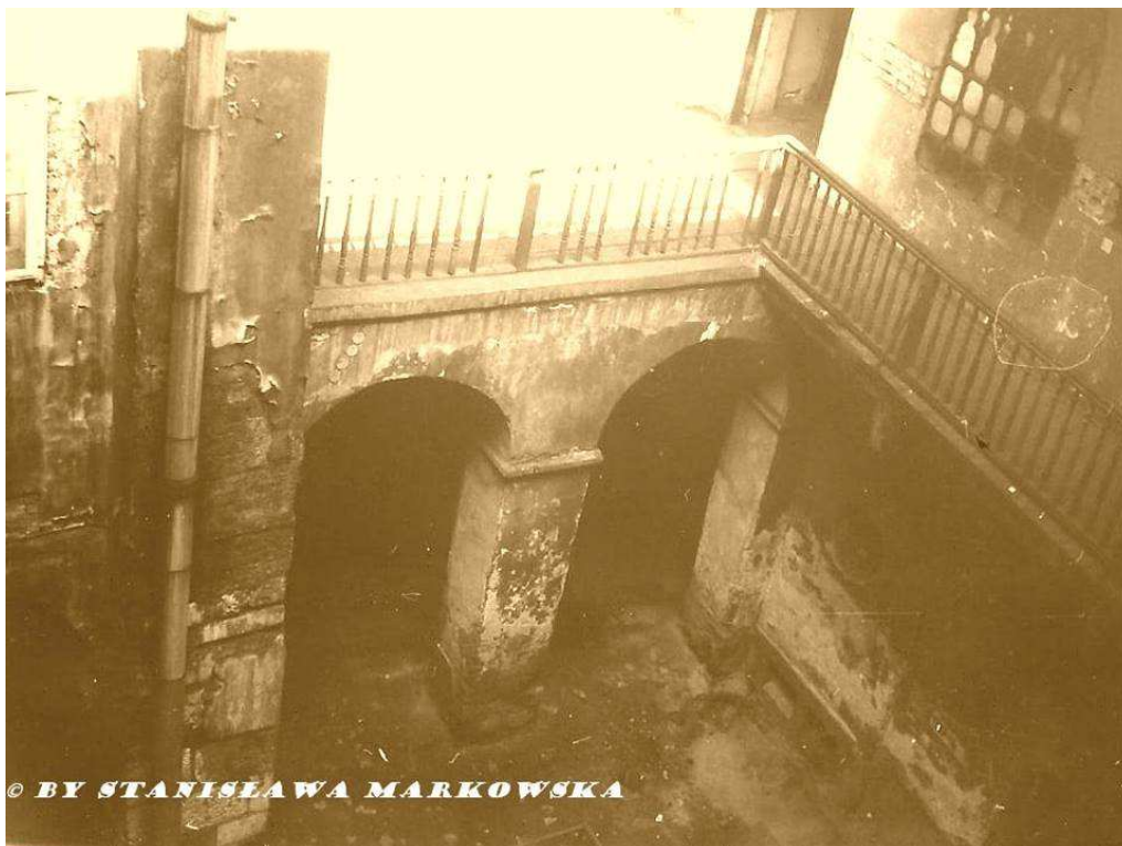
Fot. nr 6 (6-7). Widoki z góry (II. piętra) na podwórko.
