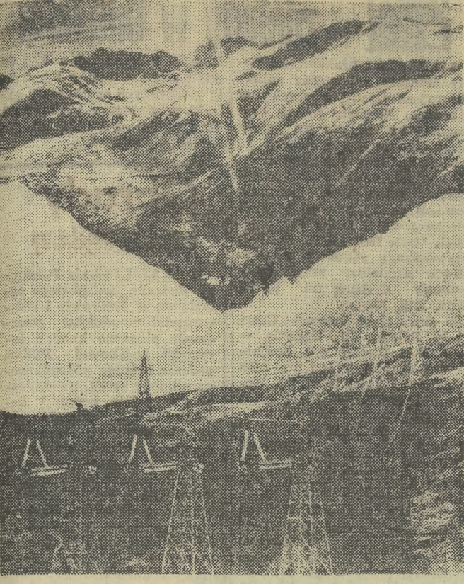
Rosną nowe linie energetyczne w Związku Radzieckim. Na zdjęciu: nowa linia przesyłowa w surowym krajobrazie i klimacie gór Tien-szan w Azji środkowej. CAF — TASS
