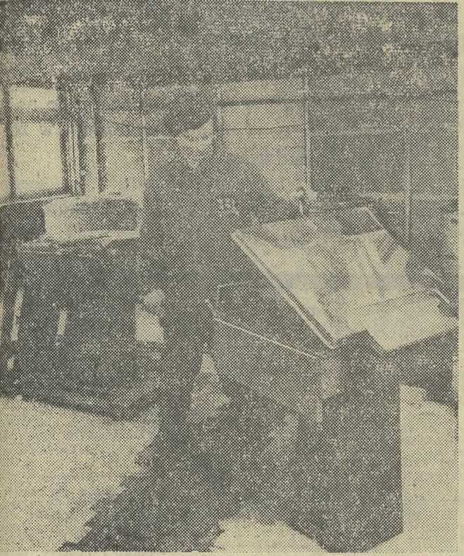
Zaplecze nowej stołówki będzie dobrze wyposażone. Trwa montaż pieców, kotłów oraz widocznych na zdjęciu specjalnych obrotowych palenisk.
