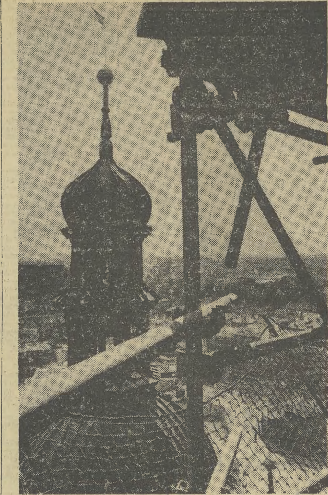
Zdjęte z wieży hejnałnej kościoła Mariackiego w Krakowie korona i bania zostały w PKZ-ach w Warszawie oczyszczone i zakonserwowane. Po powrocie do Krakowa w tutejszych PKZ-ach pokrywa się je kilkoma warstwami zabezpieczającymi, przed położeniem nowych plątków złota. Po wszystkich tych zabiegach korona i bania wróca na szczyt hejnałnej wieży, która nadal znajduje się w remoncie. Zdjęcie wykonane zostało z rusztowań na wieży z widokiem na stary Kraków, Wawel i Wisłę. Fot. JADWIGA RUBIŚ
