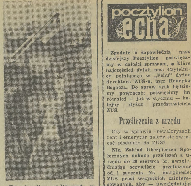
Gazociąg Urengoi-Użgorod w ZSRR. Układanie gazociągu na odcinku od granicy obwodu Tamborskiego do lewego brzegu Donu.
