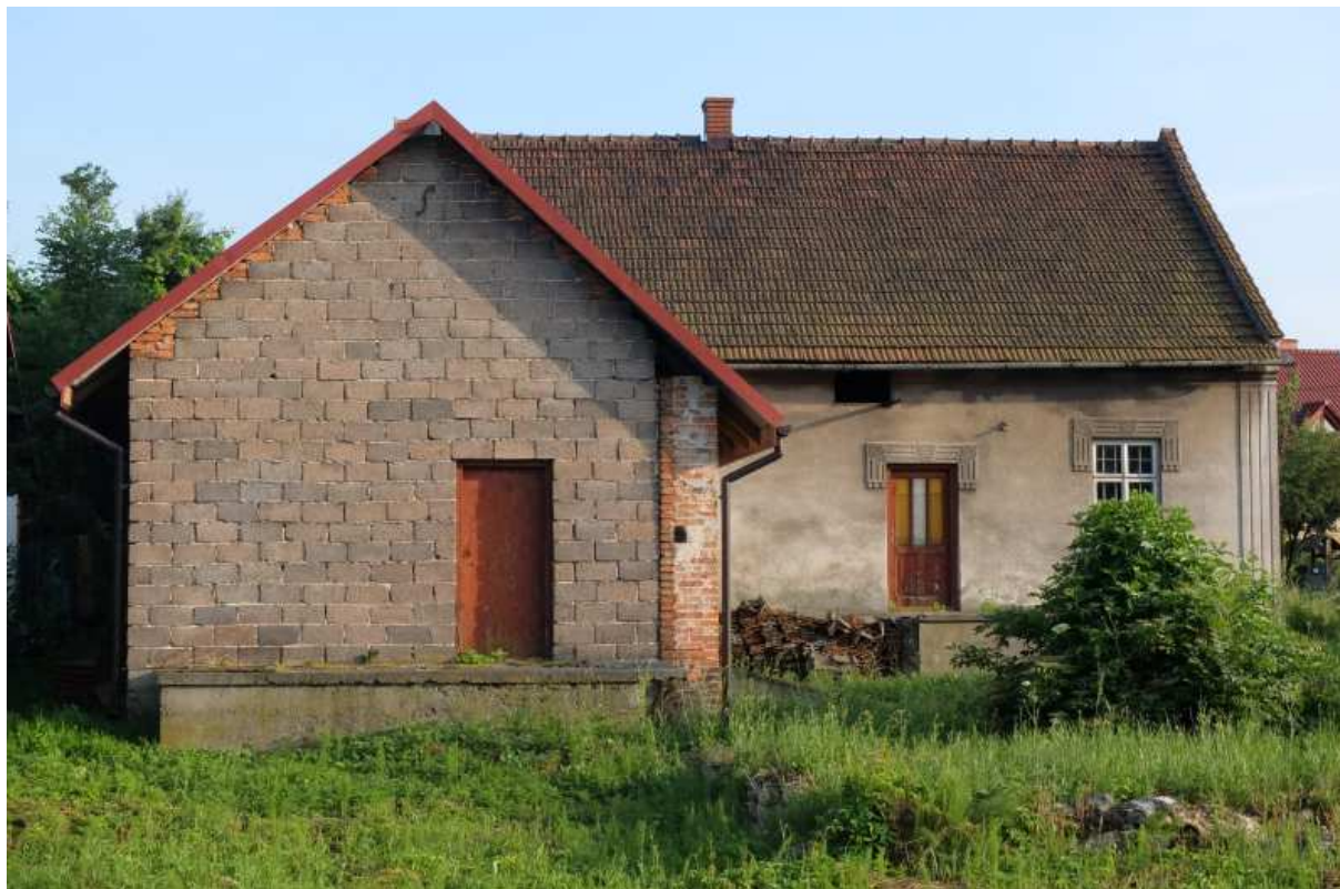
Fot. nr 116. Zapewne jeszcze przedwojenny lub już z pierwszych lat po II wojnie światowej murowany dom pod nr 196.
