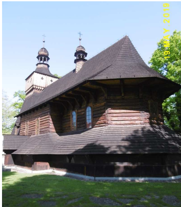
Fot. nr 152. Widok od strony prezbiterium nakrytego gontowym, wielopołaciowym dachem.
