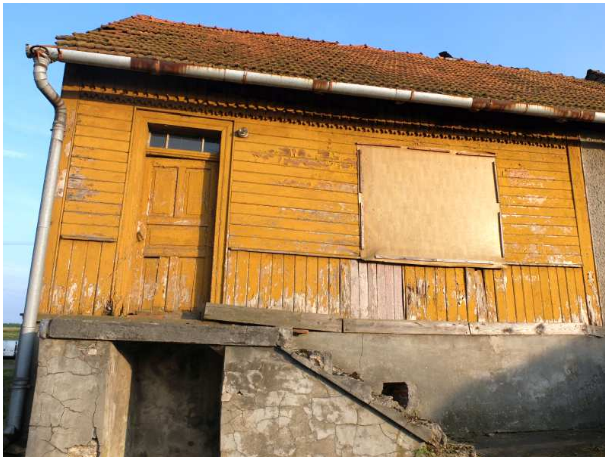
Fot. nr 112. Zachowany do dziś częściowo oryginalny fragment.
