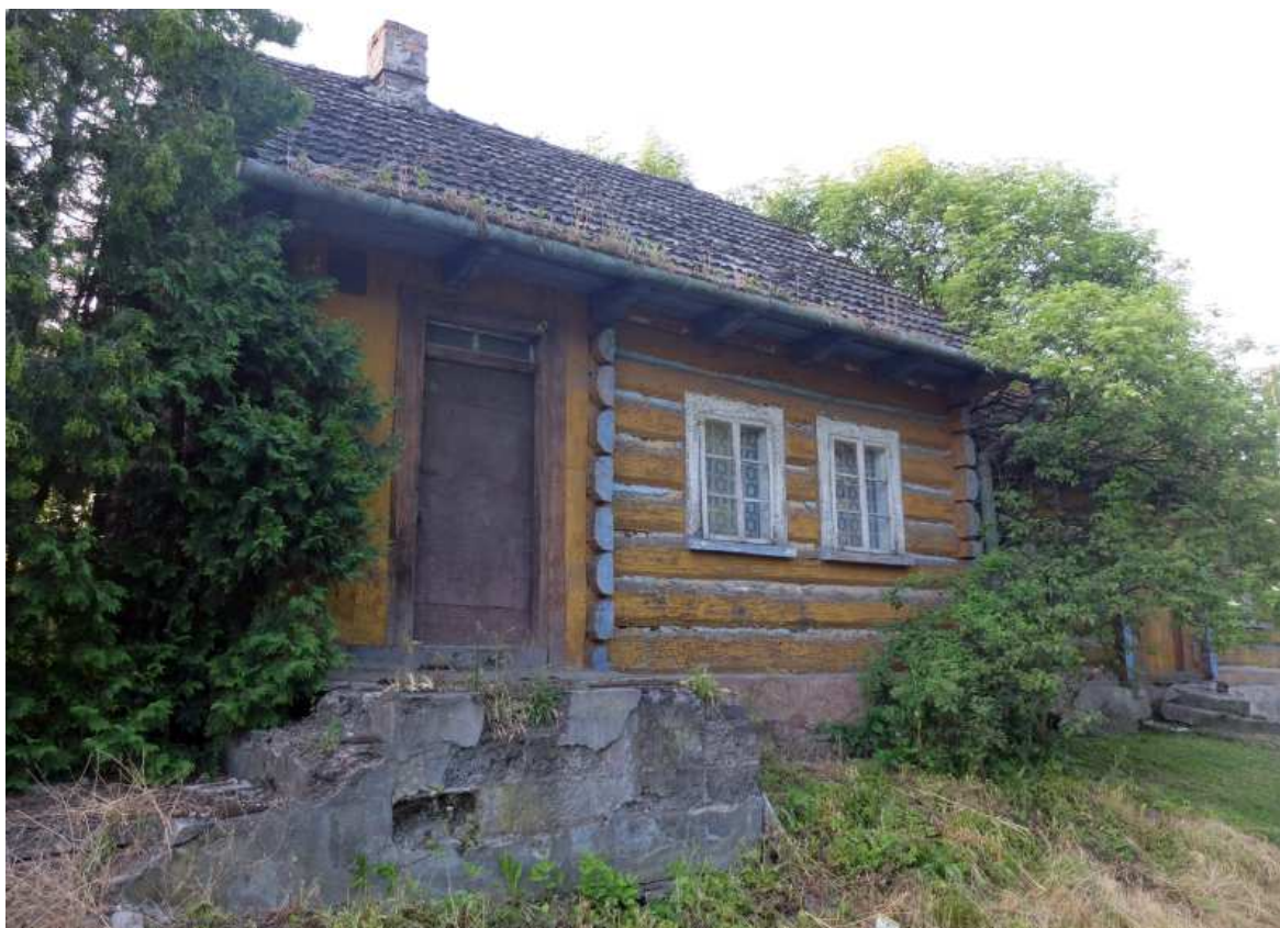
Fot. nr 100 (100-101). Starsza z chałup w kompleksie mieszkalnym, za czym przemawia typ okien.
