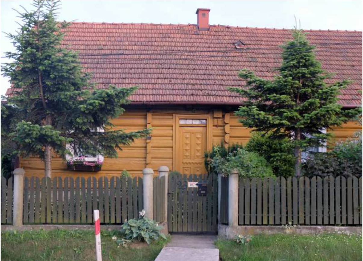
Fot. nr 58. Fragment chałupy spod nr 28. Okna plastikowe, bezpodziałowe, współczesne.
