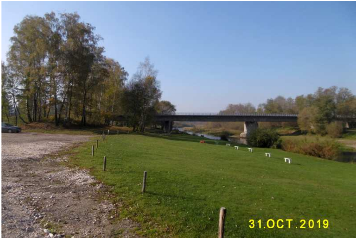
Fot. nr 195. Most przy drodze wiodącej z Gdowa do Łapanowa.
