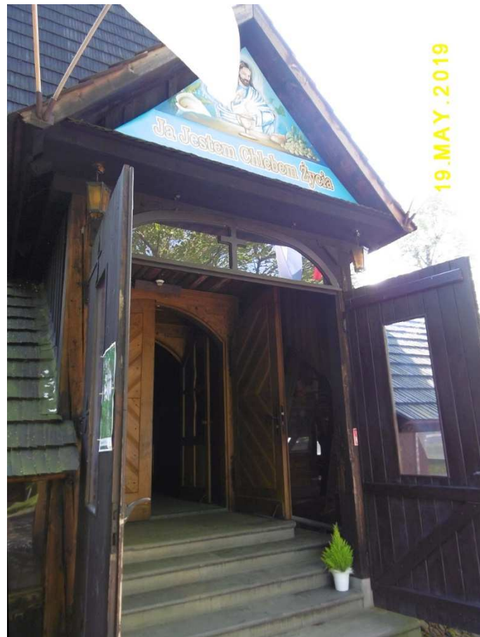
Fot. nr 153. Wejście główne do kościoła.
