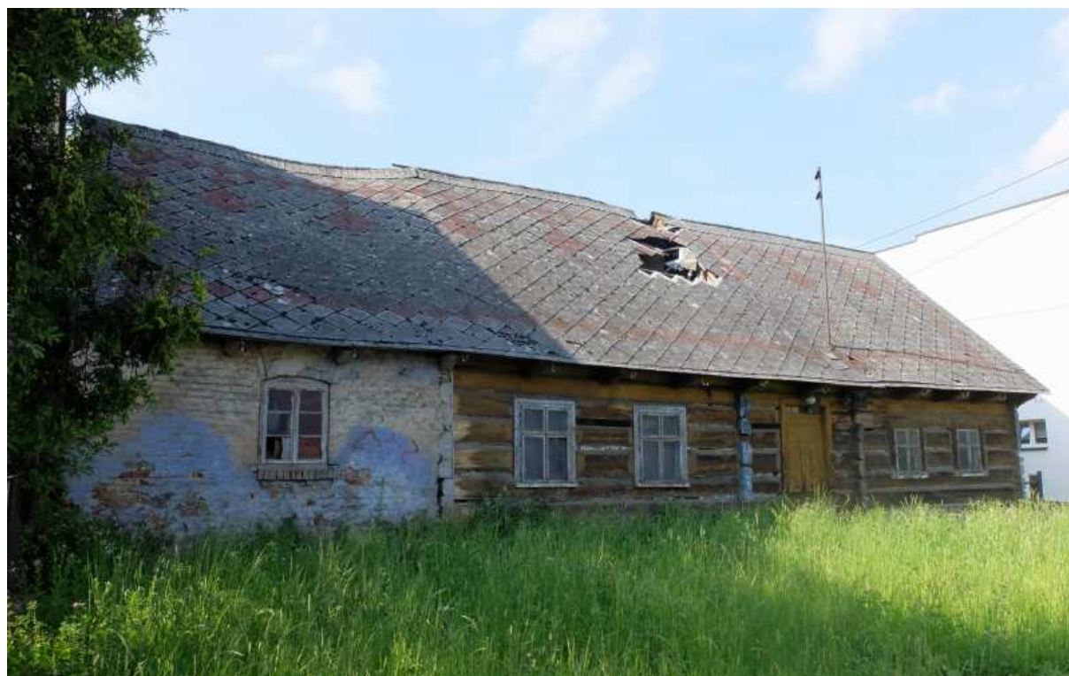
Fot. nr 65 (65-68). Chałupa pod nr 61 i jej detale. Lewy fragment, murowany, zapewne stajnia, późniejszy.
