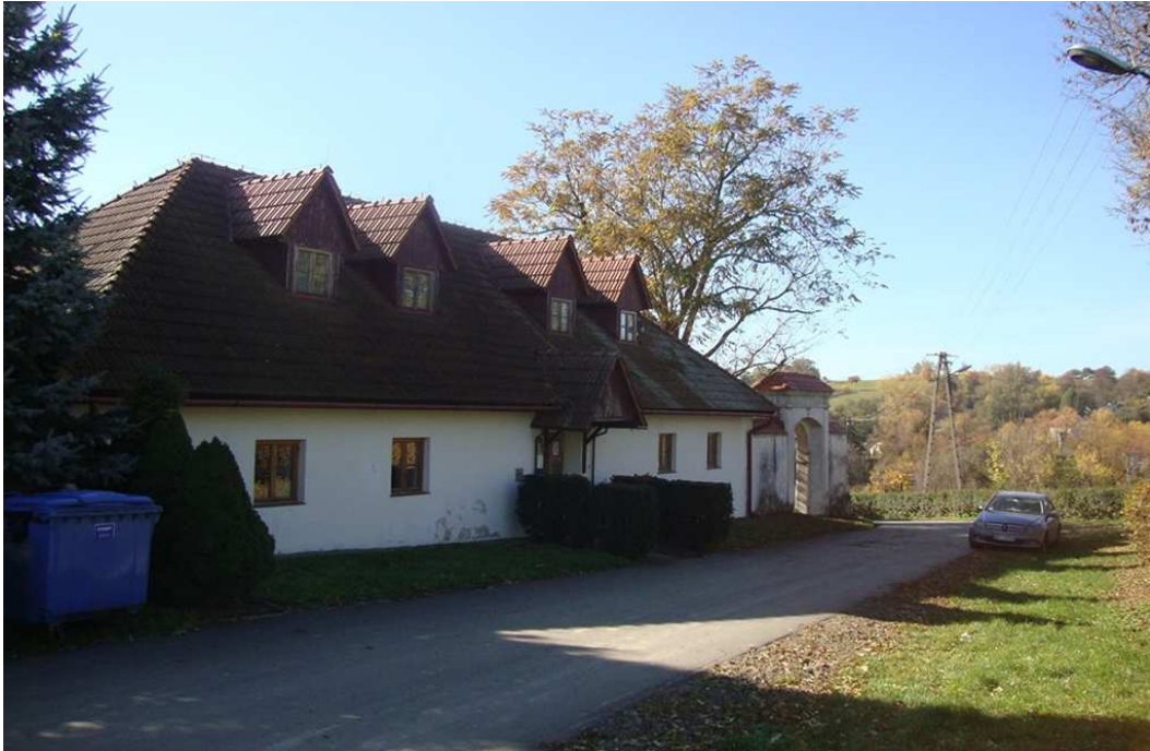
Fot. nr 187 (187-191). Pozostałości po zespole dworskim, XIX-wiecznym majątku Baderów. Tu widok od strony drogi dojazdowej. Dziś majątkiem zarządza UR w Krakowie.
