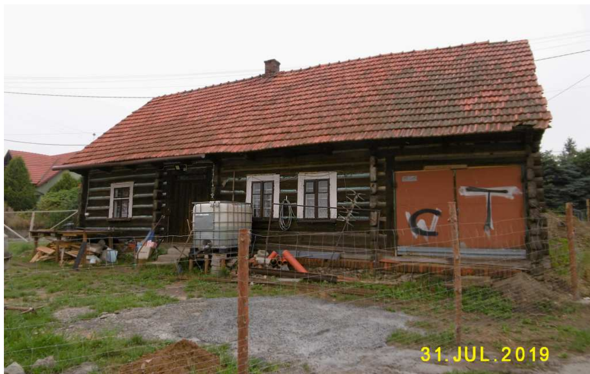
Fot. nr 8 (8-9). Widoki od strony podwórka.
