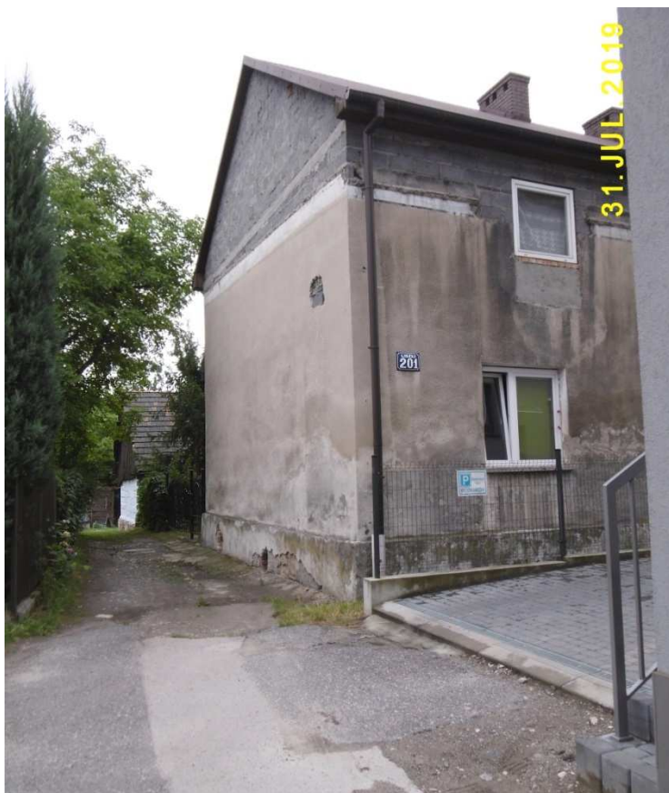
Fot. nr 20 (20-26). Stara chałupa w zaułku niedaleko Rynku, pod nr 201.
