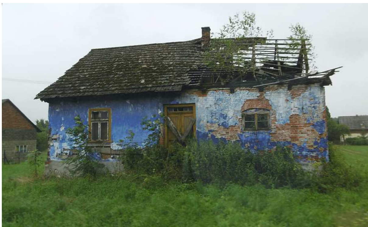
Fot. nr 129 (129-130). Ruina bielonej chałupy spod nr 11. (31.07.2019)
