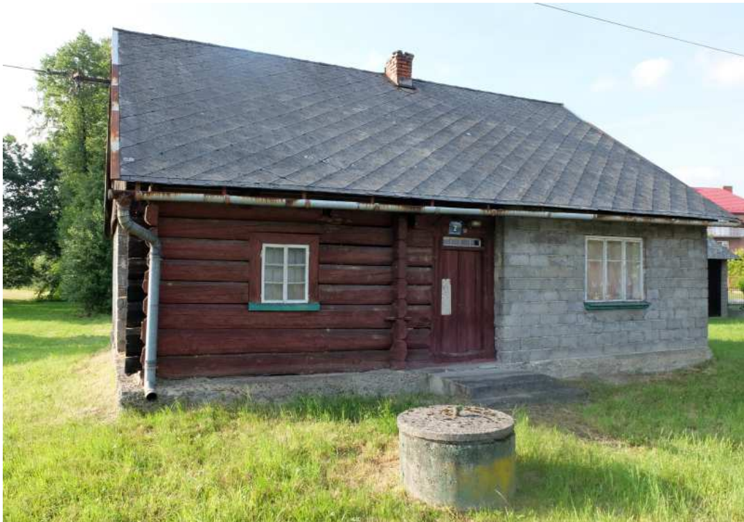
Fot. nr 82 (82-83). Częściowo przebudowana chałupa pod nr 228.
