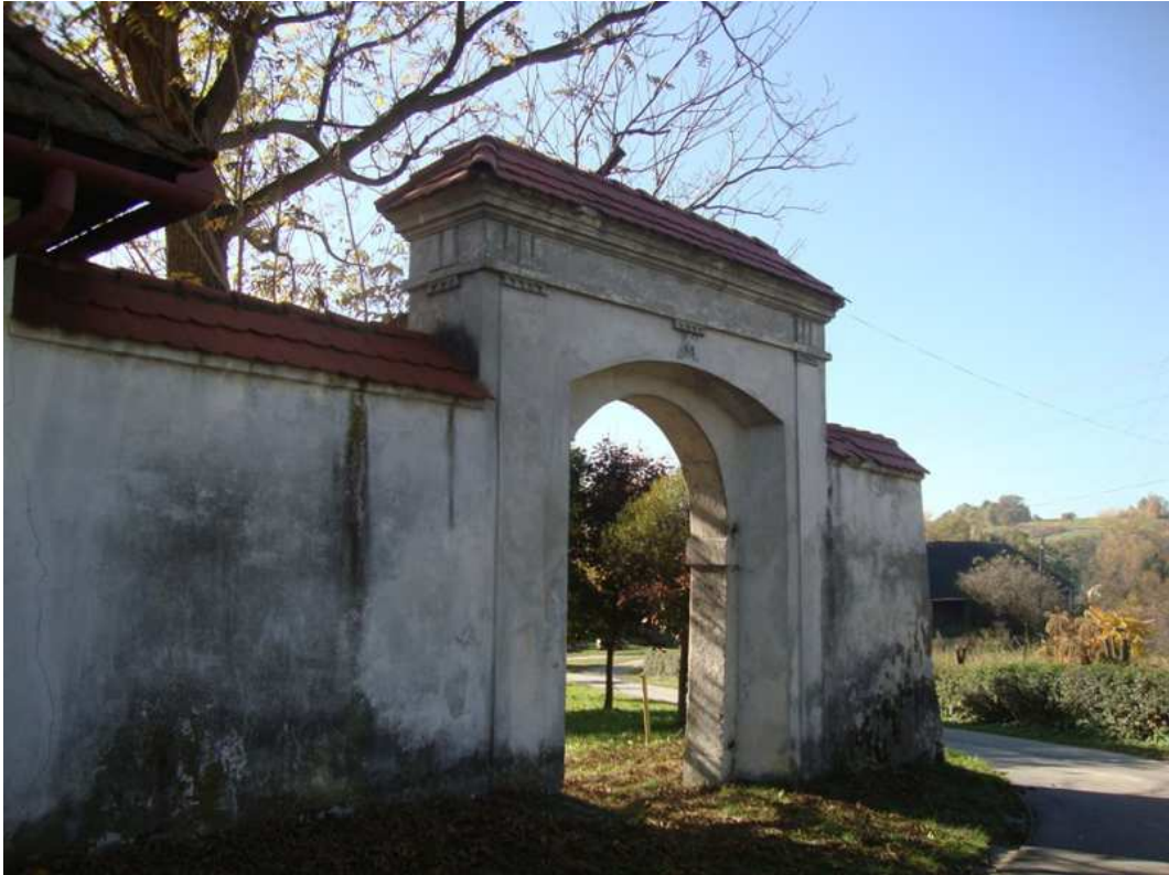
Fot. nr 189. Klasycystyczna brama wjazdowa do dworu.
