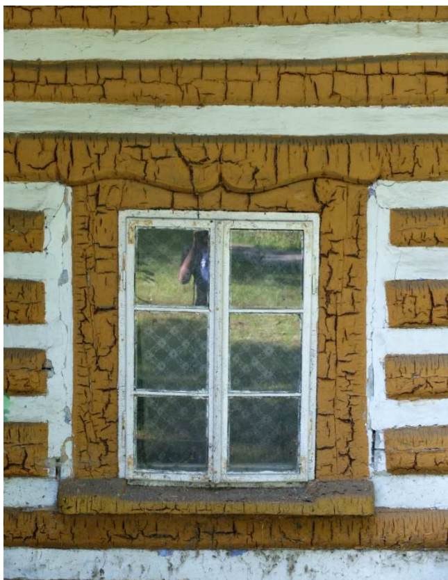
Fot. nr 145 (145-146). Oryginalne okna.
