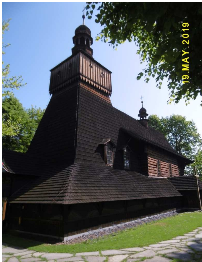
Fot. nr 148. Kościół z wieżą otoczoną izbicą, sygnaturką i ścianami o konstrukcji zrębowej.
