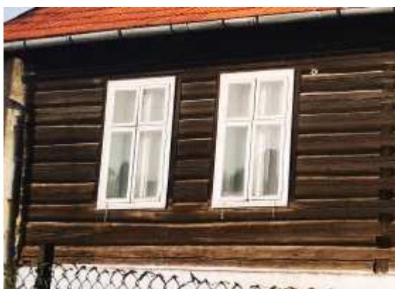
Fot. nr 140. Oryginalne detale fasady.
