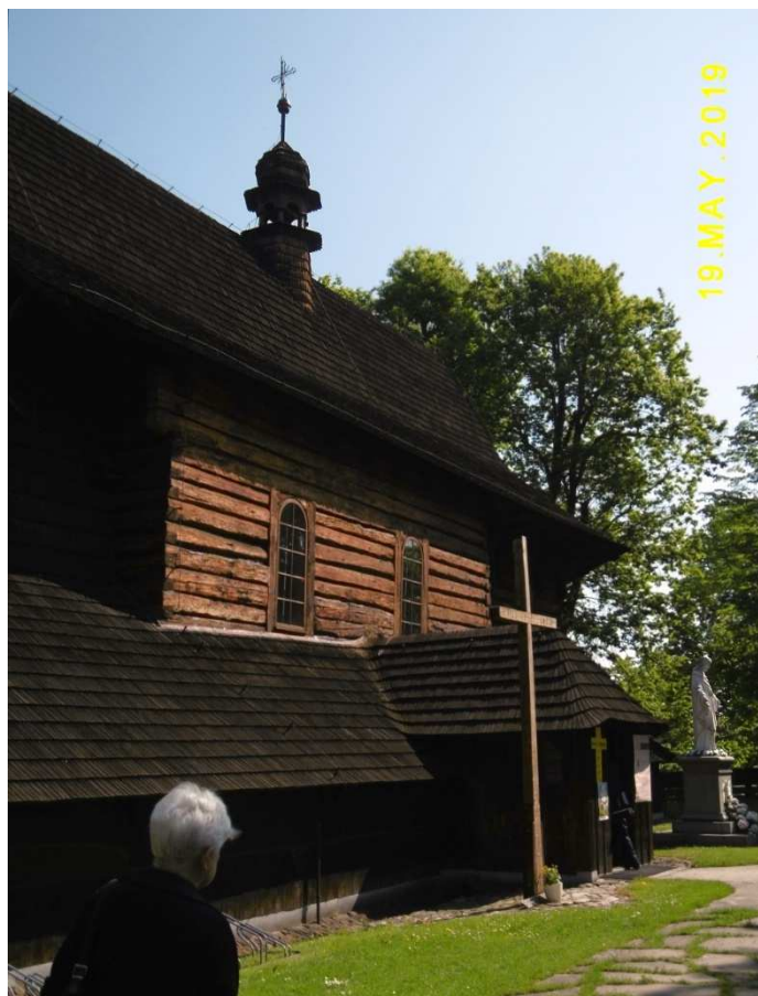
Fot. nr 149. Południowa ściana.
