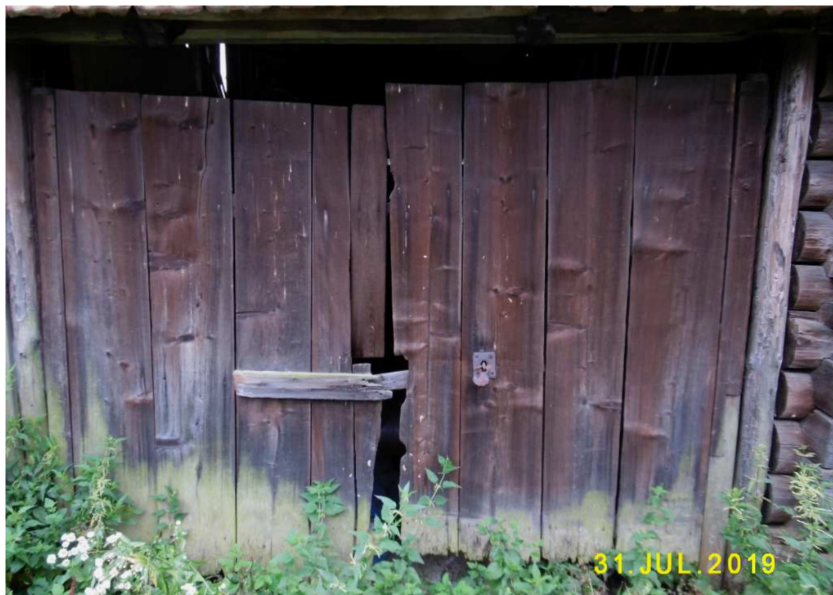
Fot. nr 12 (12-13). Drzwi stodoły z tradycyjnym zamknięciem.
