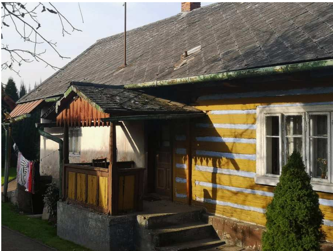
Fot. nr 134. Oryginalne okna i ganek.
