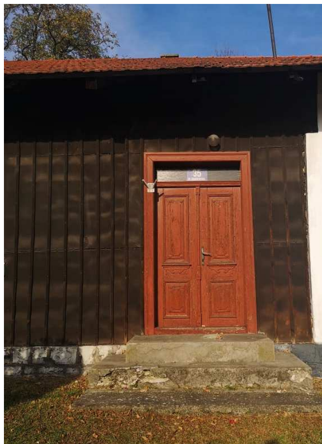
Fot. nr 138. Faktura fasady schowana pod wtórną boazerią.
