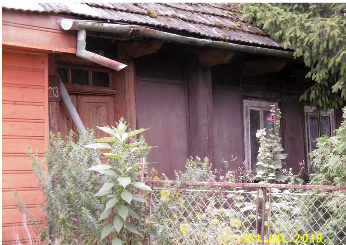
Fot. nr 33 (33-34). Chałupa spod nr 213 z przysłoniętą fakturą fasady.
