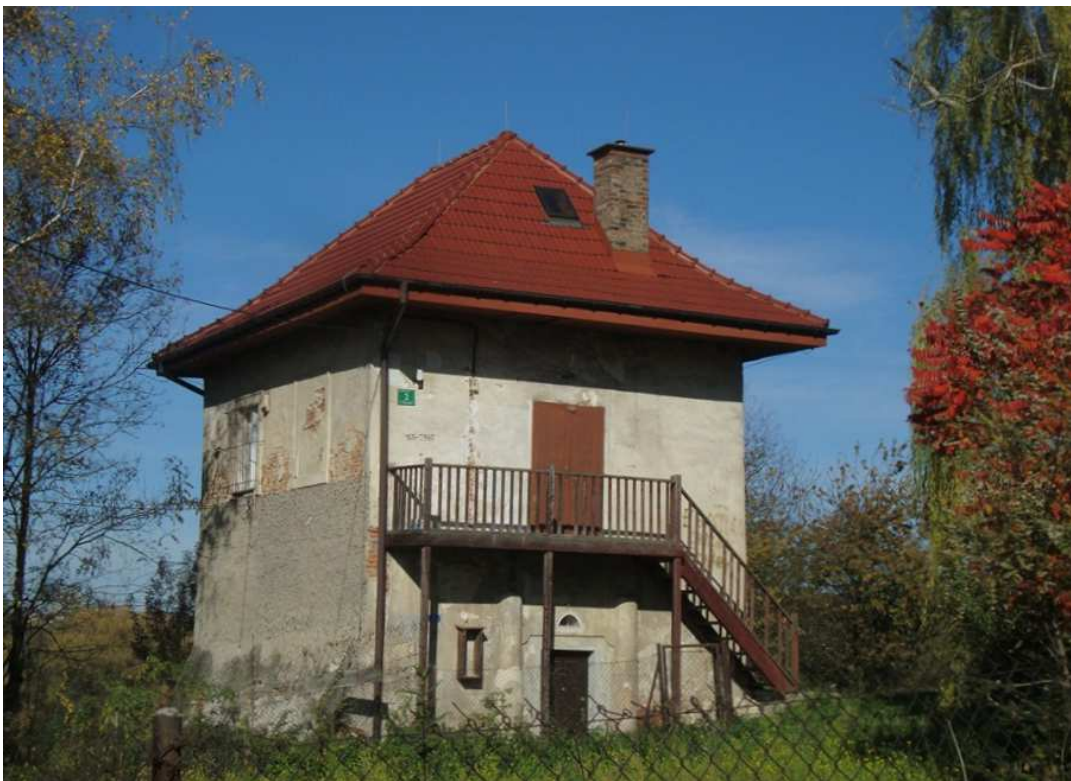
Fot. nr 190. Lamus dworski wybudowany w XVII wieku, który posiada drewniane zewnętrzne schody i galeryjkę na piętrze.
