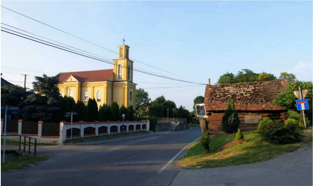
Fot. nr 106. Sceneria wokół kościoła p.w. Matki Boskiej Wspomożenia Wiernych w centrum wsi. Obiekt powstał w roku 1935.
