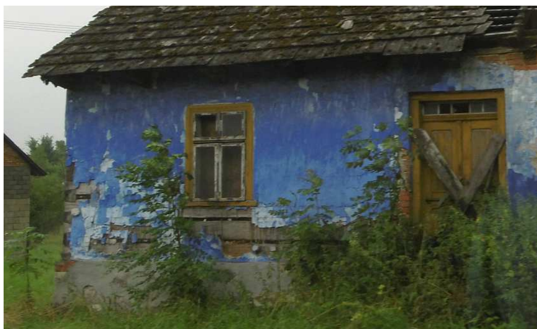
Fot. nr 130. Część mieszkalna. (31.07.2019)
