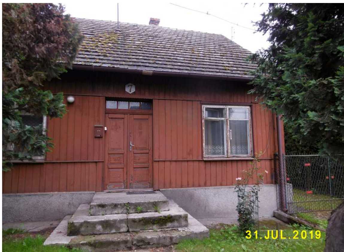
Fot. nr 31. Chałupa spod nr 7.
