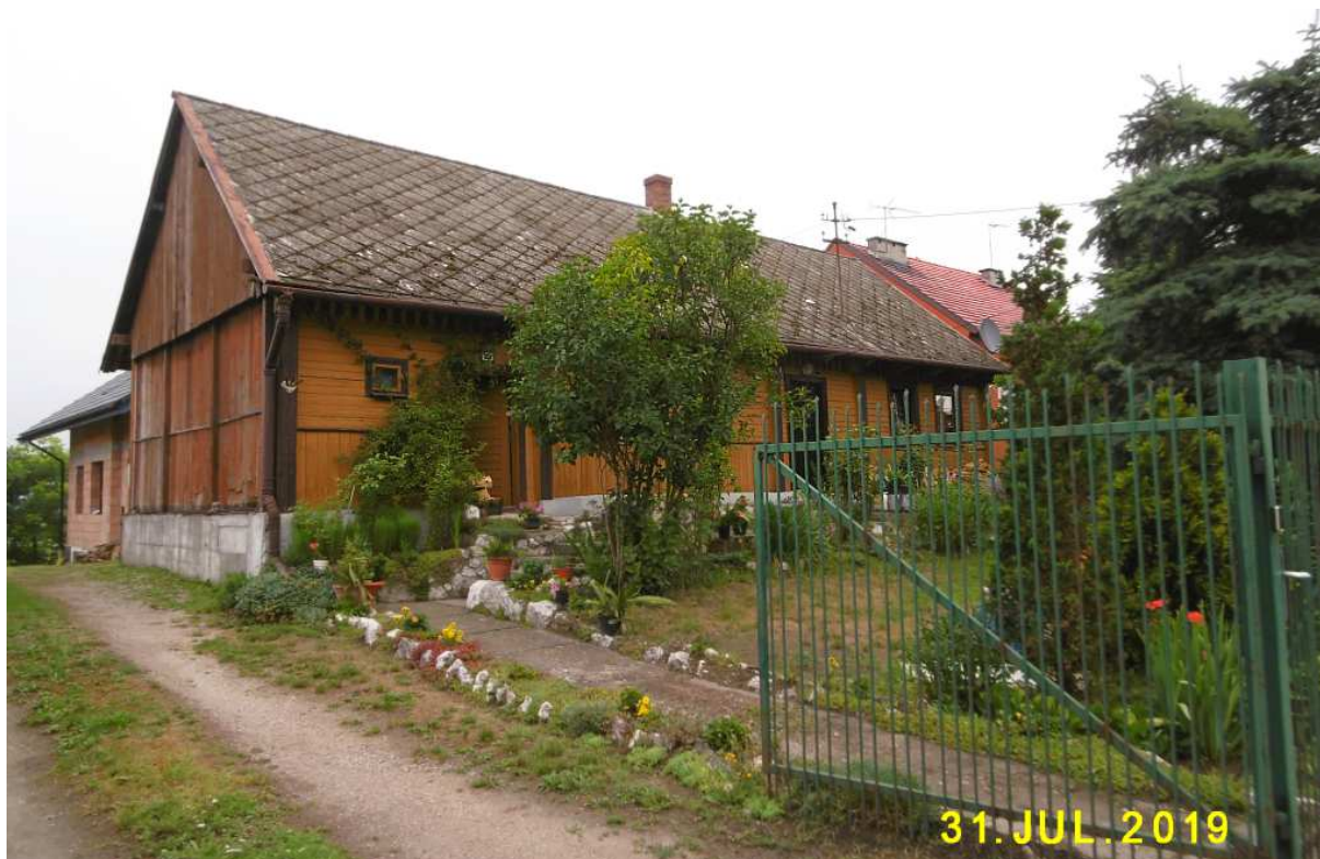
Fot. nr 32. Współcześnie przebudowana chałupa spod nr 155.
