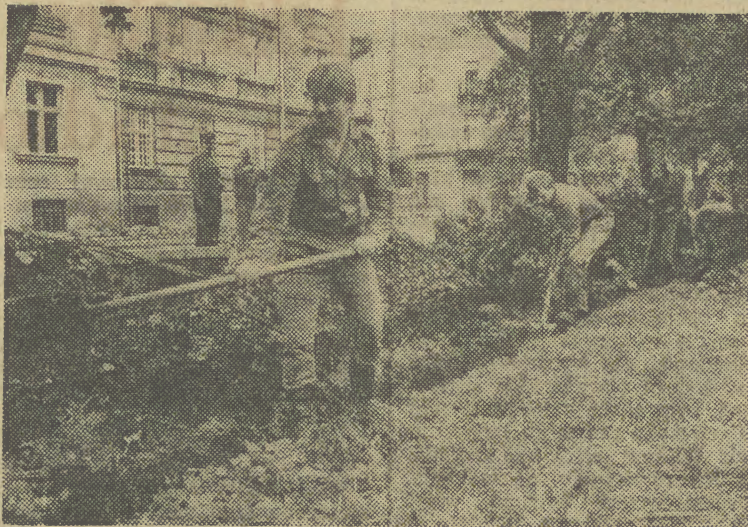
Przy kopaniu rowów i innych pracach dla potrzeb telekomunikacji pracują w Al. Trzech Wieszców funkcjonariusze ZOMO. Fot. ST. MAKAREWICZ
