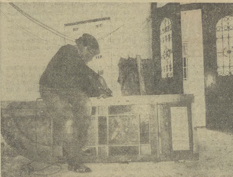
Za chwilę Józef Żółciak zamontuje skrzydło odnowionych, starych drzwi wiodących z holu na schody w kamienicy nr 14. Fot. STANISŁAW MAKAREWICZ
