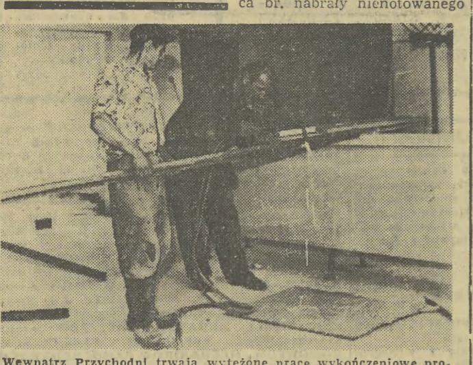
Wewnątrz Przychodni trwają wyłożone prace wykończeniowe...
