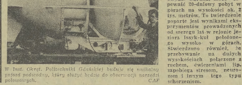
W Inst. Okrę. Politechniki Gdańskiej buduje się unikalny pojazd podwodny, który służyć będzie do obserwacji narzędzi potowocnych.
