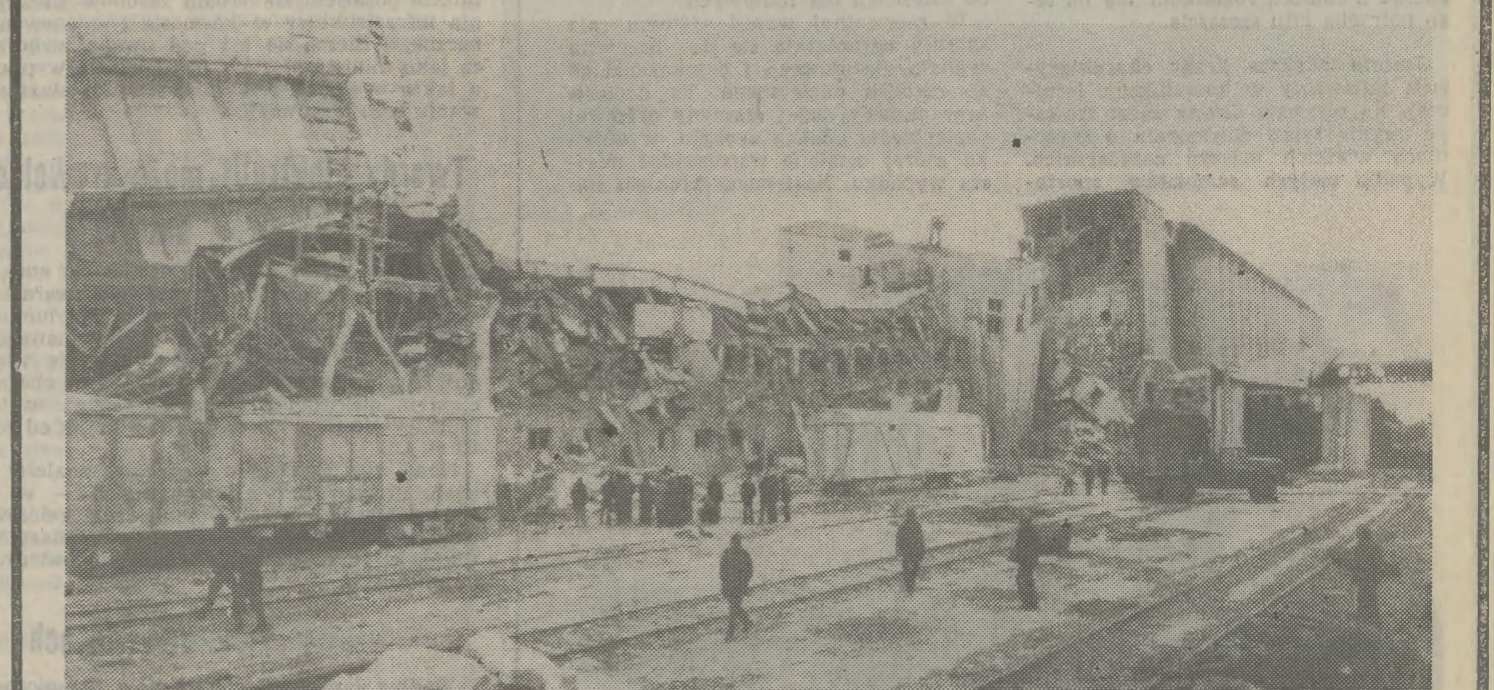
Tak wyglądają budynki zakładów przemysłowych po trzęsieniu ziemi w Armenii.
