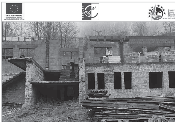
Harbutowice. Systematycznie prowadzona jest budowa centrum kultury. Wymurowane zostały ściany I kondygnacji wraz z wieńcami żelbetonowymi. Trwają dalsze prace murarskie.
