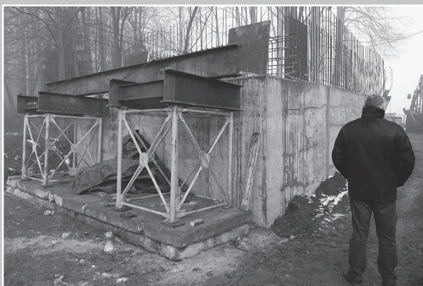
Biertowice. Kontynuowane są prace przy budowie mostu na Skawince. Obecnie dokończono betonowanie przyczółków oraz rozpoczęto prace związane z konstrukcją nośną mostu.
