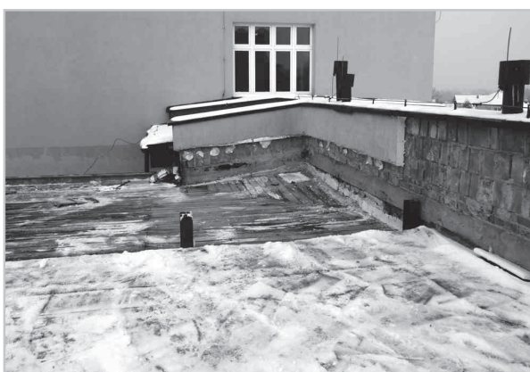
Krzywaczka. Stare pokrycie dachowe jest aktualnie rozbierane. Zamontowane zostały słupy pod nową konstrukcję nośną
