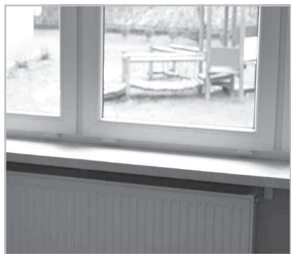
Nowe grzejniki w ZPO w Harbutowicach
