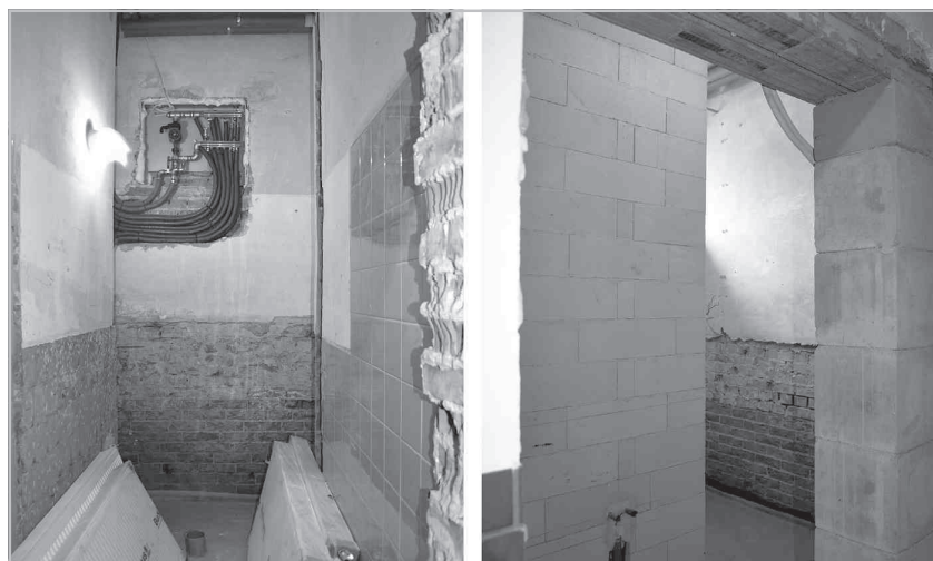
Remont kanalizacji i budowa łazienek dla klas I-III w ZPO w Krzywacze
