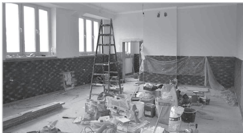
Adaptacja pomieszczeń po starej kuchni w ZPO w Krzywacze
