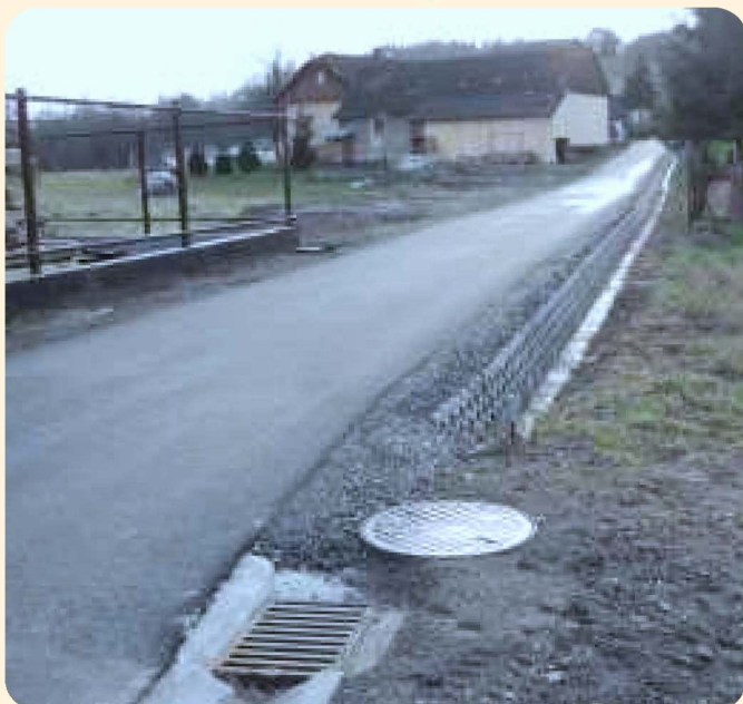
Modernizacja drogi w Biertowicach
