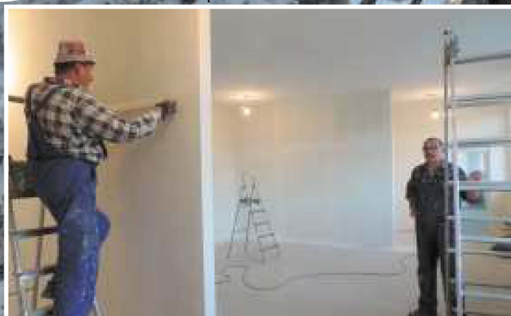
Remont pomieszczeń po dawnej aptece w budynku przed- szkole dla załogi karetki pogotowia w Sułkowicach
