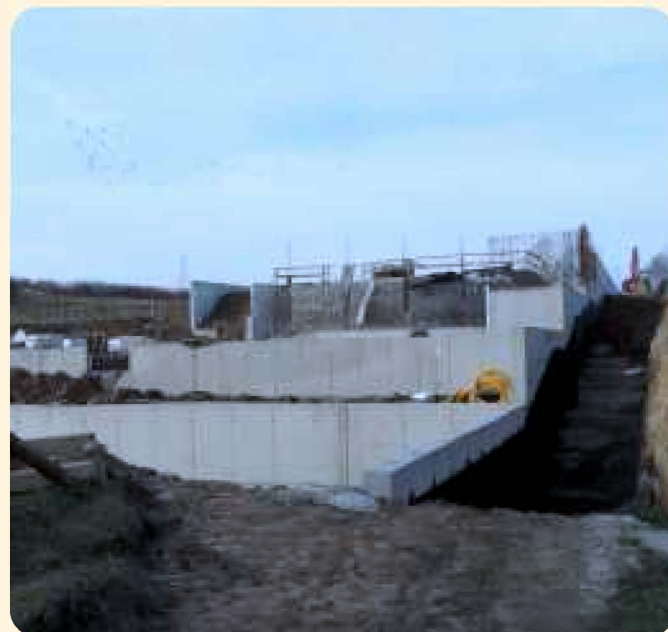
Budowa przedszkola w Sułkowicach
