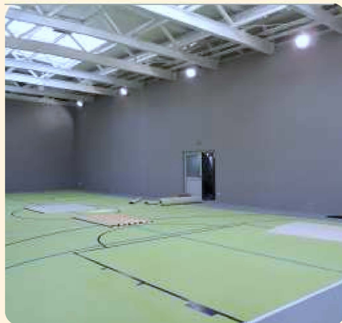
Remont sali sportowej w ZPO w Krzywaczce
