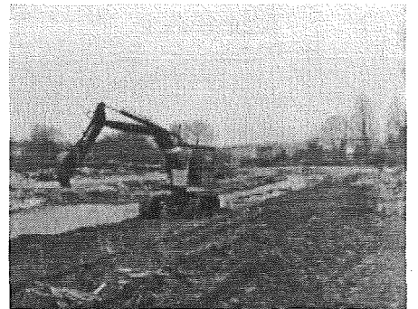
Budowa zabezpieczeń przeciwpowodziowych
