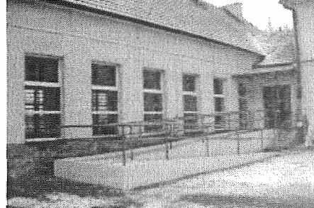
Podjazd dla osób niepełnosprawnych w Szkole Podstawowej w Sulkowicach
