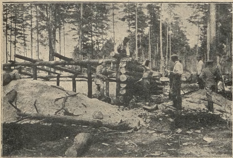
Budowa ziemianek pod Sitowiczami.
