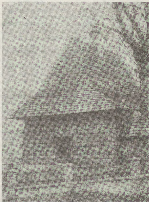
Widok kościoła od strony południowo-zachodniej. Stan obecny. (Ze zbiorów Autora).
