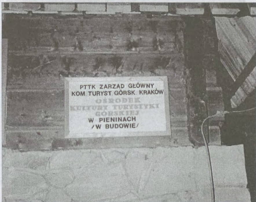
Tablica - Ośrodek w budowie. Zdjęcie wykonane 24. 11. 1986 r.
