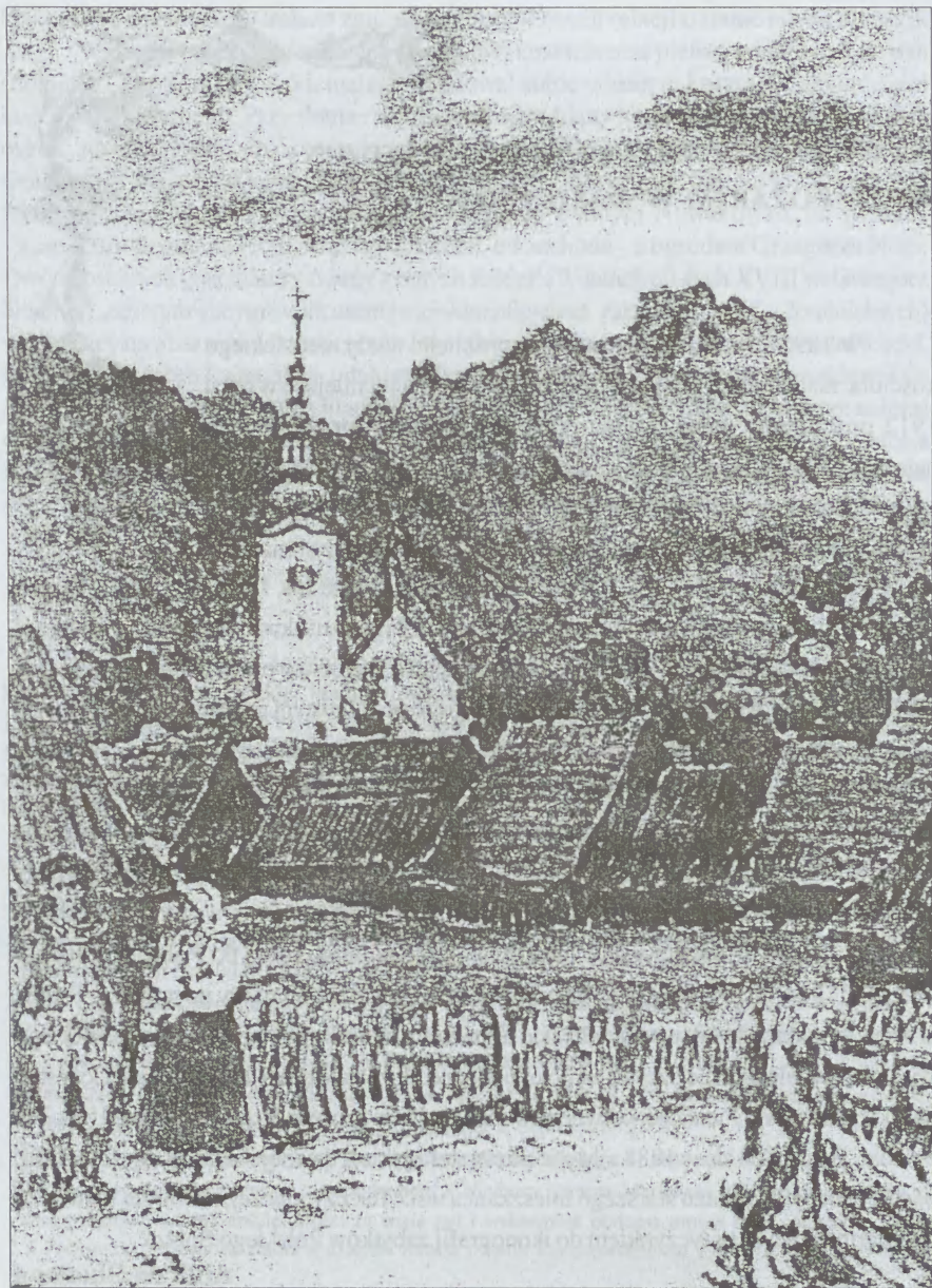
Fragment akwareli J. Pięniżka ukazującej dawną formę helmu wieży kościoła w Niedzicy
