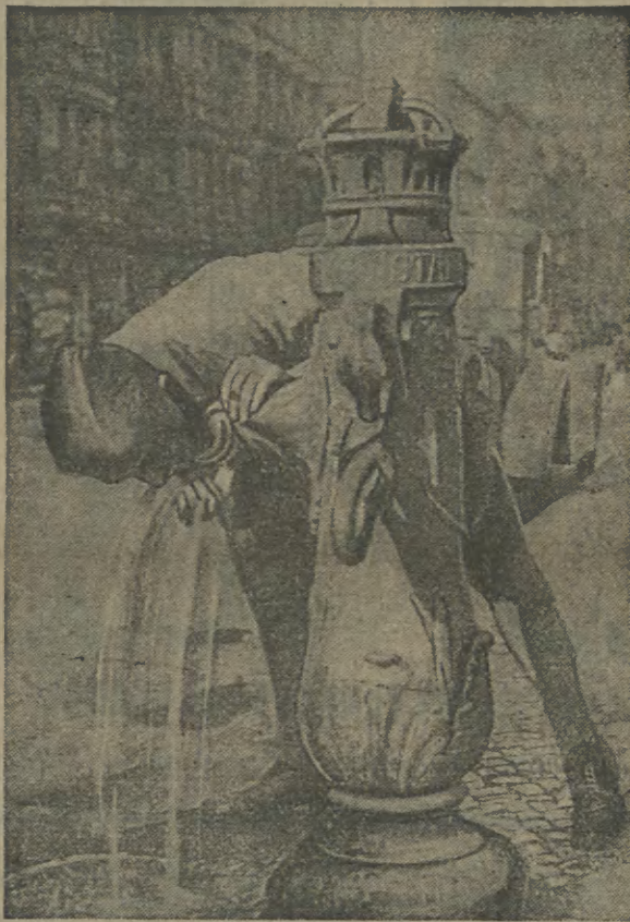
Nie pij wody wprost z kurka studni.
