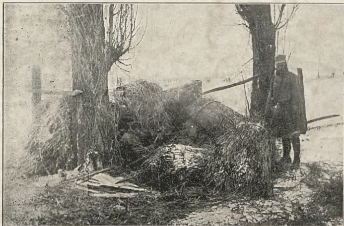
Ziemianki pod Bortnikami.
