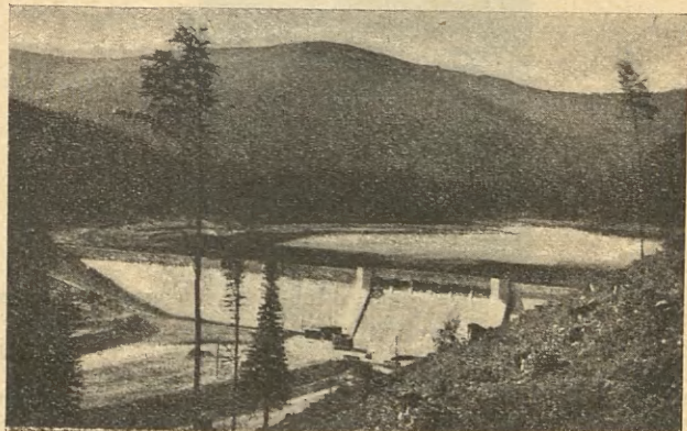
Zapora wodna w Wapienicy.
