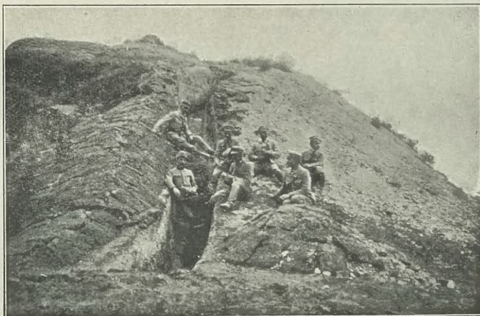
BUDOWA REZERWY OKOPÓW POD KONARAMI.
