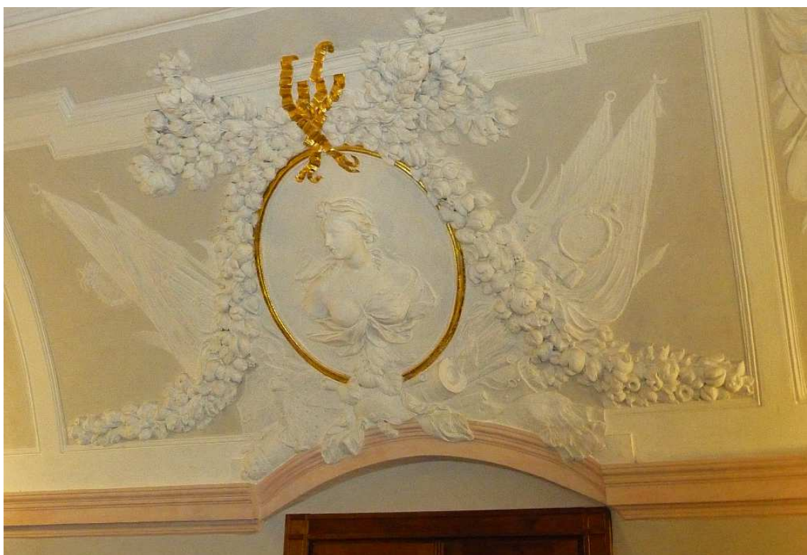
Fot. nr 350. Stiuki nad drzwiami wejściowymi. (21.12.2017)
