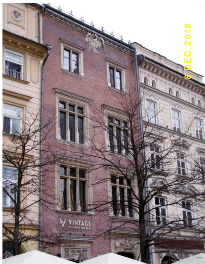
Fot. nr 480 (480-483). Kamienica Pod Orłem spod nr 45 i jej detale.
