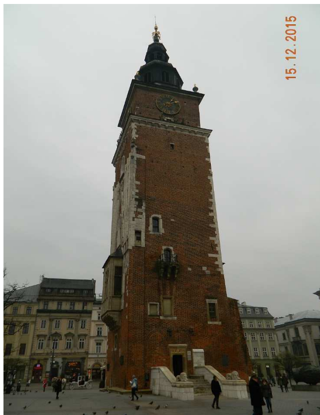
Fot. nr 143. Wieża Ratuszowa – widok od strony linii A-B.
