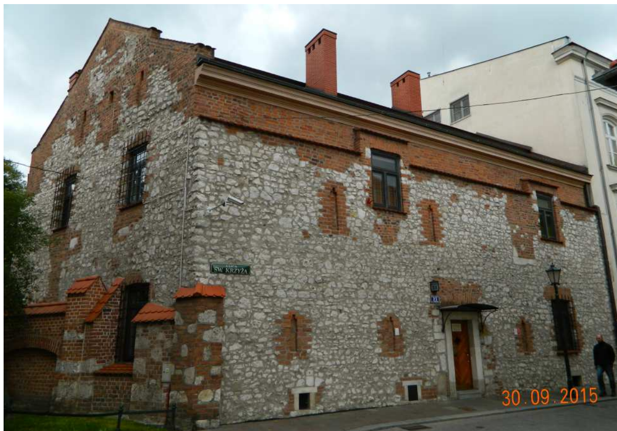
Fot. nr 46. Średniowieczny budynek parafii przy kościele św. Krzyża z ul. św. Marka 23.
