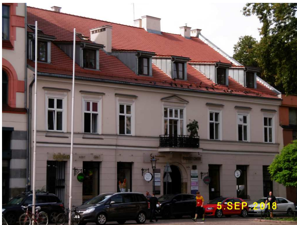
Fot. nr 434. Mocno współcześnie zniekształcona fasada domu spod nr 3 na placu Szczepańskim.
