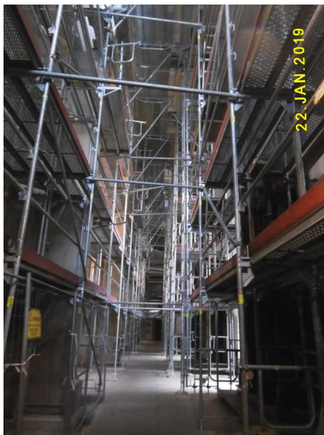
Fot. nr 638. Nawa boczna kościoła Dominikanów na etapie prac konserwacyjnych.
