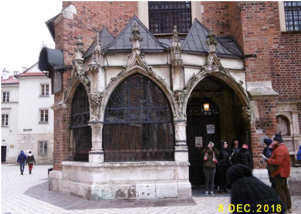
Fot. nr 463. Ogrojec przy kościele św. Barbary.
