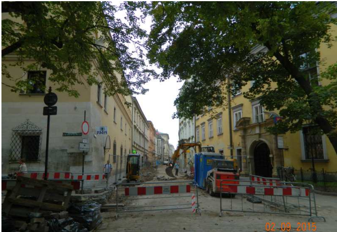
Fot. nr 30. Wymiana nawierzchni ulicy Wiślniej – widok z Plant.
