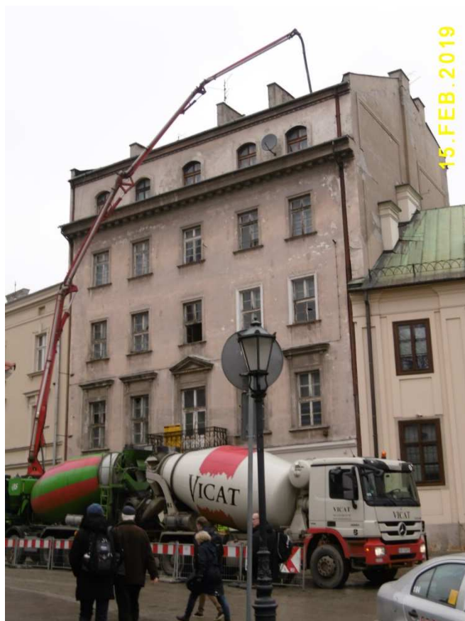
Fot. nr 631. Kamienica pod nr 14 na etapie remontu.
