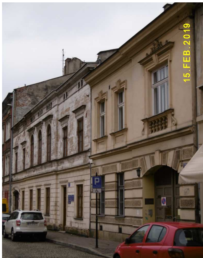
Fot. nr 759. Fragment zabudowy ulicy św. Marka pod nr: 29 i 31.
