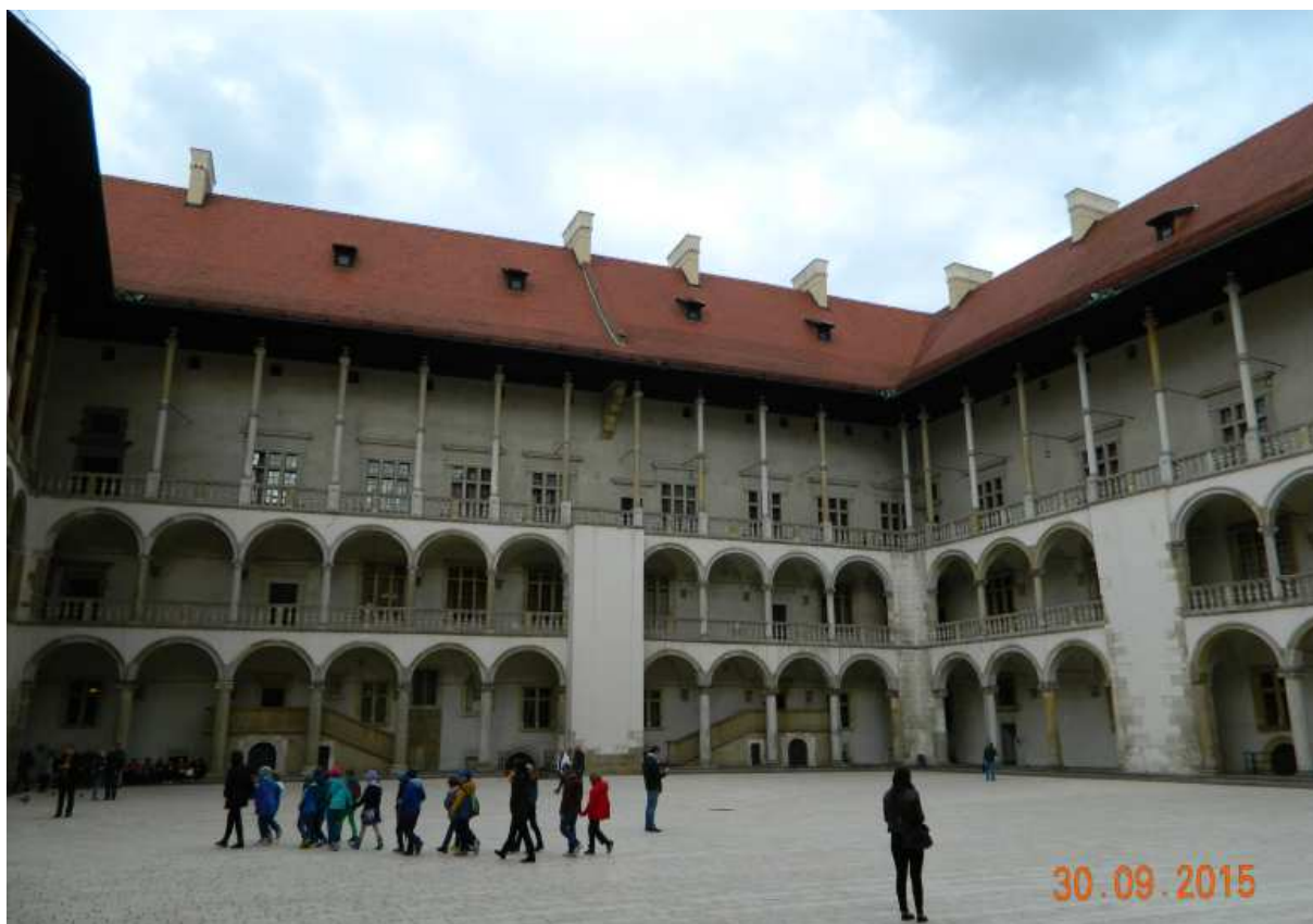
Fot. nr 102. Północno-wschodni narożnik zamku.
