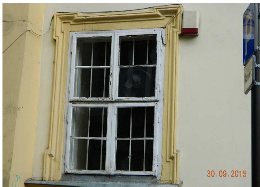
Fot. nr 43. Oryginalne, ośmiopolowe okno, które zachowało się na parterze kamienicy z naroża ulic: św. Tomasza 35 i św. Krzyża 15, charakterystyczne dla klasycystycznej zabudowy Krakowa.
