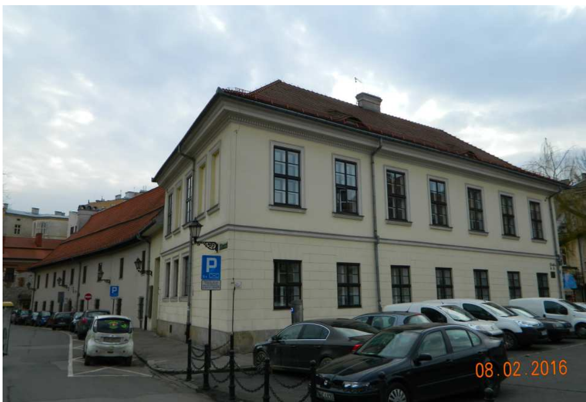
Fot. nr 110. Ostały po wyburzeniach z końca XIX wieku fragment zabudowy placu św. Ducha.
