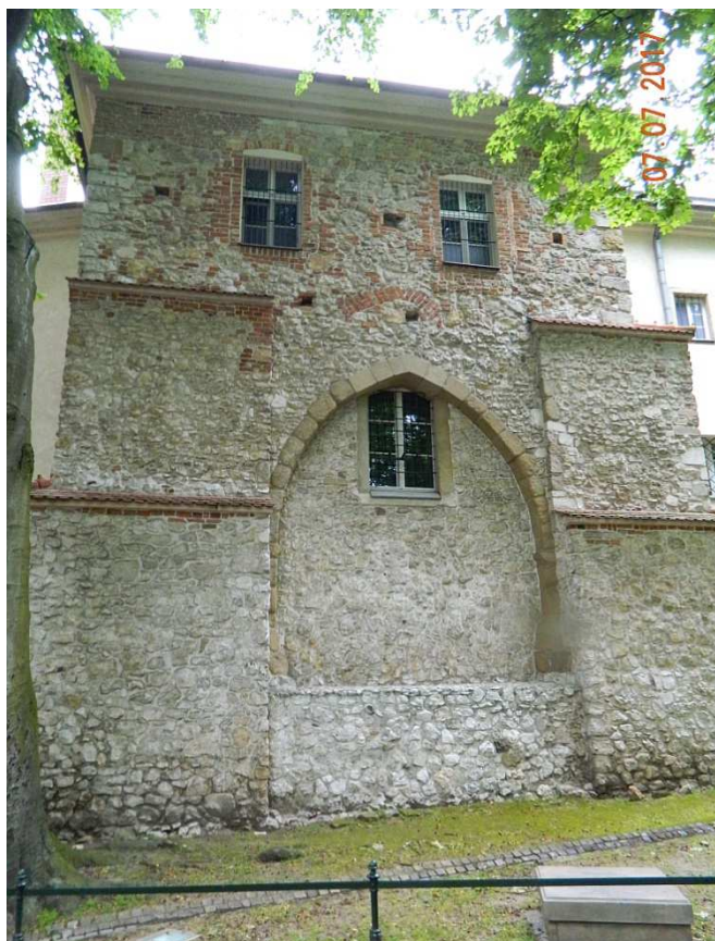
Fot. nr 249. Przedbramie dawnej Bramy Rzeźniczej, pochodzącej z końca XIII wieku, które zachowało się w murach klasztoru Dominikanek na Gródku.
