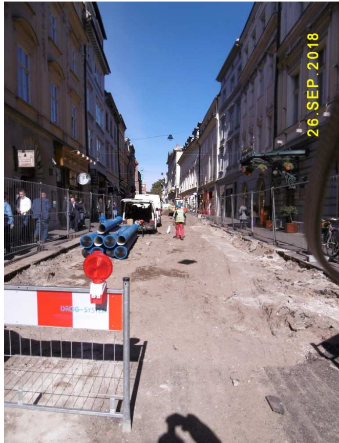
Fot. nr 604 (604-610). Wzdłuż ulicy Sławkowskiej. Etap remontu nawierzchni.
