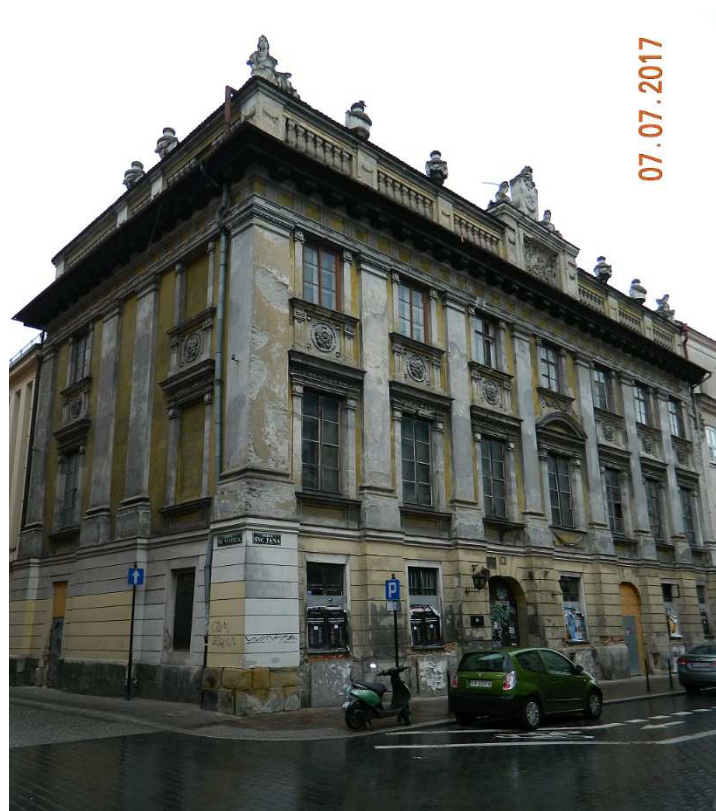
Fot. nr 259. Wczesnoklasycystyczny pałac Wodzickich z ulicy św. Jana 11, który powstał około roku 1780.
