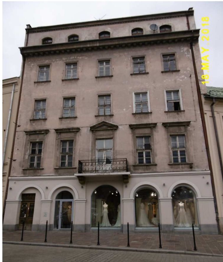
Fot. nr 401. Kamienica pod nr 14 przed remontem.
