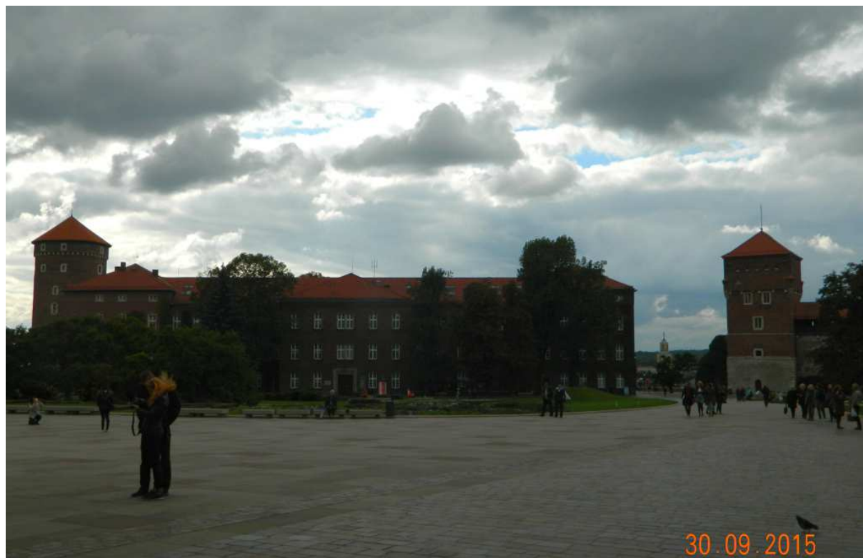
Fot. nr 95. Baszty: Sandomierska (z lewej) i Złotwiejska, a pomiędzy nimi budynek poaustriackiego szpitala.
