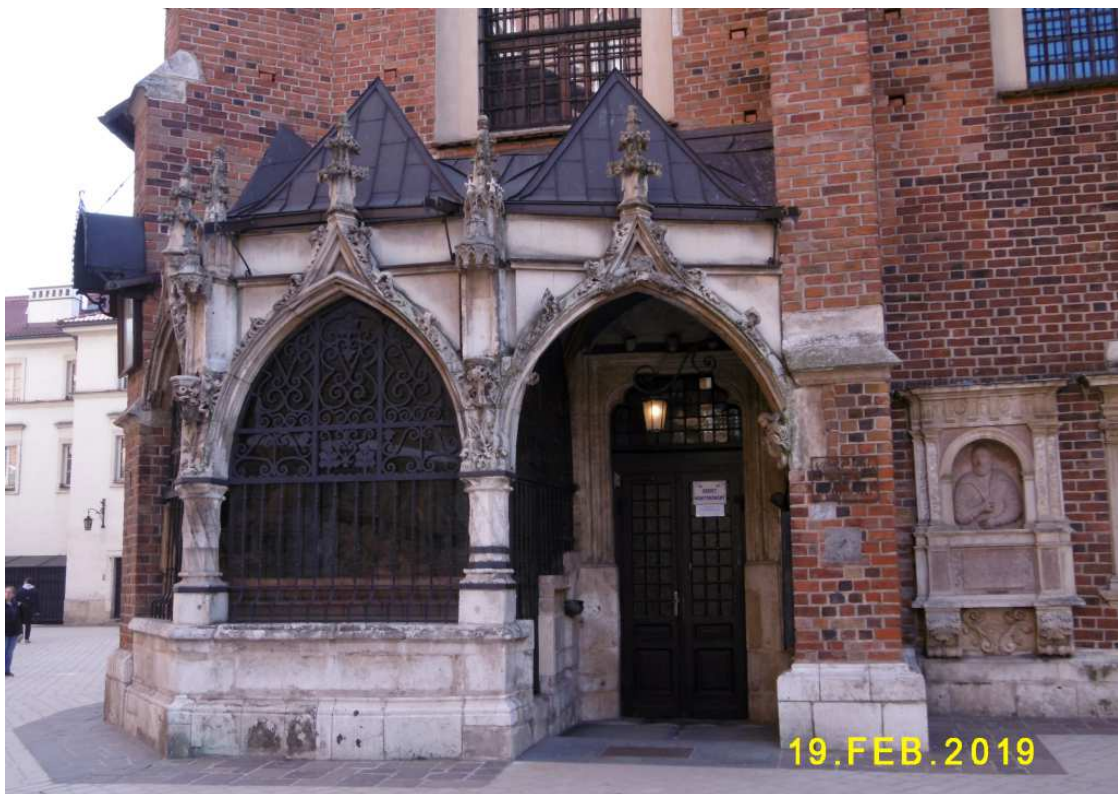
Fot. nr 676. Ogrojec przy kościele św. Barbary.
