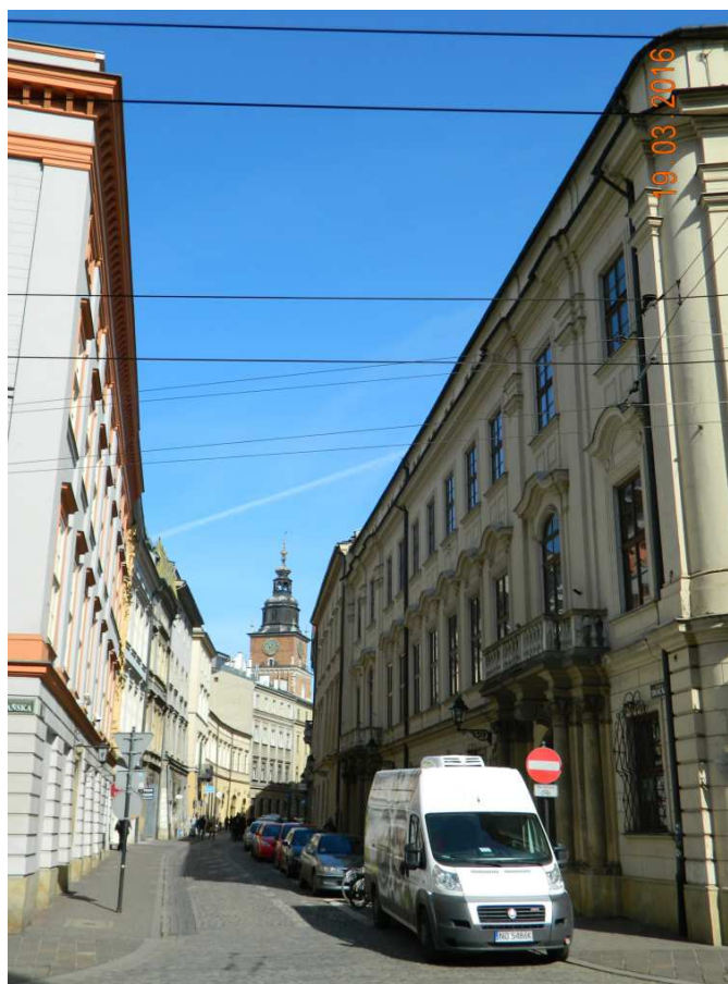
Fot. nr 136. Krzywizna ulicy Brackiej. Widok z ulicy Franciszkańskiej.
