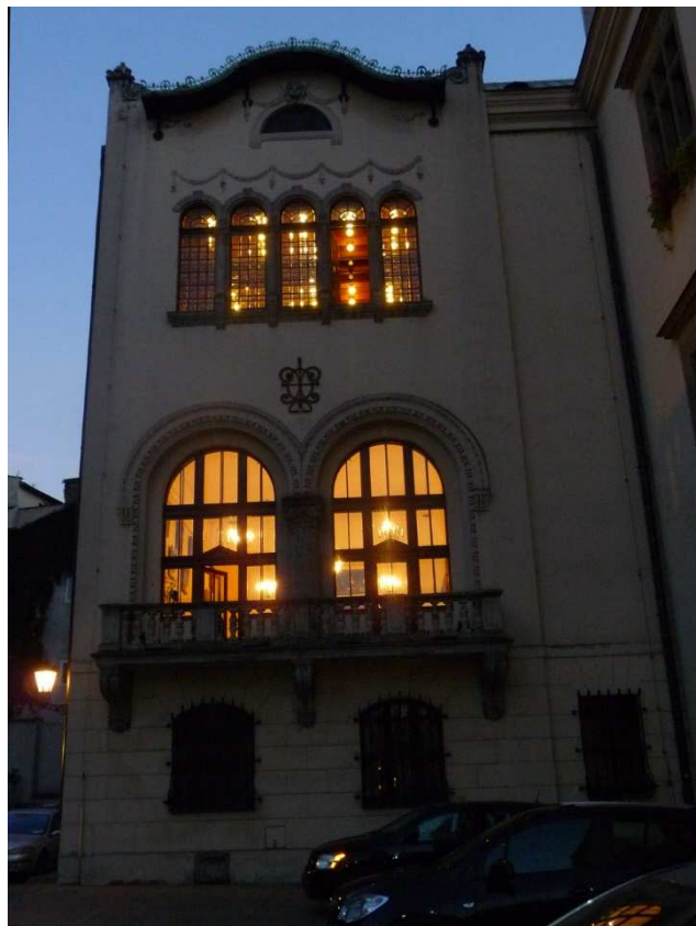
Fot. nr 528 (528-531). Detale pałacu Wielopolskich, siedziby UMK.
