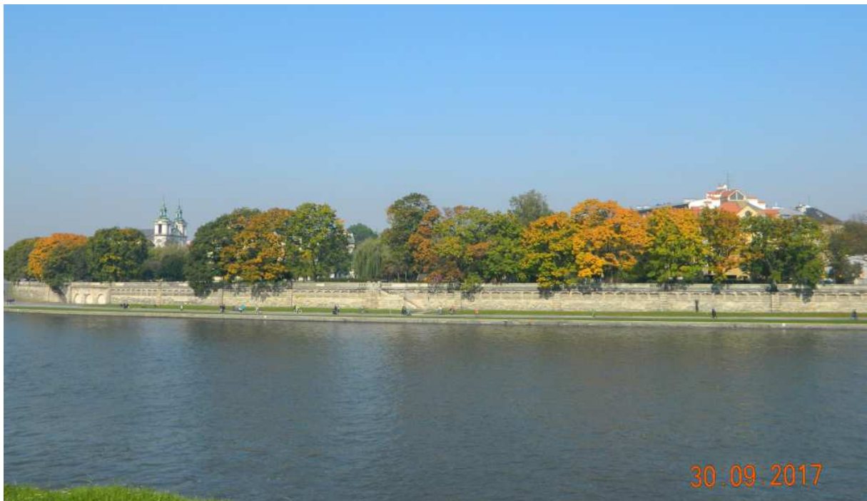
Fot. nr 318. Widok na Bulwar Inflancki na kazimierskim brzegu rzeki.
