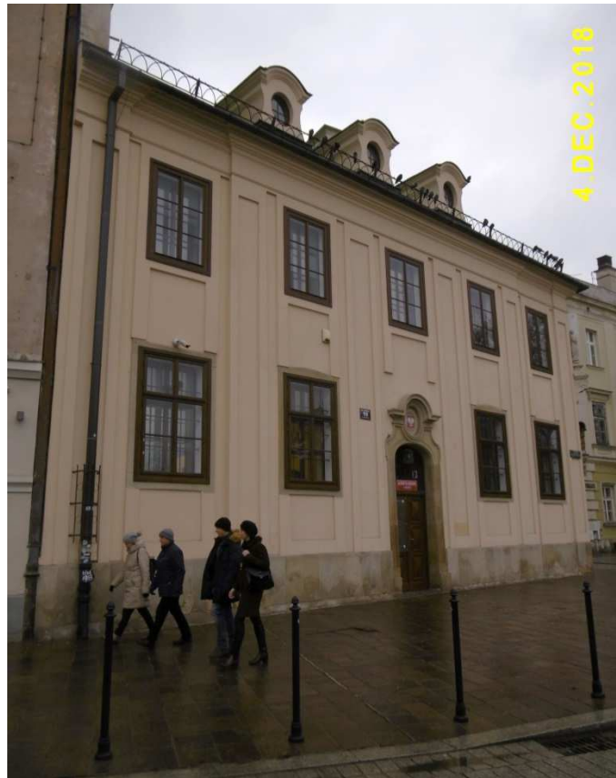
Fot. nr 453. Budynek Archiwum Narodowego w Krakowie przy ulicy Siennej 16.
