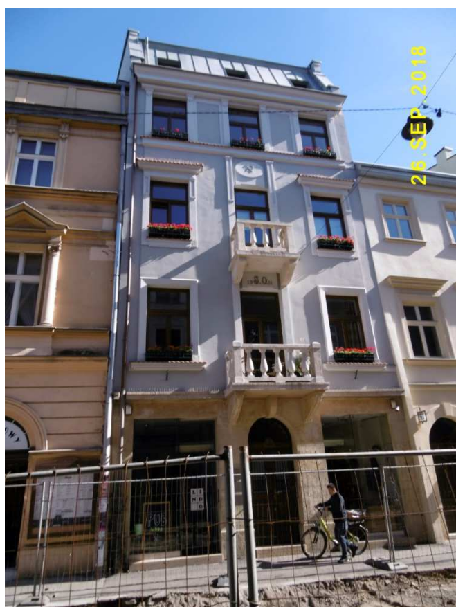
Fot. nr 608. Odnowiona, międzywojenna kamienica pod nr 23.
