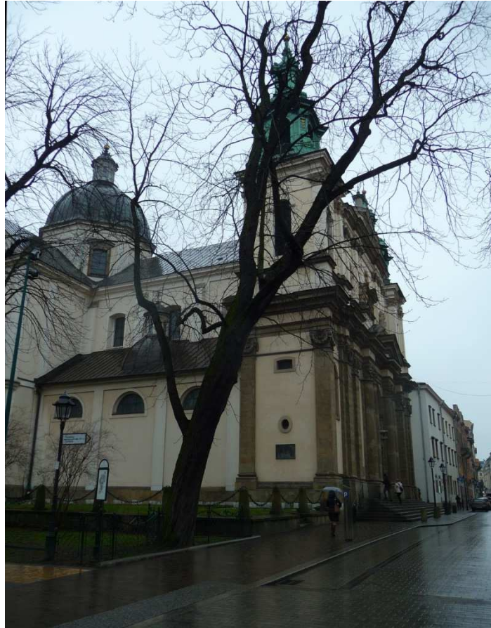
Fot. nr 365 (365-366). Wzdłuż ulicy świętej Anny – widoki od strony Plant. (12.01.2018)
