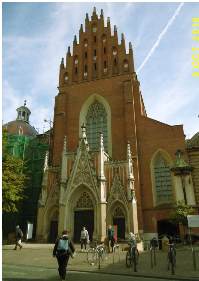
Fot. nr 516. Odbudowana po pożarze z roku 1850 szczytowa ściana kościoła.
