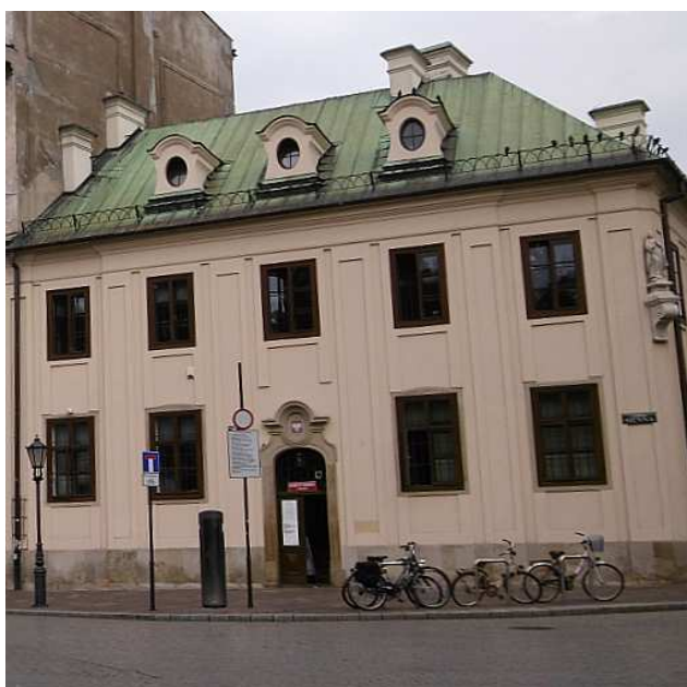
Fot. nr 424. Siedziba Archiwum Akt Dawnych przy ulicy Siennej 16. (05.09.2018)
