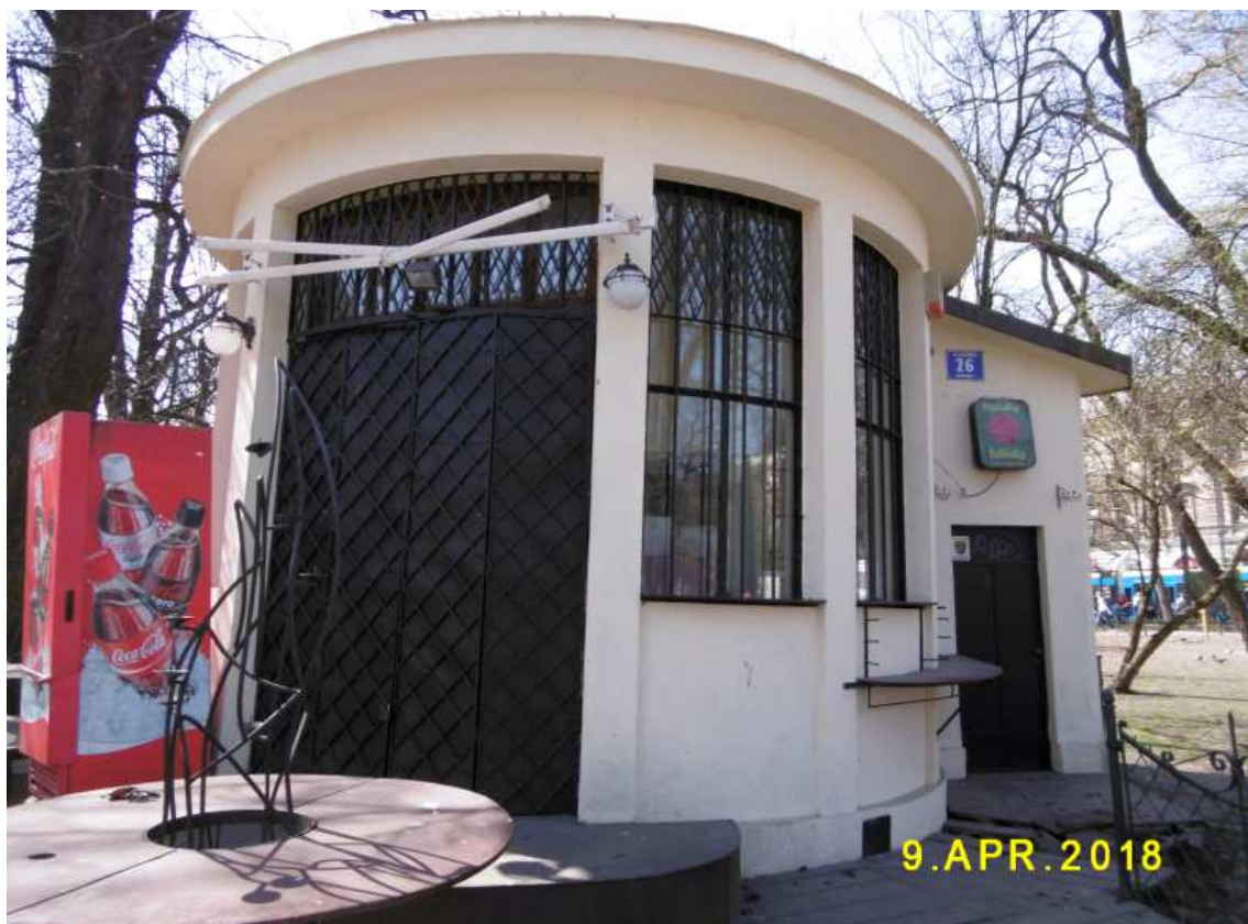
Fot. nr 368. Dawny kiosk gastronomiczny Kajtek u wylotu ulicy Szewskiej. Ma długą i doprawdy ciekawą historię.
