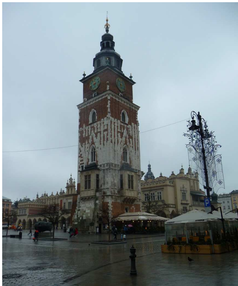
Fot. nr 352. Wieża Ratuszowa w ujęciu z wylotu ulicy św. Anny. (12.01.2018)
