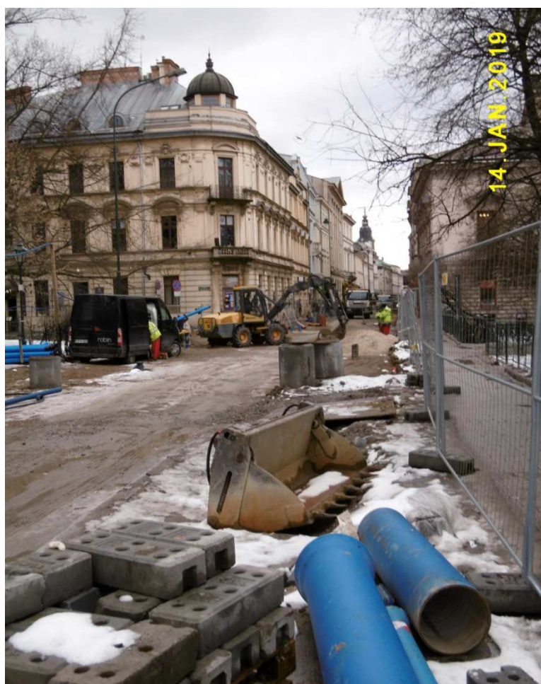
Fot. nr 720. Ulica Sławkowska na etapie remontu.
