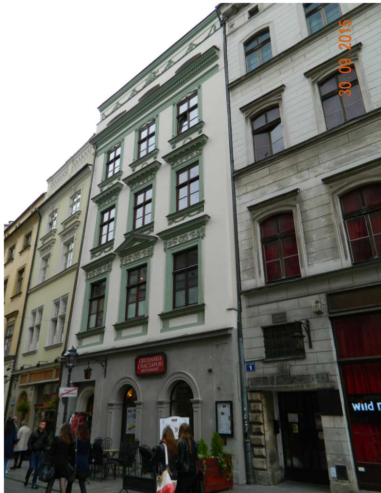
Fot. nr 71. Odnowiona kamienica z ulicy Grodzkiej 3.
