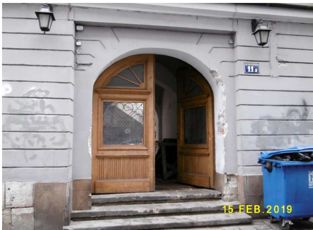
Fot. nr 732 (732-733). Kamienica pod nr 11a i jej podwórko.
