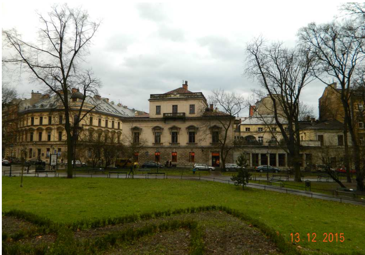
Fot. nr 121. Zabudowa wzdłuż ulicy Pijarskiej przy wylocie ulicy Sławkowskiej – widok z Plant. Można tylko wspominać dawną Kawiarnię Literacką (lokal z prawej).
