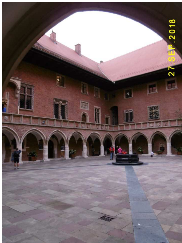
Fot. nr 577. Widok na narożnik południowo-zachodni.
