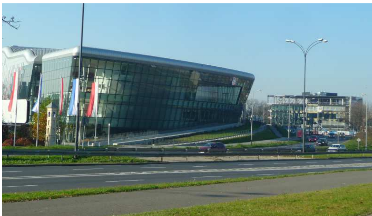
Fot. nr 624. Z prawej, w narożu ulic: Barskiej i Monte Cassino, jest już wznoszony kolejny wieżowiec – „drugi filar bramy dębnickiej”, który całkowicie zmieni galicyjski klimat końcowego odcinka ulicy Kilińskiego. (11.11.2018)
