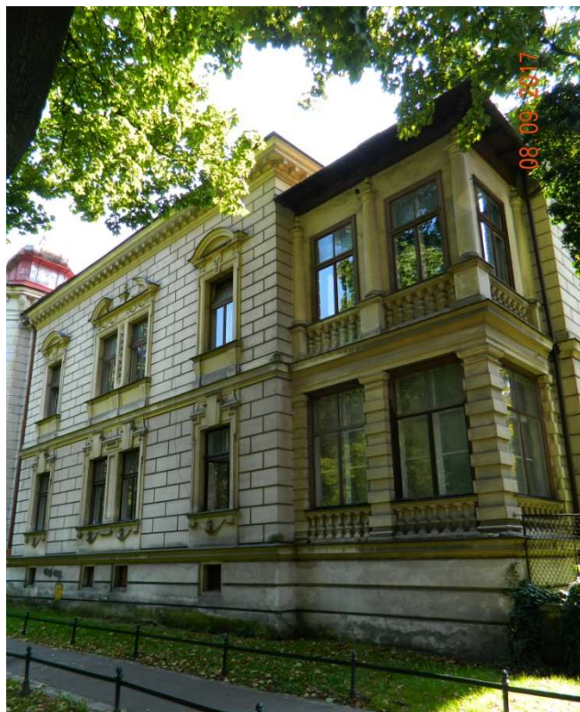
Fot. nr 240. Ekletyczna willa z ulicy Straszewskiego 1 w ujęciu z Plant.
