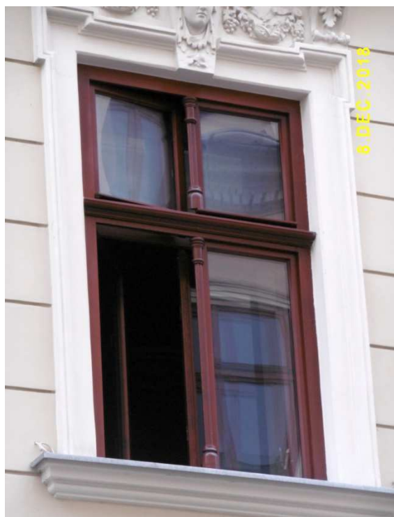
Fot. nr 588. Bliskie oryginałowi nowe okno.
