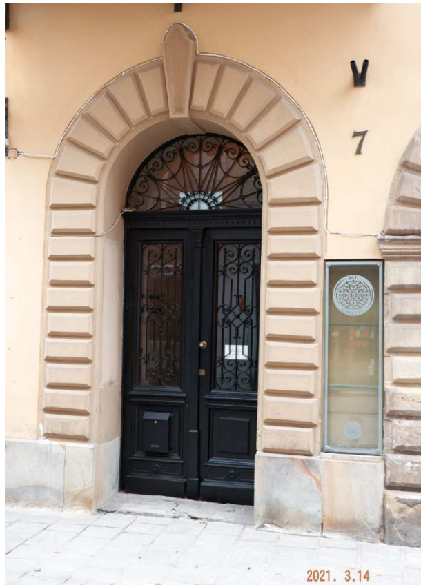
Fot. nr 72 (72-73). Portale kamienicy przy ulicy Brackiej 7.
