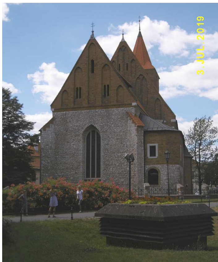
Fot. nr 54. Wykonane z łamanego kamienia gotyckie prezbiterium kościoła św. Krzyża.
