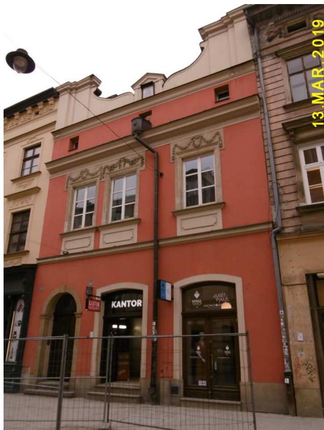
Fot. nr 38. Kamieniczka spod nr 18.
