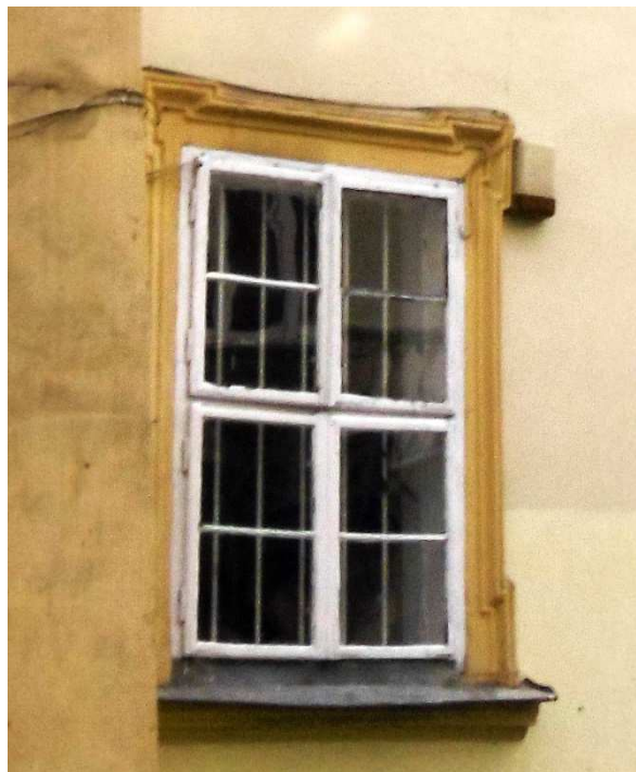
Fot. nr 8. Oryginalne okno ośmiopolowe.
