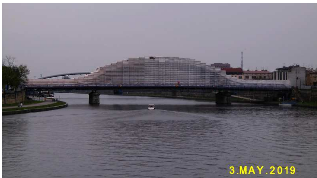
Fot. nr 96. Most Piłsudskiego w na etapie remontu.
