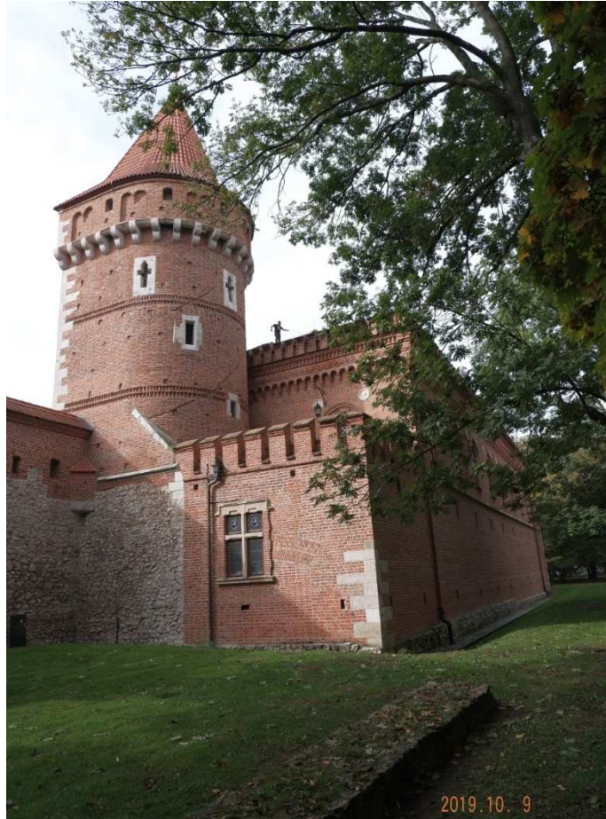
Fot. nr 103. Baszta Stolarska i Arsenał Miejski.
