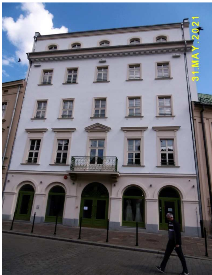
Fot. nr 104. Kamienica z ulicy Siennej 14 po zakończonym właśnie remoncie fasady.
