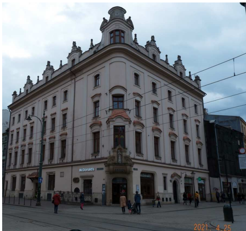
Fot. nr 240 (240-241). Kamienica Suskich pod nr: 24-26, w narożu z ulicą Dominikańską.
