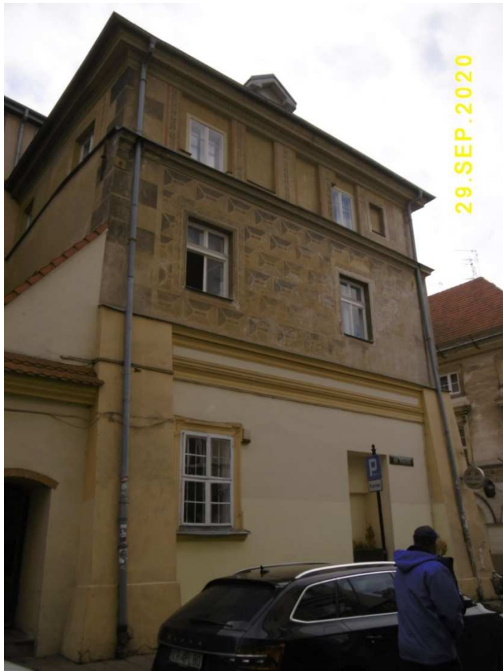
Fot. nr 7 (7-8). Kamienica pod nr 35 w narożu z ulicą św. Krzyża, a w jej parterze oryginalne, ośmiopolowe okno, typowe dla zabudowy Krakowa z połowy XIX wieku.
