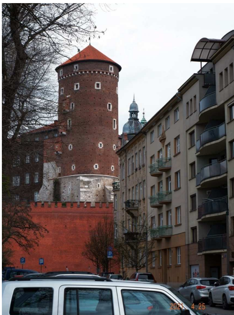
Fot. nr 29 (29-30). Widoki z ulicy Smoczej na Basztę Sandomierską.
