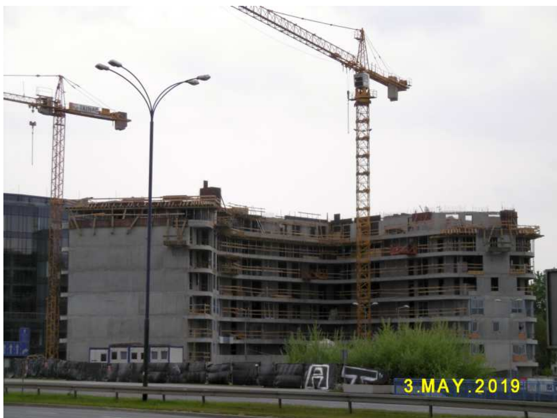
Fot. nr 103. Betonowanie Ludwinowa trwa.
