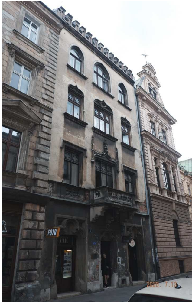
Fot. nr 18 (18-19). Niegotycka kamienica spod nr 17.
