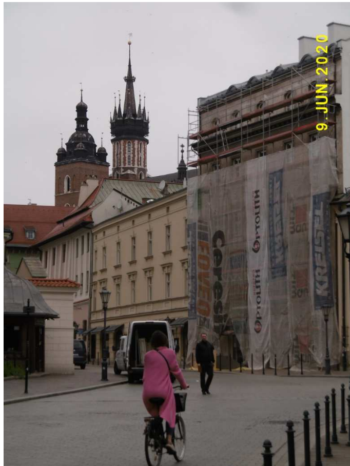
Fot. nr 5 (5-9). Końcowy fragment ulicy. Trwa remont kamienicy pod nr 14.
