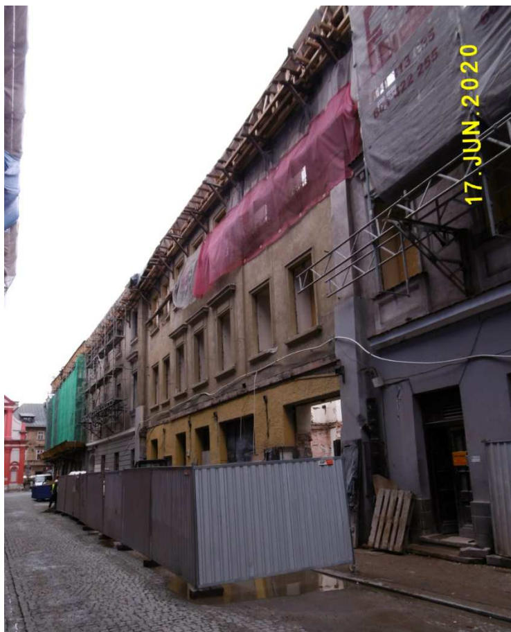
Fot. nr 35. Trwa przebudowa, połączona z wypruwaniem wnętrz, kwartału wzdłuż ulicy św. Tomasza 11-15 i św. Jana 6. Widok od strony ulicy Sławkowskiej.
