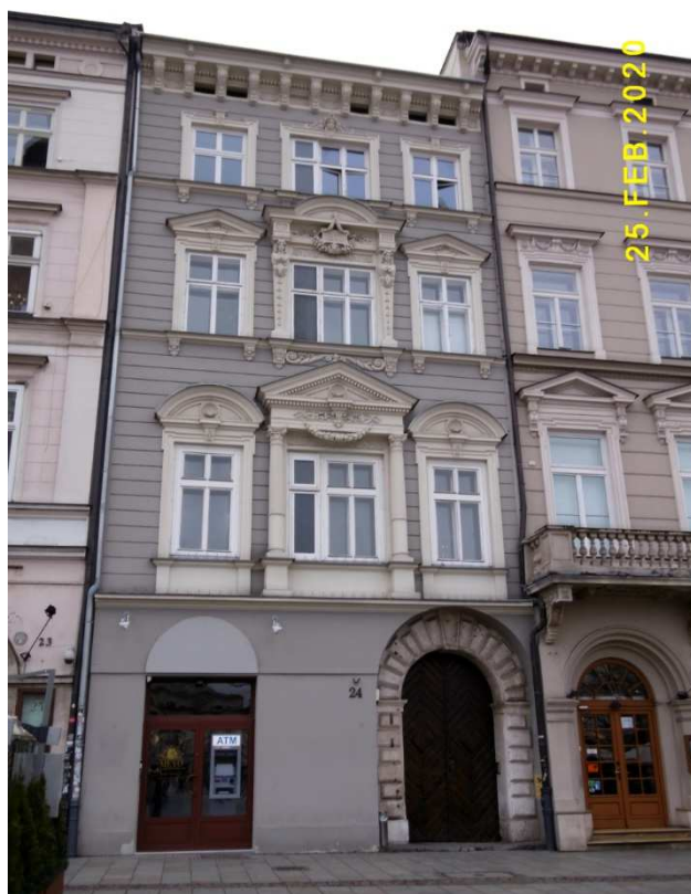
Fot. nr 58 (58-59). Fragment zabudowy linii E-F. Kamienica pod nr 24.
