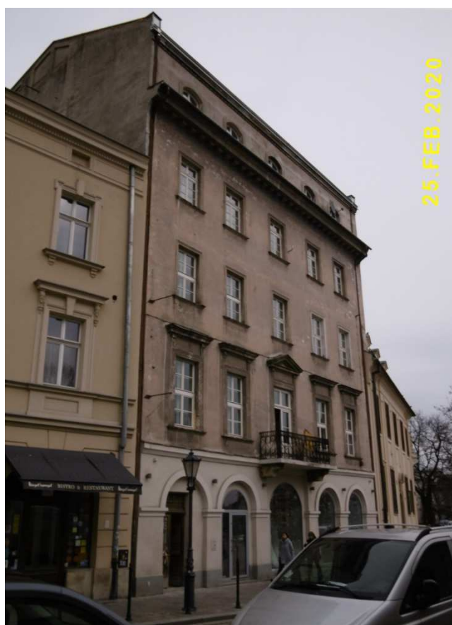
Fot. nr 20 (20-21). Kamienica z ulicy Siennej 14 na etapie remontu.
