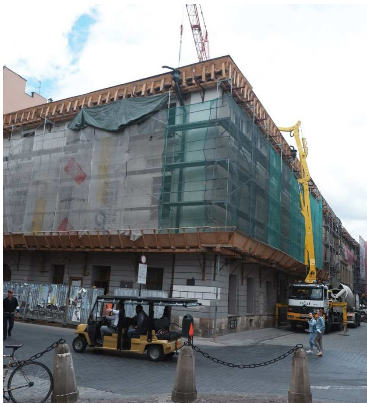
Fot. nr 36 (36-39). Trwa „rewitalizacja”, połączona z częściowymi wyburzeniami, fragmentu zabudowy ulicy św. Tomasza pomiędzy ulicami: św. Jana i Sławkowską.
