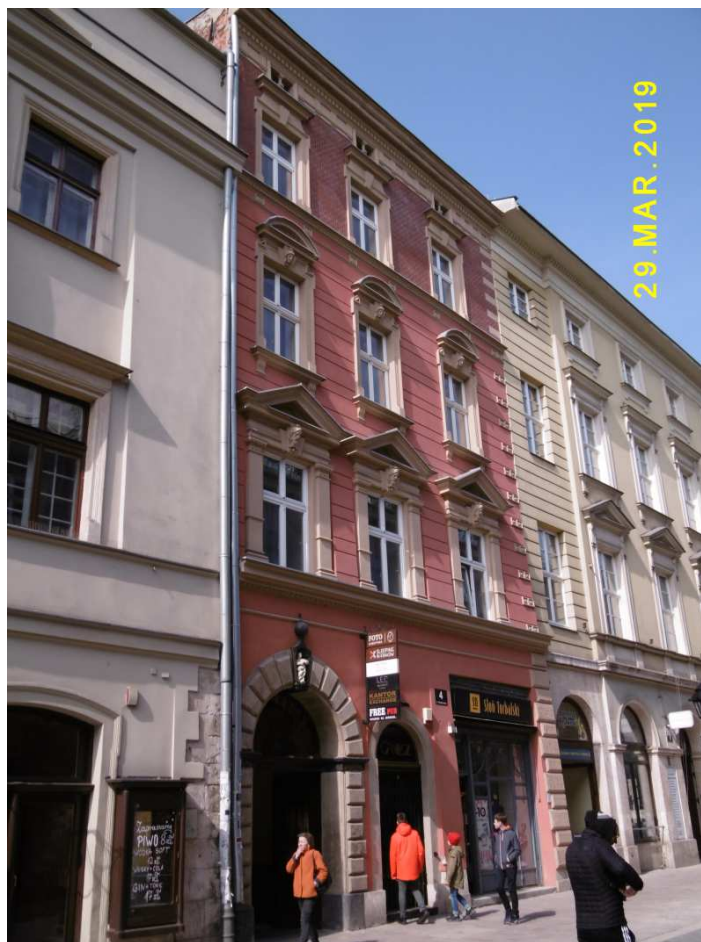
Fot. nr 34 (34-36). Kamienica z ulicy Sławkowskiej 4 i jej detale.
