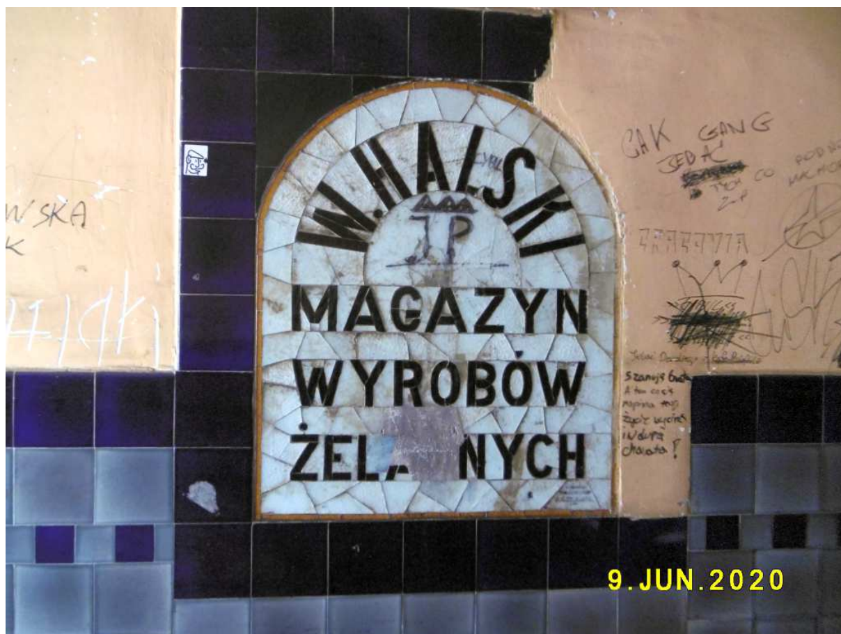
Fot. nr 31 (31-32). Wykładzina sieni kamienicy pod nr 23.
