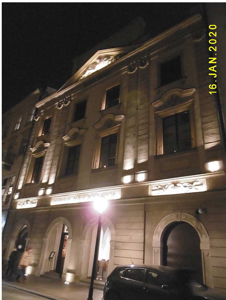
Fot. nr 96. Kamienica przy ulicy Szczepańskiej 5.
