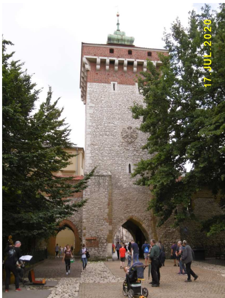
Fot. nr 4. Brama Floriańska – widok od strony Barbakanu.
