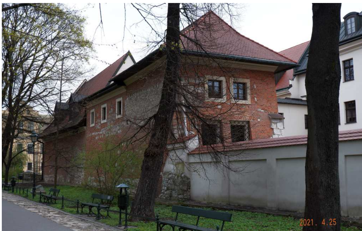
Fot. nr 289. Częściowo rekonstruowany budynek o średniowiecznej metryce.
