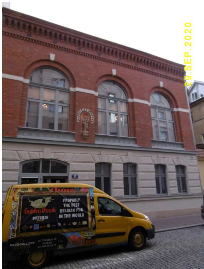
Fot. nr 5 (5-6). Odnowiona kamienica pod nr 37 i jej detale.
