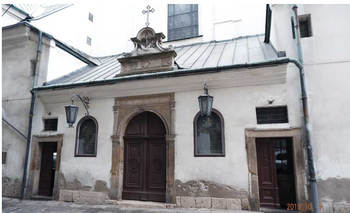
Fot. nr 110. Kruchta przy kościele Reformatów.
