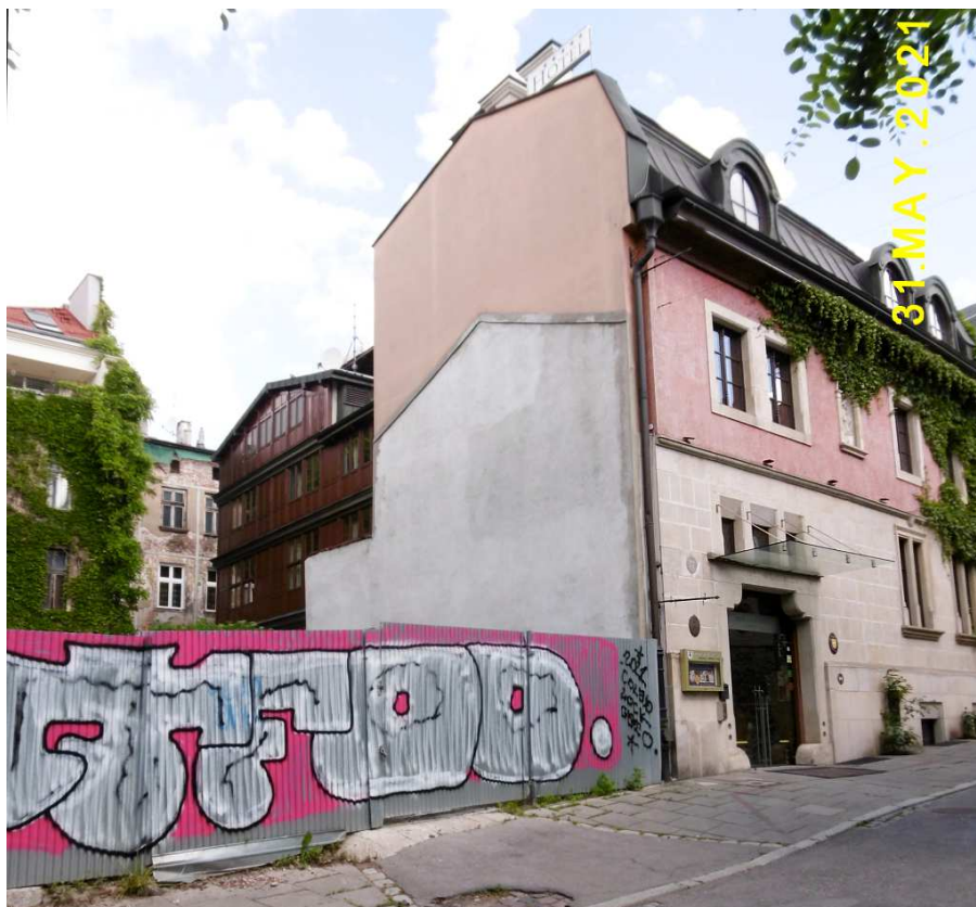
Fot. nr 112. Pusta przestrzeń po wyburzonym domu przy ulicy Na Gródku 3.
