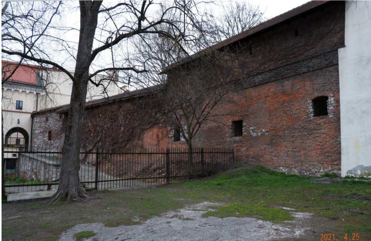
Fot. nr 284. Fragment muru obronnego dawnego Okołu na tyłach ulicy Kanonicyj.
