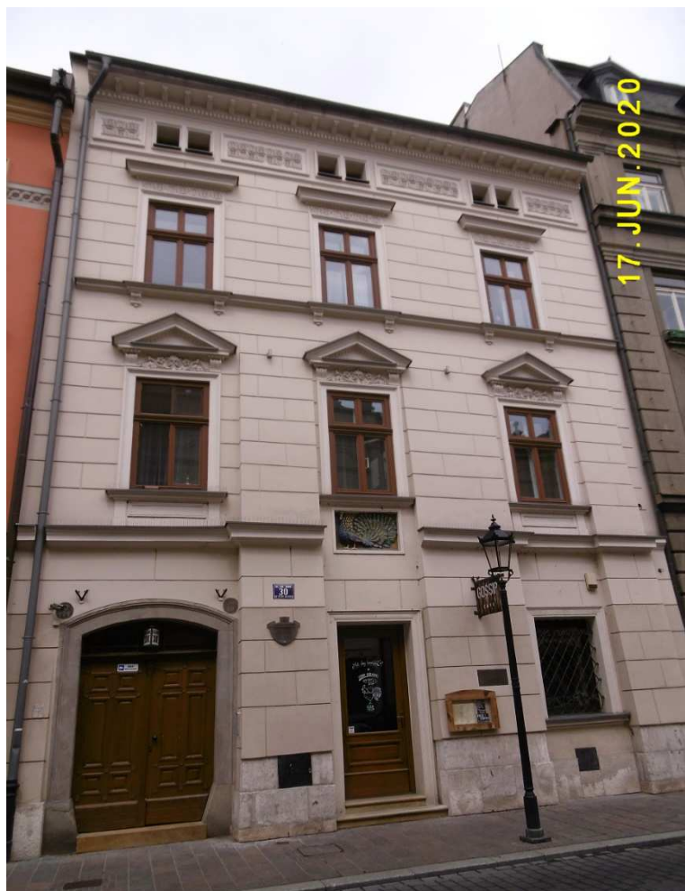
Fot. nr 39 (39-40). Kamienica Pod Pawiem pod nr 30.
