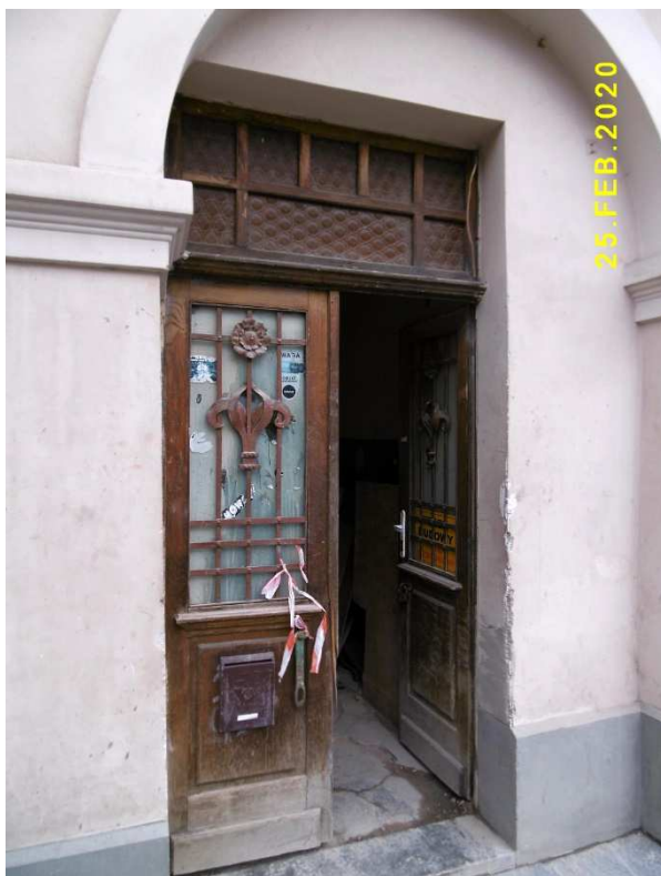
Fot. nr 21. Drzwi zdobione w duchu secesji.
