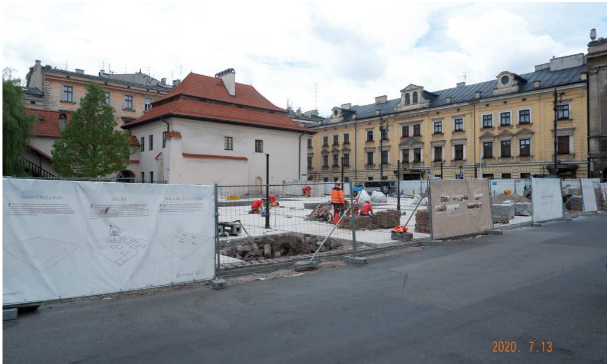
Fot. nr 14. Rewitalizacja fragmentu placu połączona z badaniami archeologicznymi.
