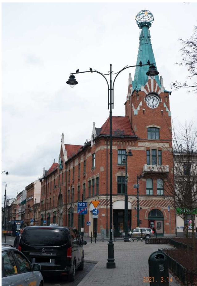
Fot. nr 176. Kamienica Pod Globusem przy ulicy Długiej 2 ponad Plantami.
