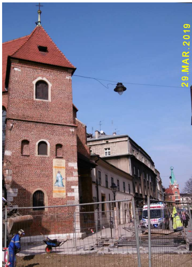
Fot. nr 42 (42-44). Wzdłuż ul. Sławkowskiej w stronę ulicy Długiej w trakcie jej remontu.
