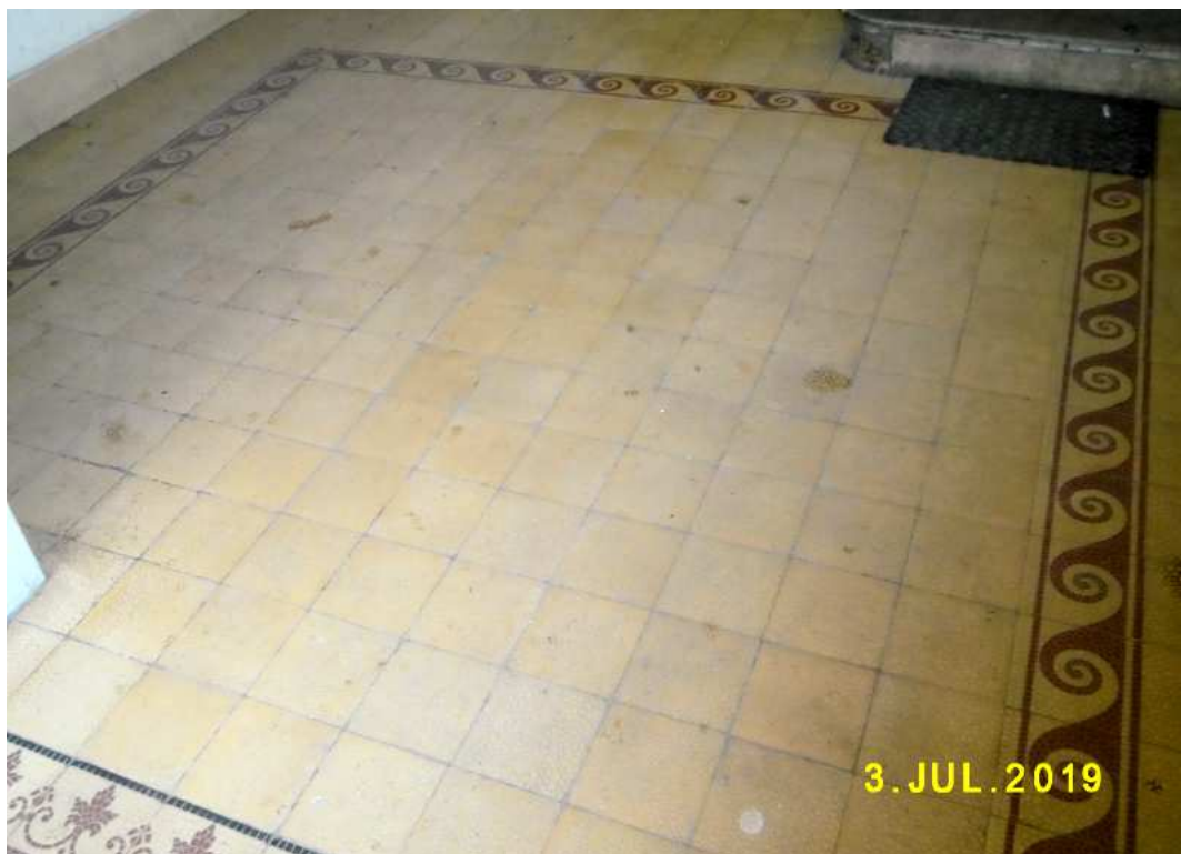
Fot. nr 23. Oryginalna posadzka.
