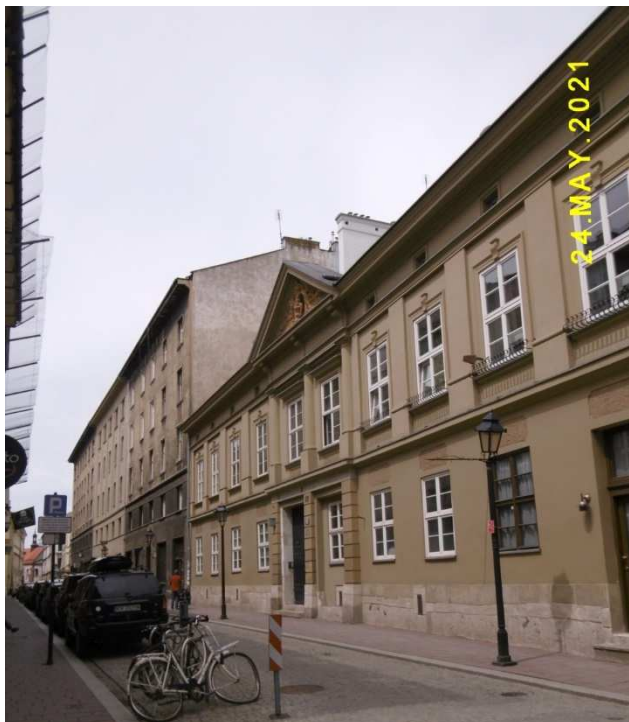
Fot. nr 128 (128-129). Klasycystyczna kamienica z ulicy św. Tomasza 28.
