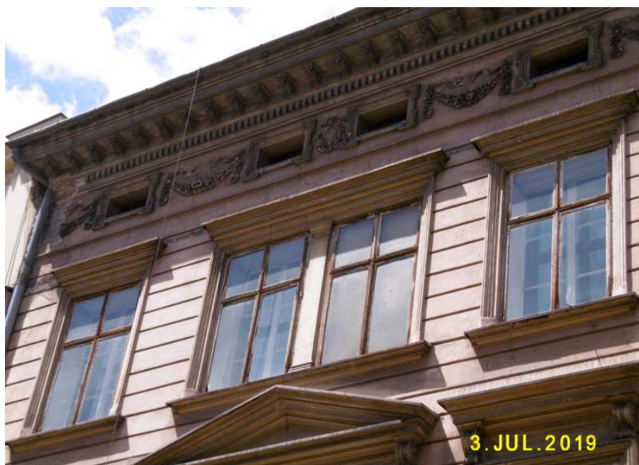
Fot. nr 20. Oryginalne drewniane okna drugiego piętra o cienkich szprosach, otwierane na zewnątrz, które zapewne niebawem znikną.
