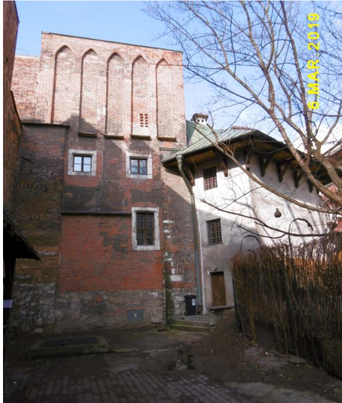
Fot. nr 4 (4-5). Dziedziniec na tyłach posesji z Małego Rynku 3 i 4. Widoki z ulicy Mikołajskiej na gotycką wieżę obronną.
