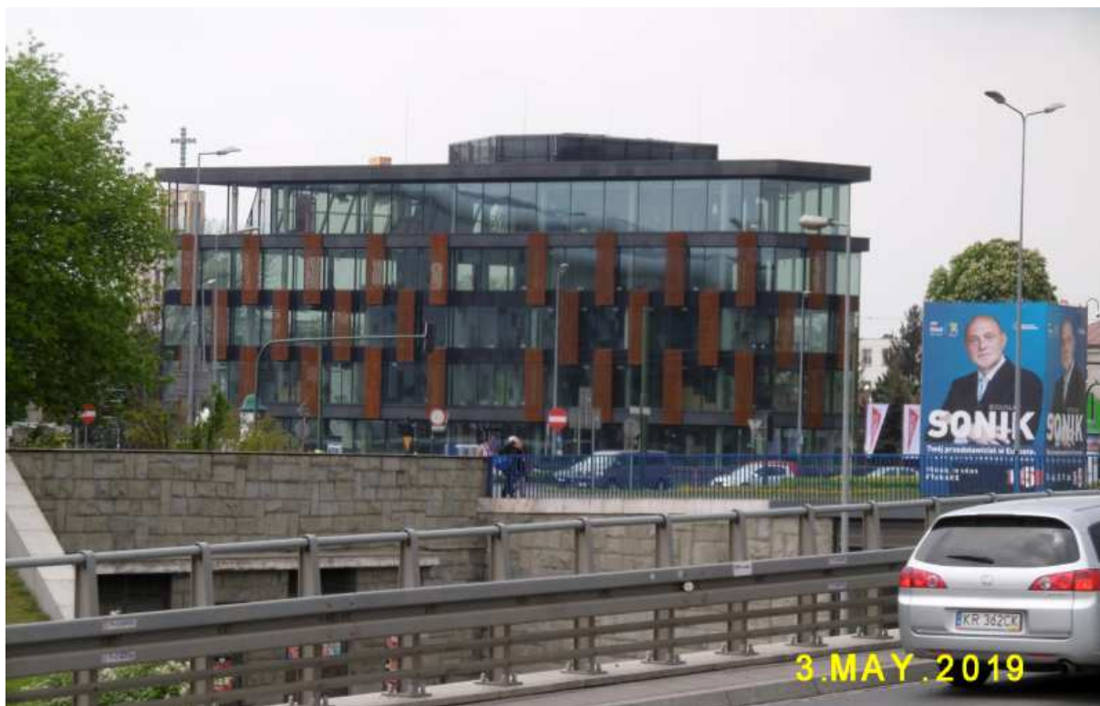
Fot. nr 106. „Szklany dom” w miejscu zieleńca. „Dogęszczanie” i „betonowanie” Krakowa trwa.
