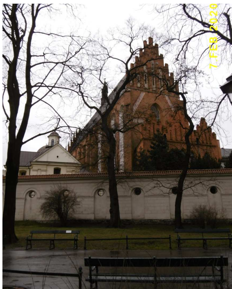
Fot. nr 74 (74-76). Kościół Dominikanów. Tu widok z Plant na prezbiterium.
