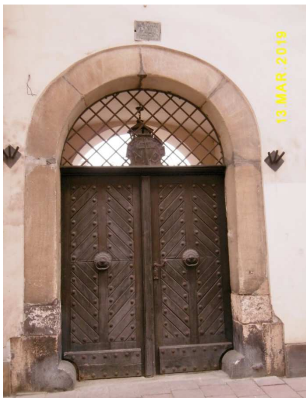
Fot. nr 91 (91-94). Detale Domu Pod Krzyżem od strony ulicy św. Marka 24.
