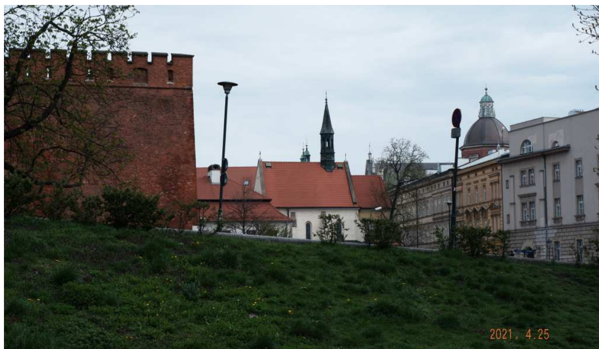
Fot. nr 216. Kościół św. Idziego w ujęciu z Drogi do Zamku.
