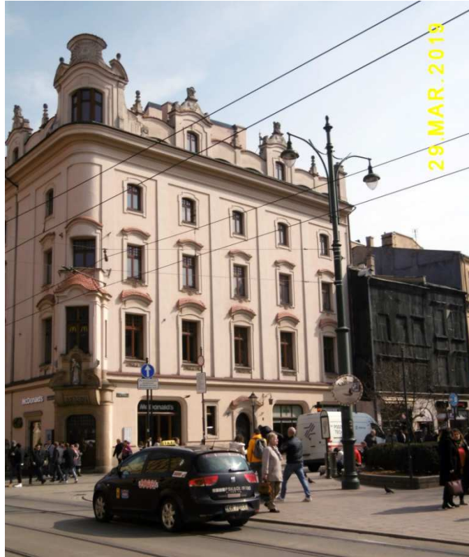
Fot. nr 26 (26-27). Dawna kamienica Suskiego przy ulicy Grodzkiej 24-26.
