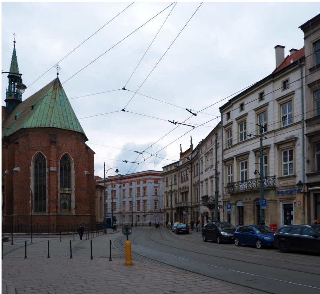
Fot. nr 76. Widok ulicy Franciszkańskiej z placu Wszystkich Świętych. (14.03.2021)
