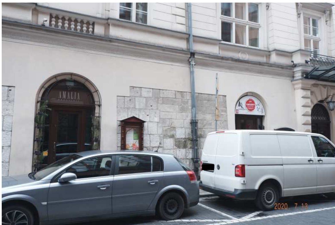
Fot. nr 33 (33-35). Przy ulicy św. Jana. Tu parter kamienicy pod nr 1.
