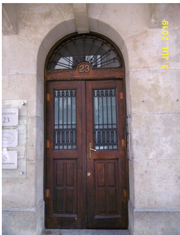
Fot. nr 16. Drzwi wejściowe.
