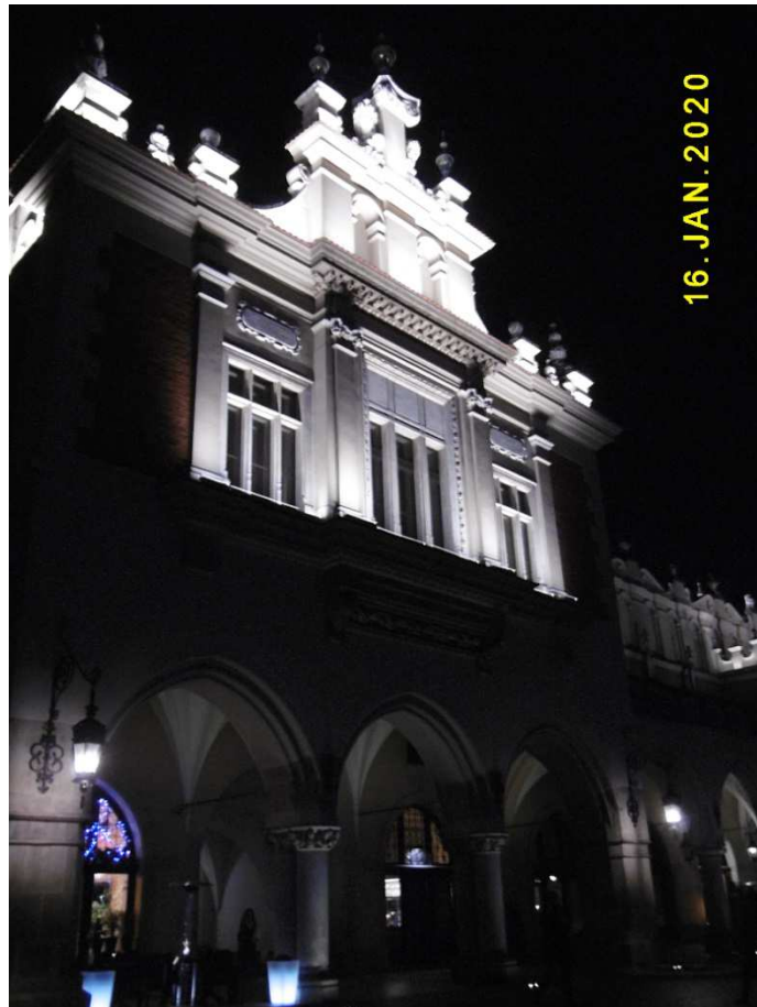
Fot. nr 45. Środkowy ryzalit od strony ulicy Szewskiej.
