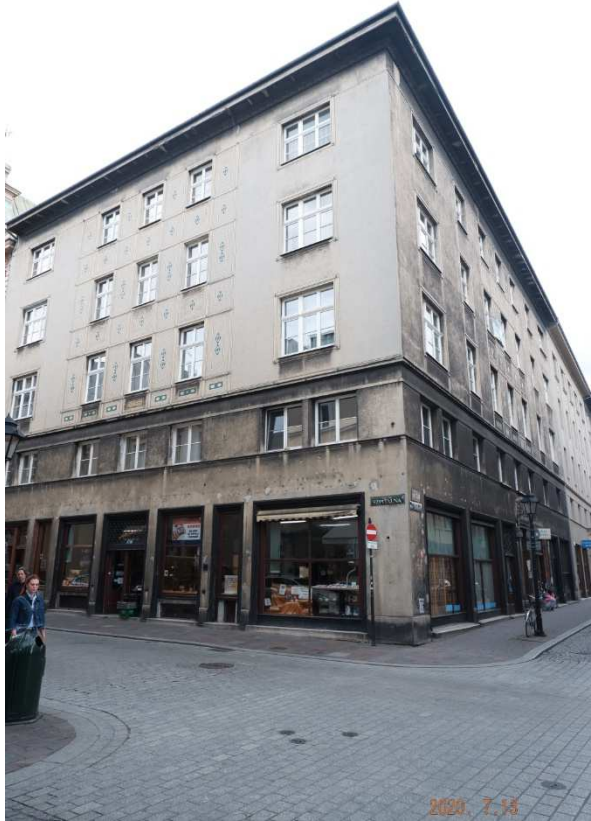
Fot. nr 20. Międzywojenna kamienica z naroża ulic: Szpitalnej 11-13 i św. Tomasza 22.
