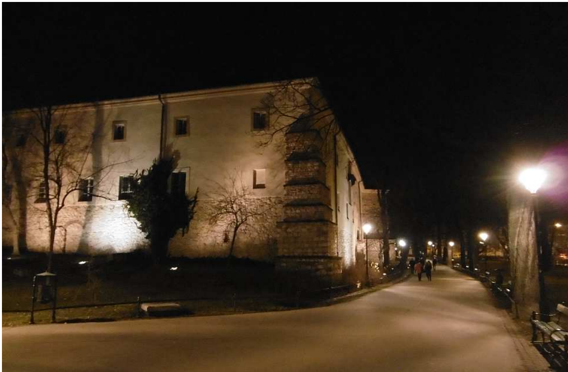
Fot. nr 10 (10-11). Widoki od strony ulicy Siennej.
