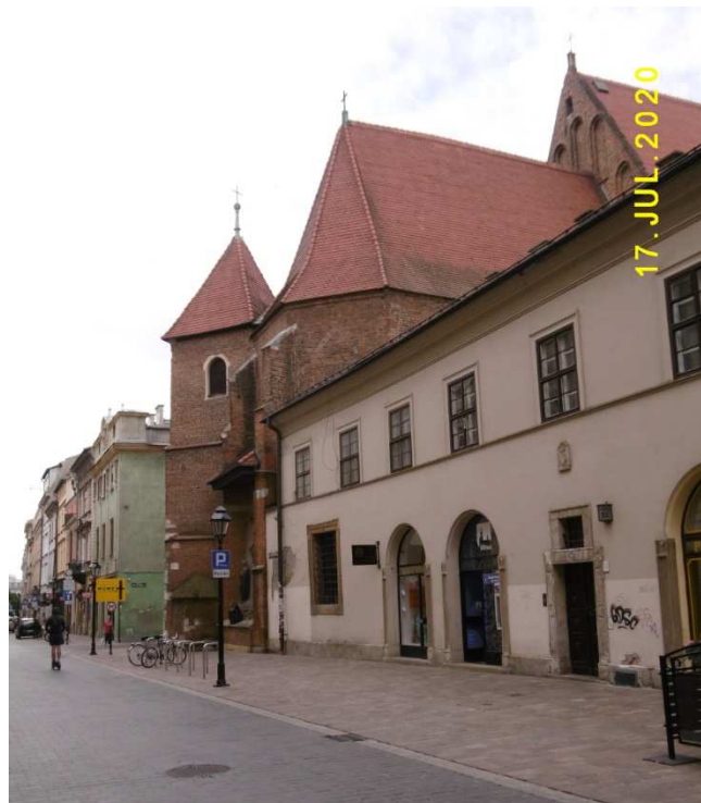
Fot. nr 41. Fragment zabudowy poniżej kościoła św. Marka.
