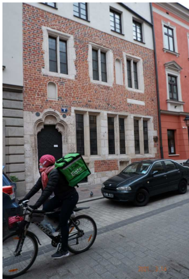
Fot. nr 125 (125-126). Gotycka fasada kamienicy pod nr 8.
