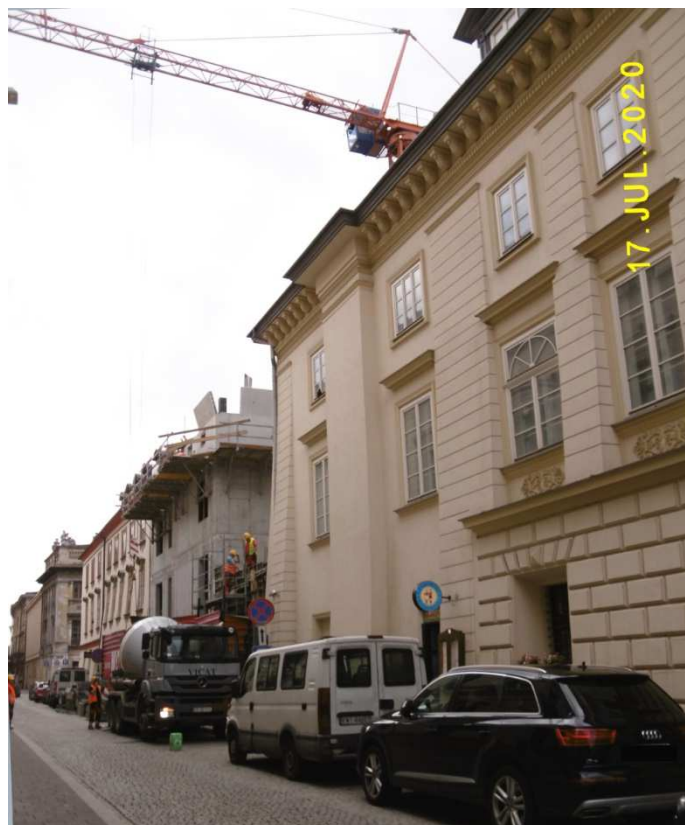
Fot. nr 44 (44-45). Widoki ulicy św. Tomasza z ulicy Sławkowskiej. Tu ku ulicy św. Jana.
