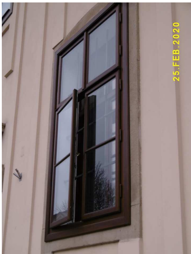
Fot. nr 19. Rzadki już przypadek drewnianych okien otwieranych na zewnątrz,
