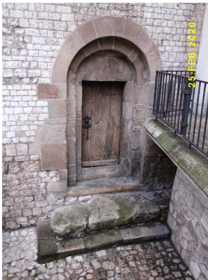
Fot. nr 64. Wejście do pierwotnej, romańskiej świątyni.
