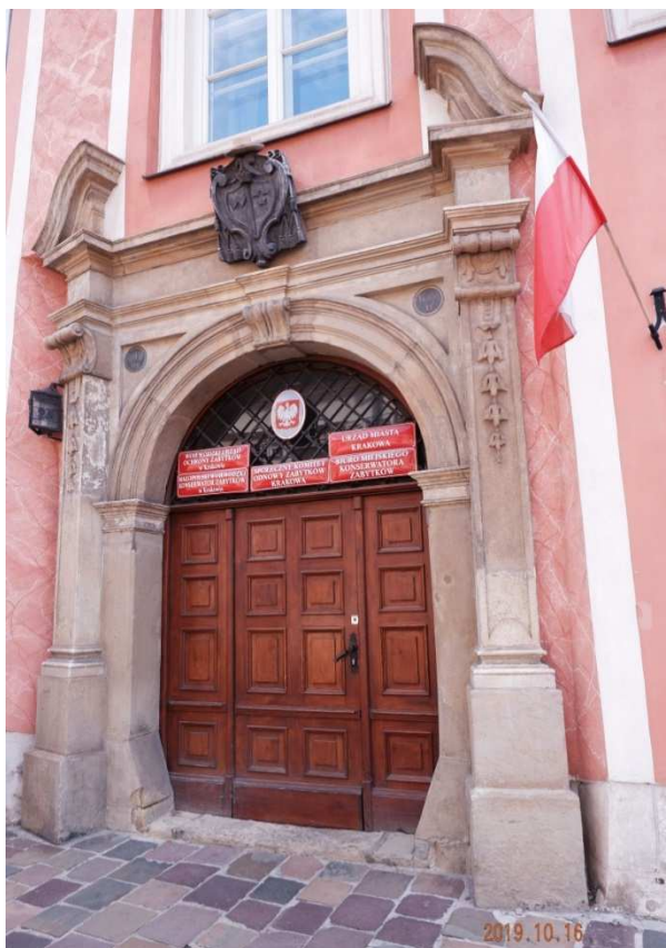
Fot. nr 74. Portal wejściowy.
