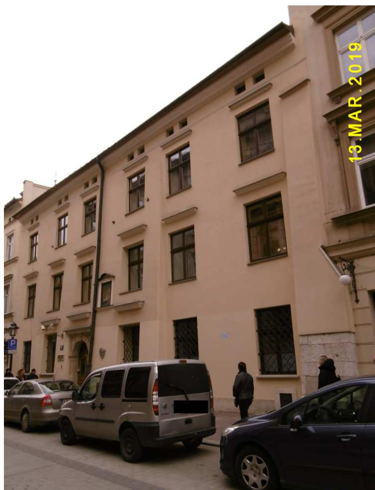
Fot. nr 87 (87-89). Kamienica Pod Obrazem z ulicy Szpitalnej 18 i jej detale.
