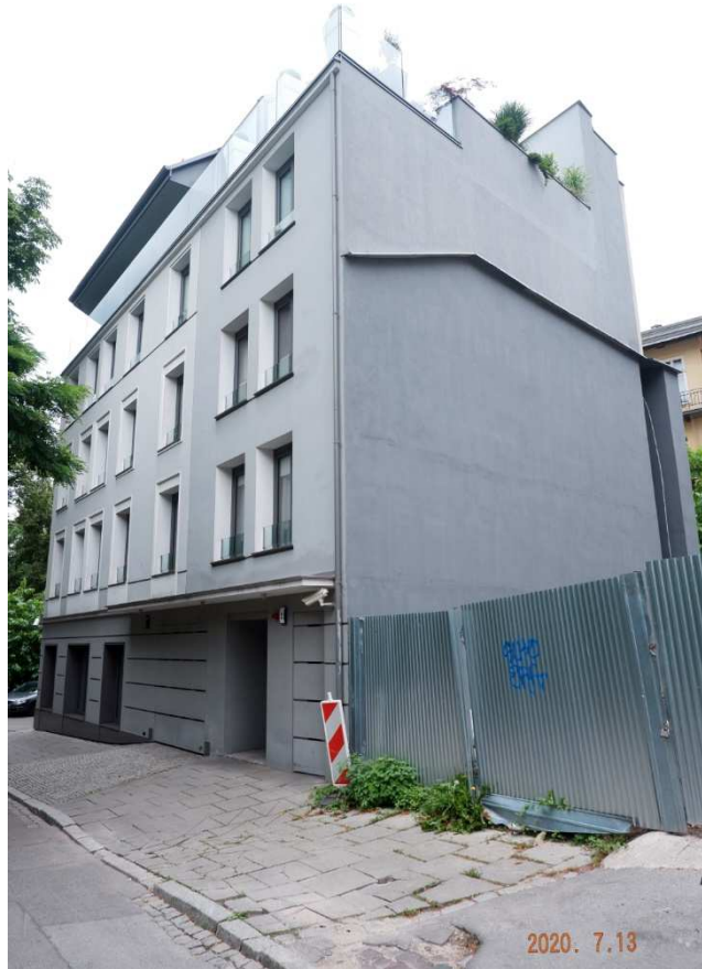
Fot. nr 88. Współczesne architektoniczne „pudełko” pod nr 2.
