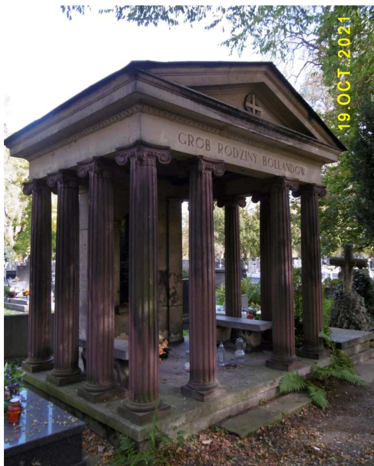
Fot. nr 92 (92-93). Monumentalny, na kształt greckiej świątyni, grobowiec rodziny Bollandów.
