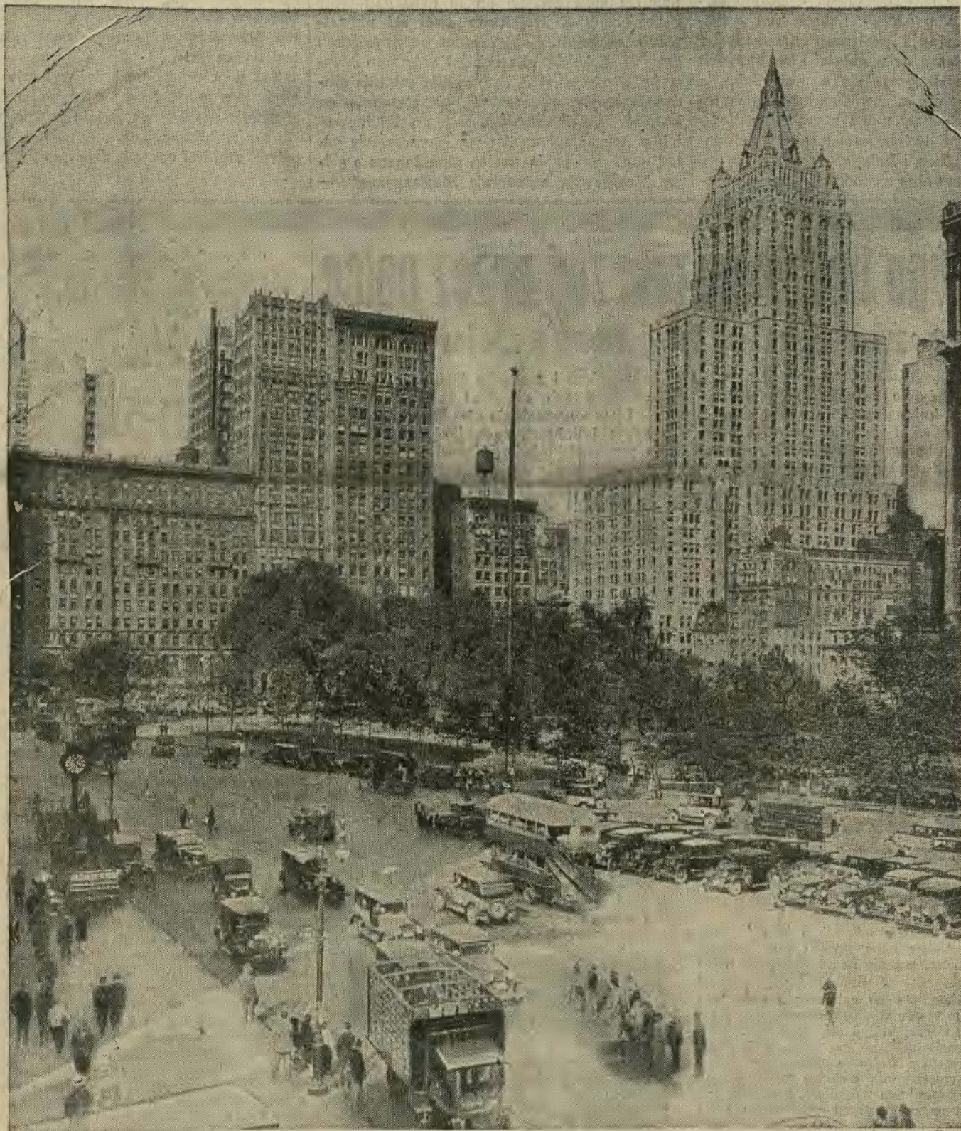
W City Nowego Jorku, t. j. w samym sercu miasta, powstają nowe budowle z taką szybkością, iż niemal przez noc gmachy, które przed dziesięciu laty uchodziły za drapacze chmur, obecnie zostają zburzone, ażeby ustąpić miejsca nowym olbrzymom. Jednym z takich gigantycznych gmachów, który powstał na gruzach mniejszego drapacza, jest gmach nowojorski Tow. ubezpiec. na Madison Square. (Na ryc. po prawej str.)
