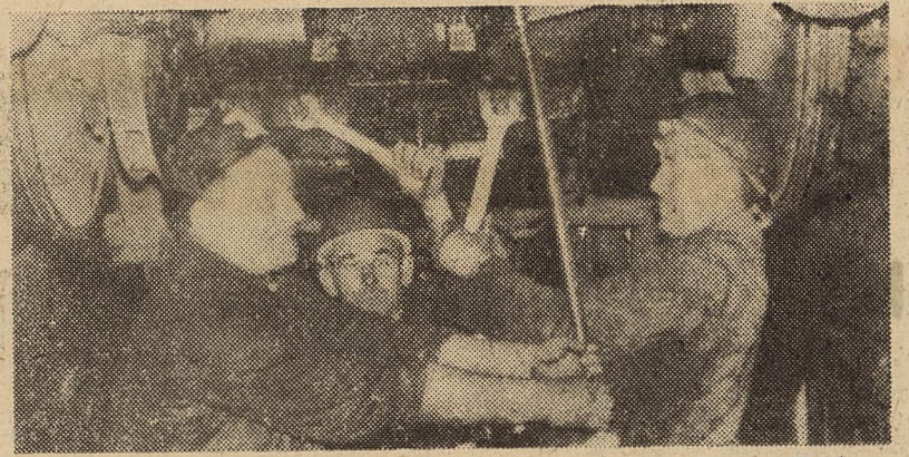
Brygada podwoziowa w Zajezdni Tramwajowej w Nowej Hucie w czasie pracy
