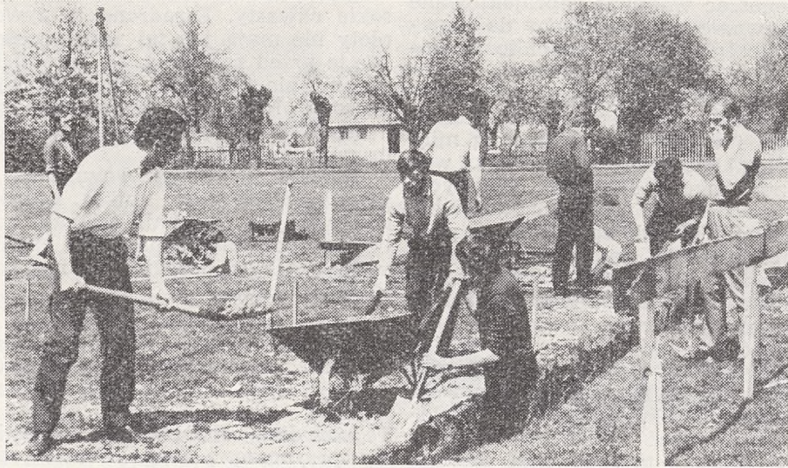
Członkowie XIII koła ZMS przy Dziale Taryfowo-Biletowym naszego Przedsiębiorstwa przy wykopie pod fundamenty domu dla wdowy z ośmiorgiem dzieci.
