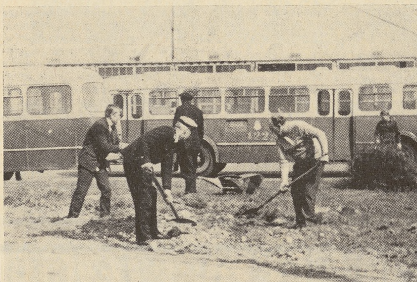
Prace porządkowe na terenie zajezdni autobusowej w Bińczycach.
