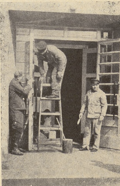
Pracownicy Stacji Tramwajowej Nowa Huta przy robotach malarskich.
