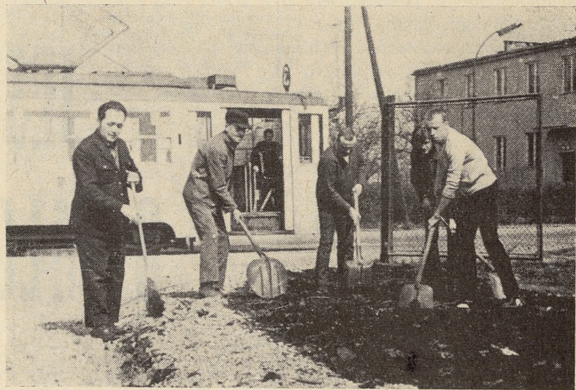
Pracownicy Wydziału Eksploatacyjnego Tramwajowego Podgórze porządkują teren przy ul. Rzemieślniczej.
