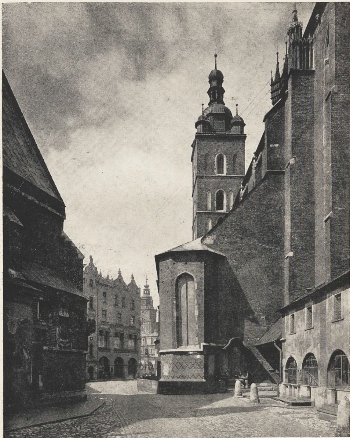
8. Widok od południowego wschodu
