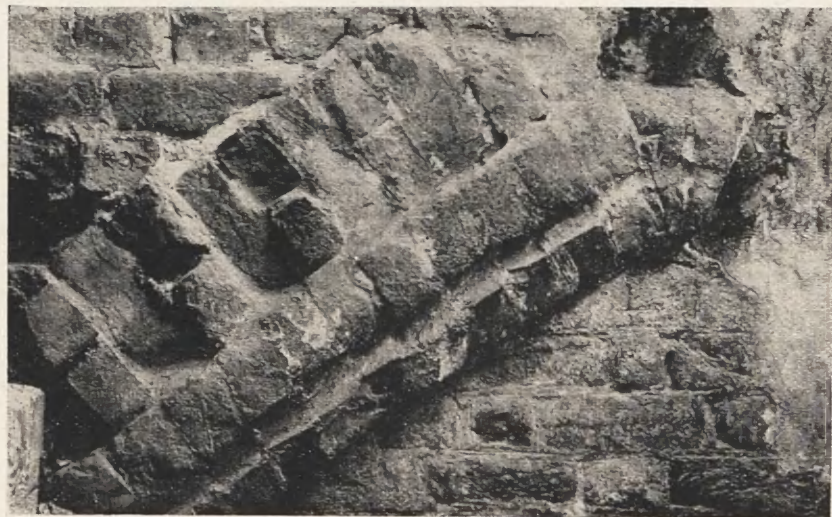
36. Ślad sklepienia hali I na wschodniej ścianie wieży południowej
