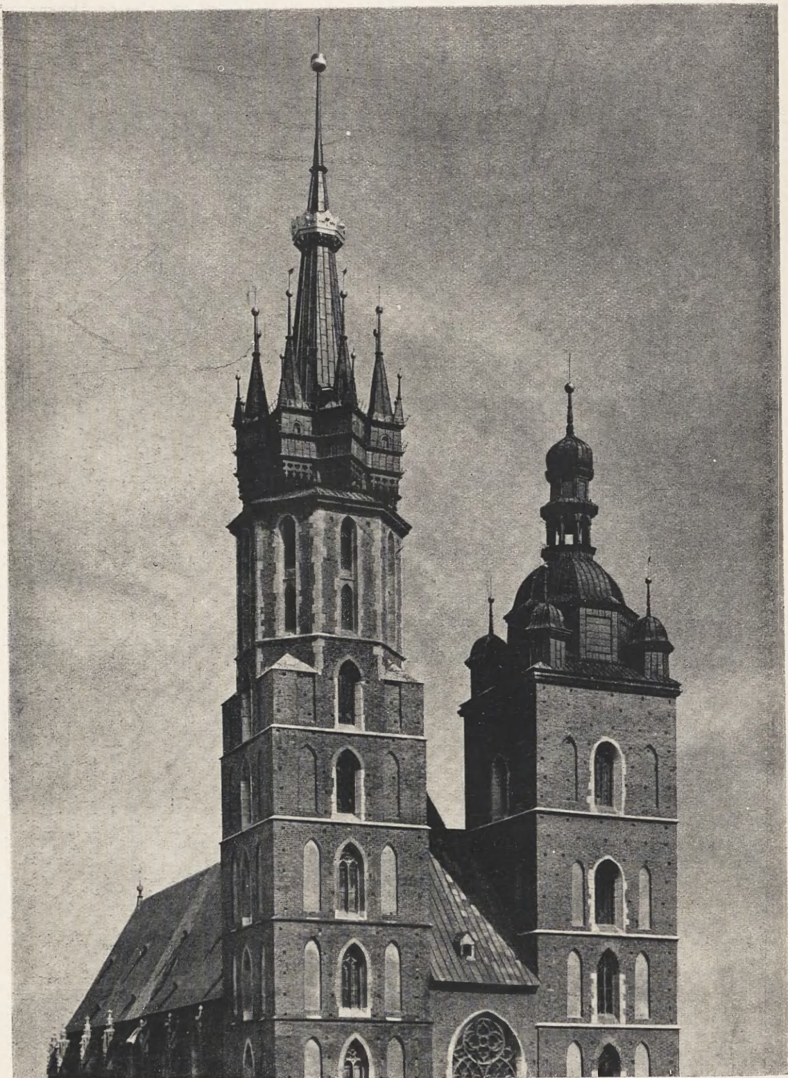
5. Widok wież od zachodu, część górna
