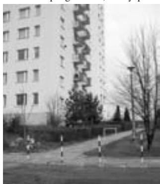
Utрудniony dojazd dla pojazdów ratowniczych przy jednym z wieżowców przy ul. Bojki na Kurdwanowie.
