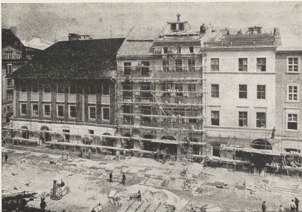
Ryc. 5. Przebudowa i odnawianie kamienic Małego Rynku w Krakowie w r. 1969
