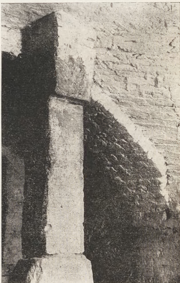
Ryc. 10. Słup romański podpierający sklepienie piwnicy w skrzydle gospodarczym
