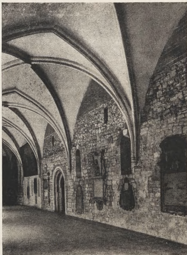
Ryc. 6. Ściana południowa refektarza
