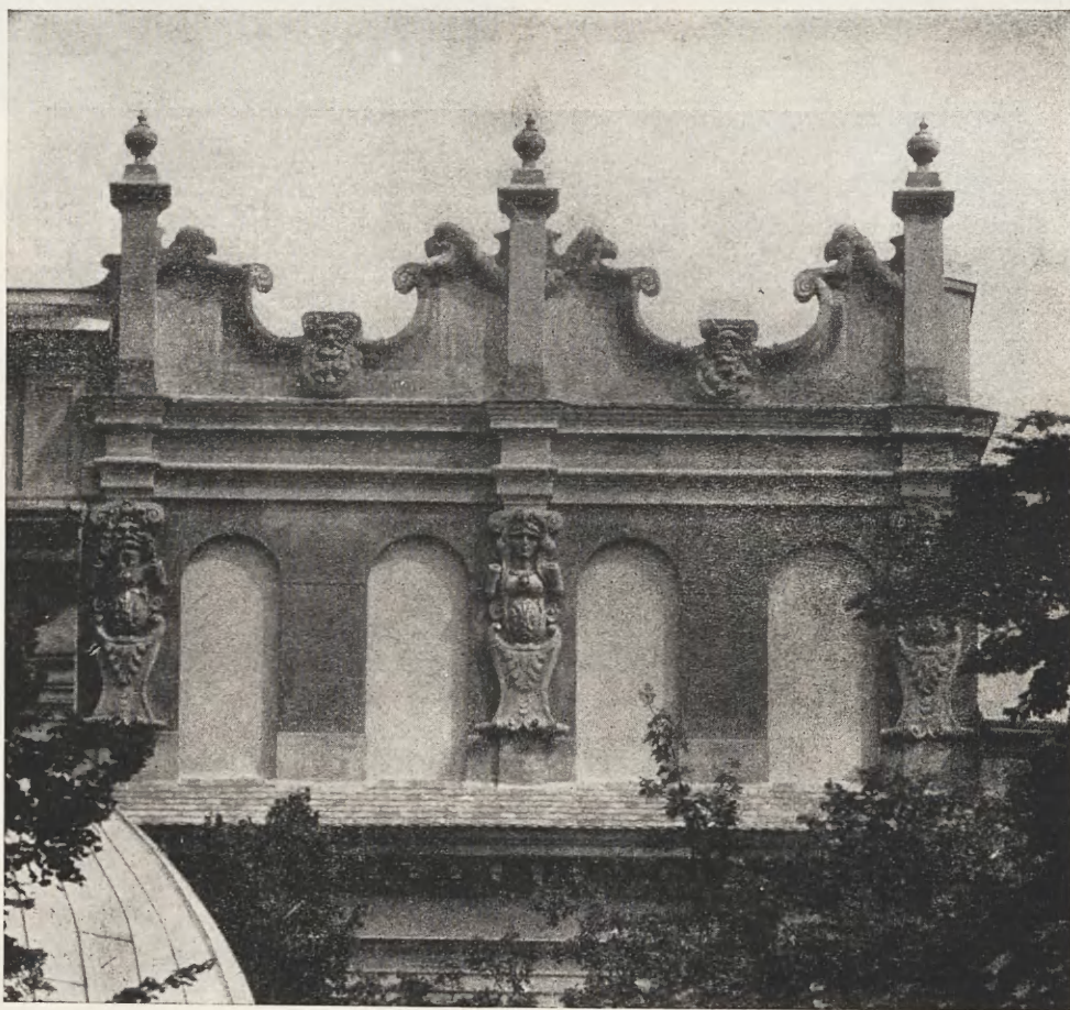
Ryc. 3. Zrekonstruowana fasada kamienicy Bonerowskiej w Rynku Głównym w Krakowie
