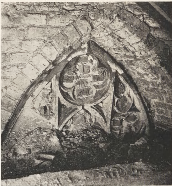
Ryc. 29. Maswerk okna w północnej ścianie nawy bocznej
