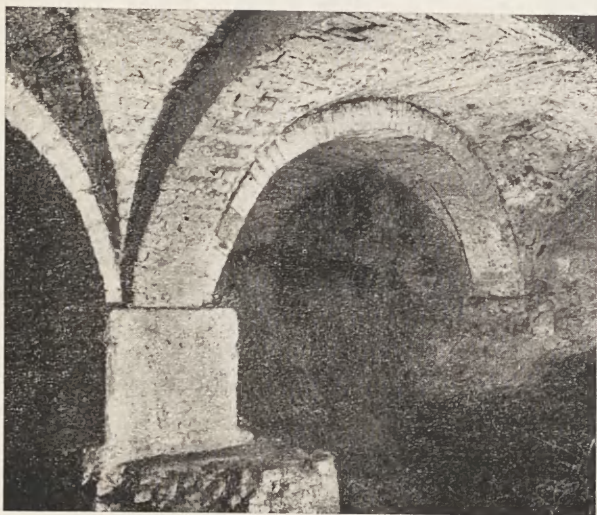
Ryc. 9. Wnętrze piwnicy pod refektarzem postnym
