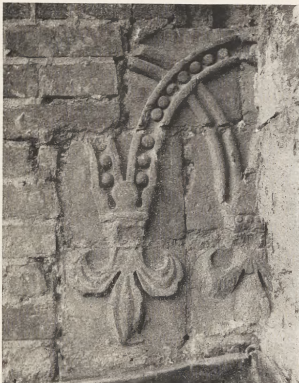
Ryc. 28. Fragment fryzu ceramicznego na ścianie południowej
