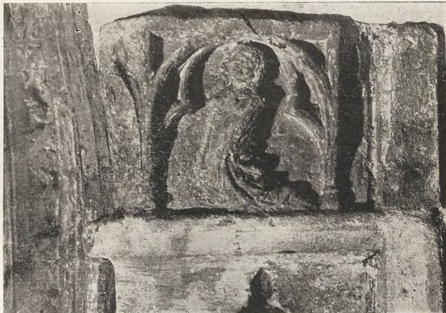
Ryc. 27. Węgar prawy portalu głównego
