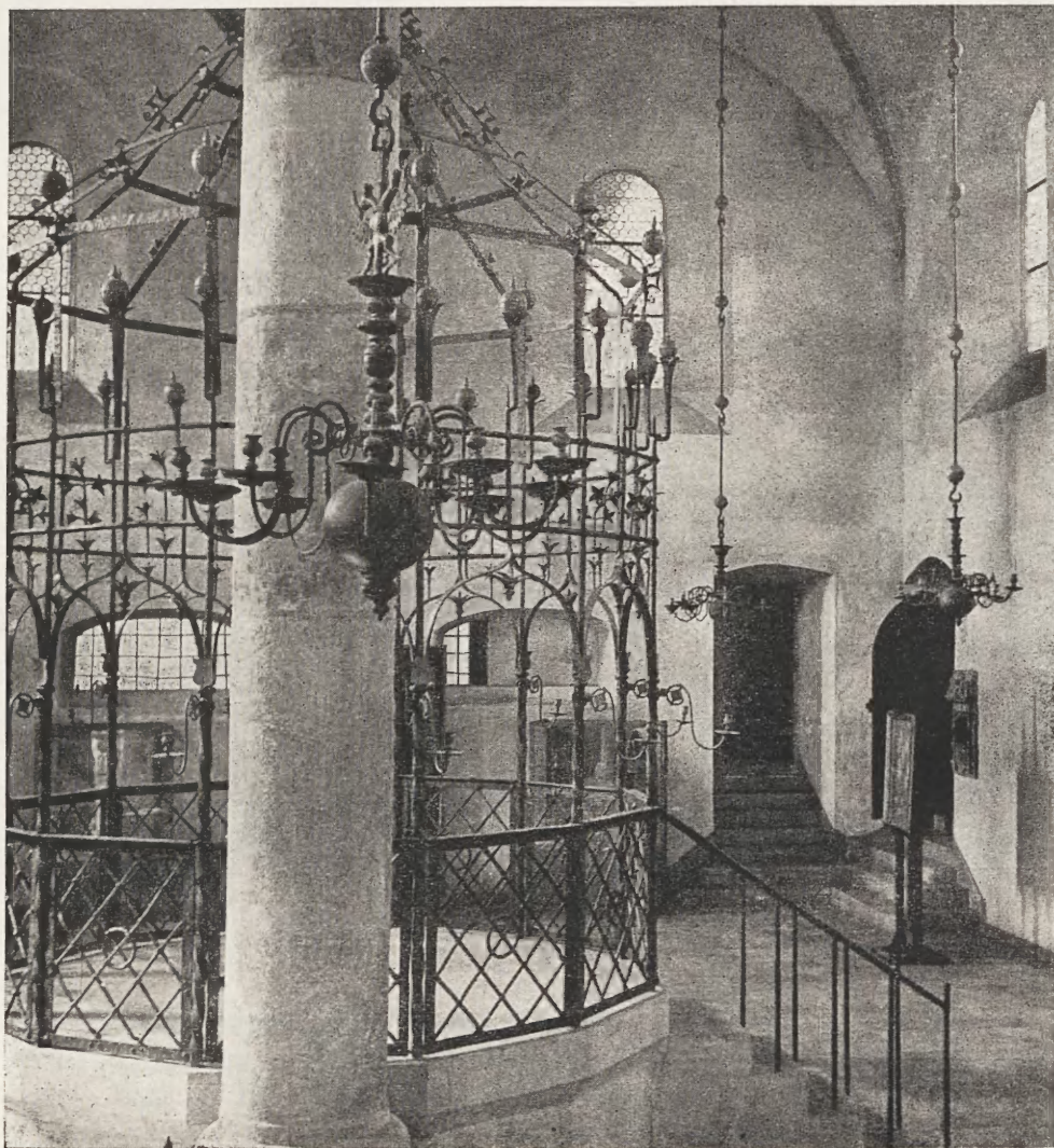
Ryc. 8. Stara Bóżnica — odbudowana po zniszczeniu wojennym mieści Muzeum Judaistyczne
