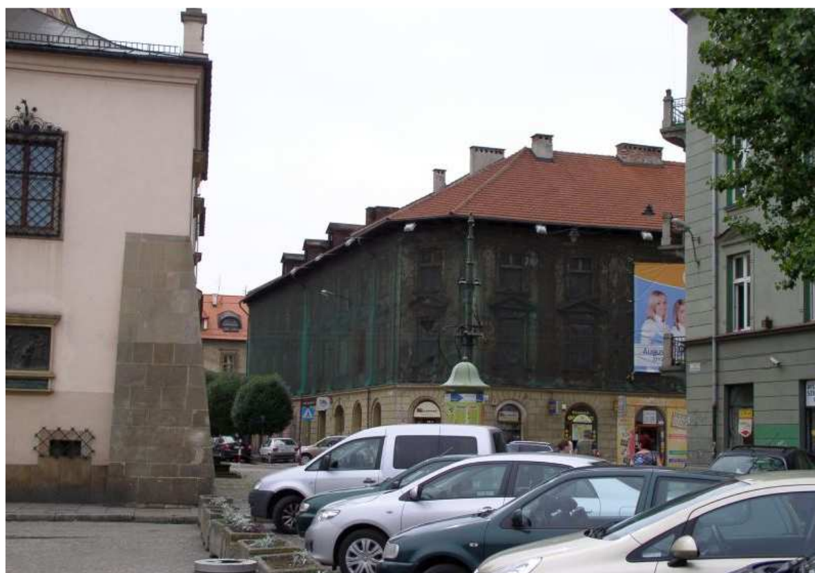
Fot. nr 104 (104-105). Coraz mocniej podupadająca kamienica z naroża ulic: Krakowskiej i Węglowej. 08.07.09
