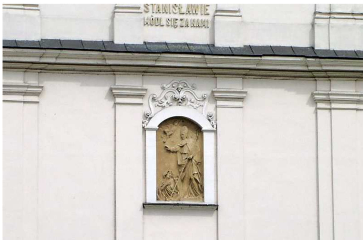
Fot. nr 129. Płaskorzeźba z wizerunkiem św. Stanisława na ścianie tylnej prezbiterium. 08.07.09
