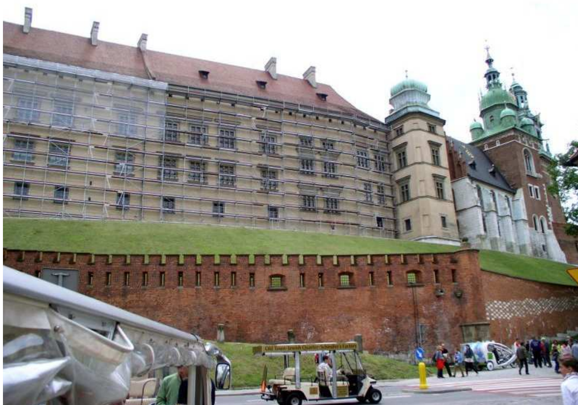
Fot. nr 44. Trwa remont elewacji zamku. 02.07.11
