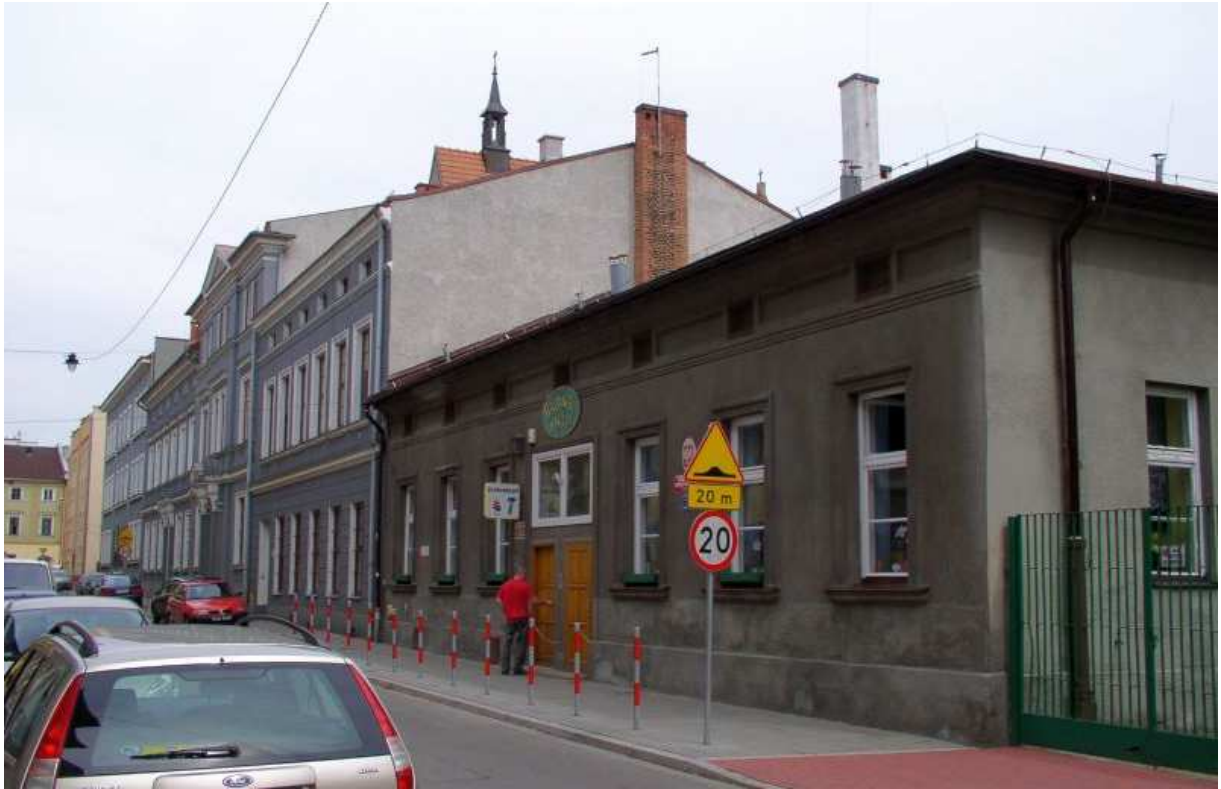
Fot. nr 120. Wzdłuż ulicy Piekarskiej. 08.07.09
