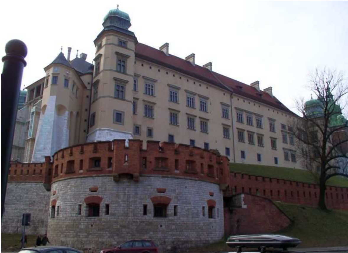
Fot. nr 42 (42-44). Północne skrzydło zamku– widoki z wylotu ulicy Kanoniczej. 07.02.11
