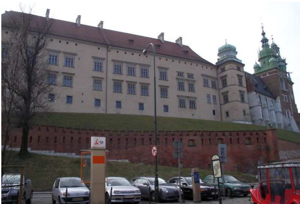
Fot. nr 43. Północne skrzydło z Wieżą Batorego i katedrą po prawej stronie. 07.02.11
