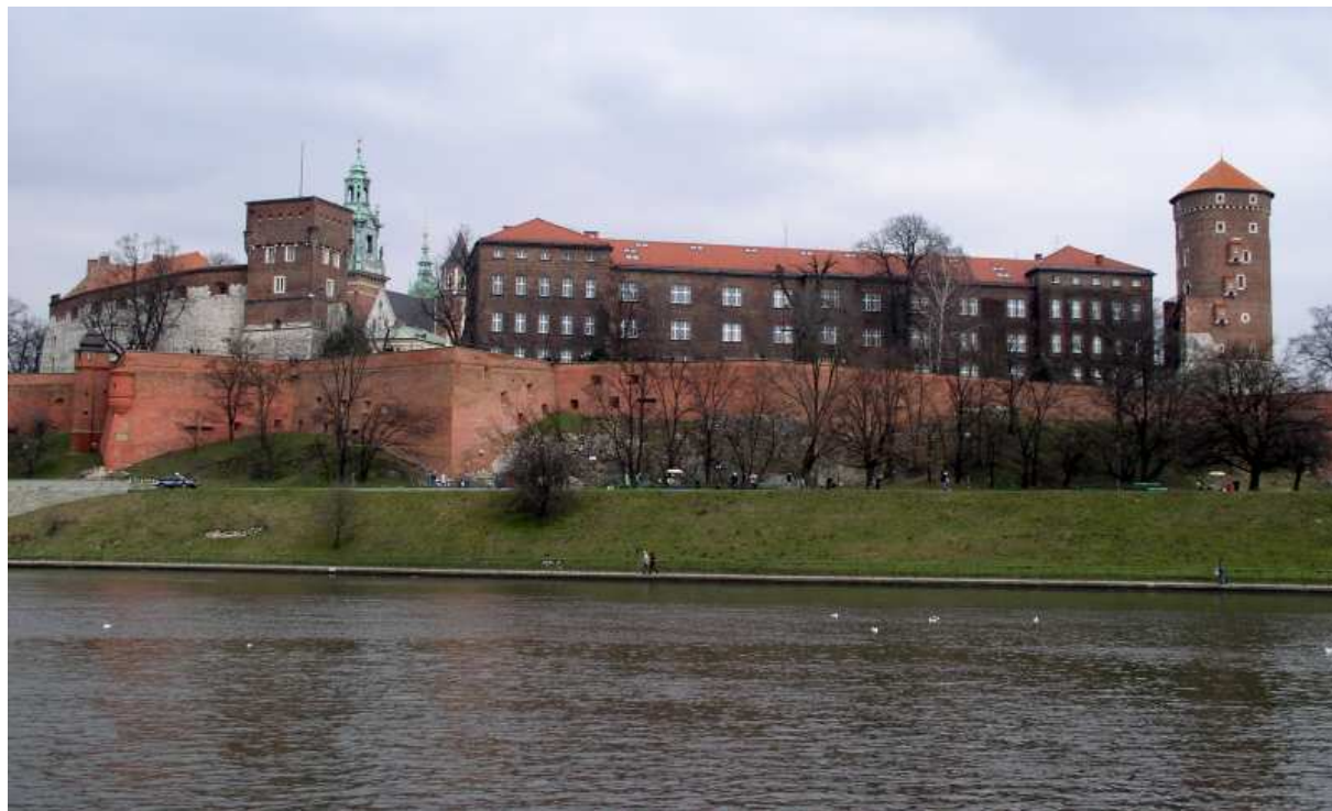
Fot. nr 25 (25-28). Zachodnie skrzydło zamku królewskiego z gmachem poaustriackiego szpitala pośrodku, powstałym w miejscu średniowiecznego muru – widoki z okolic Mostu Grunwaldzkiego. 21.03.09
