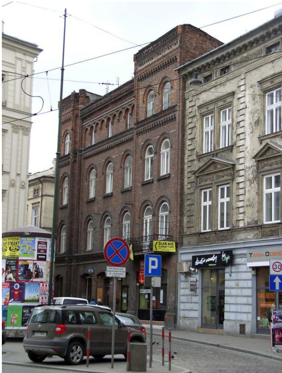
Fot. nr 50. Neorenesansowy budynek nowego Domu Celnego z ulicy Stradomskiej 17, zwany też kamienicą Barucha, który powstał w latach 1856-63 wg projektu Feliksa Książarskiego. 09.04.11
