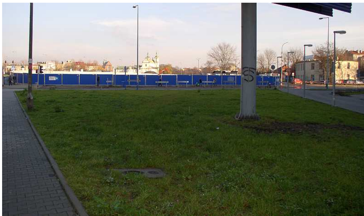
Fot. nr 124. Zespół klasztorny Paulinów na Skałce – widok ponad placem budowy Centrum Kongresowego. 17.11.10
