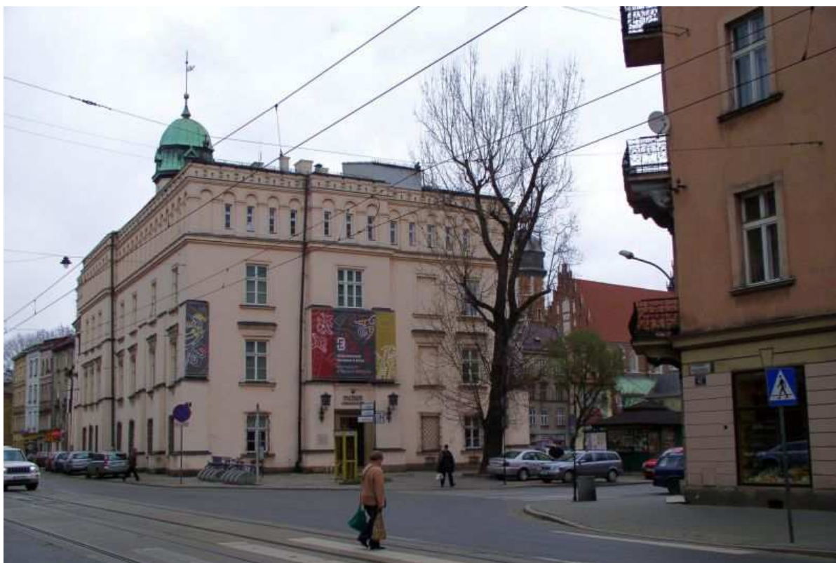
Fot. nr 103. Widok z naroża ulic: Krakowskiej i Skawińskiej. 09.04.11
