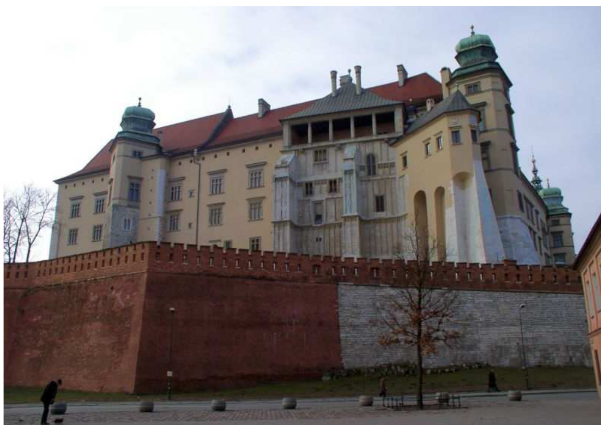
Fot. nr 39 (39-41). Północno-wschodni narożnik zamku – widoki spod kościołka św. Idziego. 07.02.11
