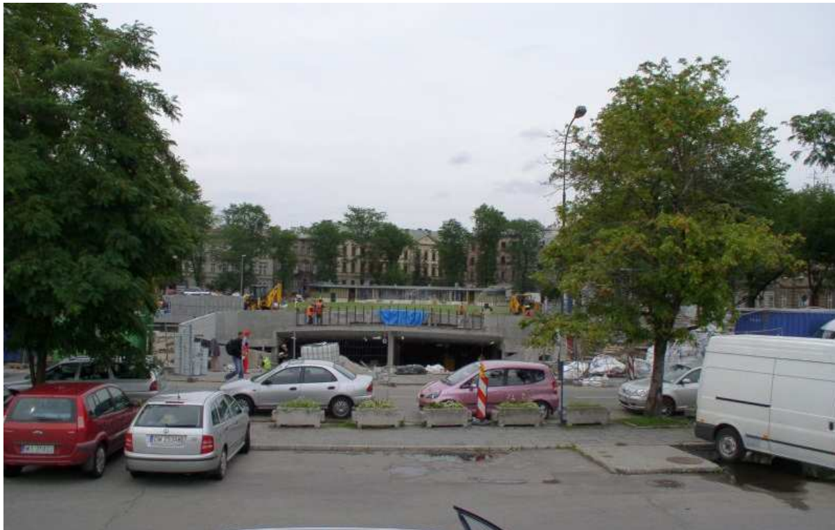
Fot. nr 13. Budowa parkingu podziemnego przy Placu na Groblach. 08.07.09
