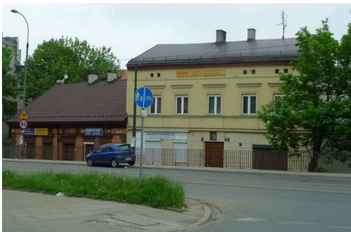
Fot. nr 29. Zachowany do dziś fragment niskiej zabudowy Półwsia z ulicy Kościuszki (nr: 82-84). (11.05.13)
