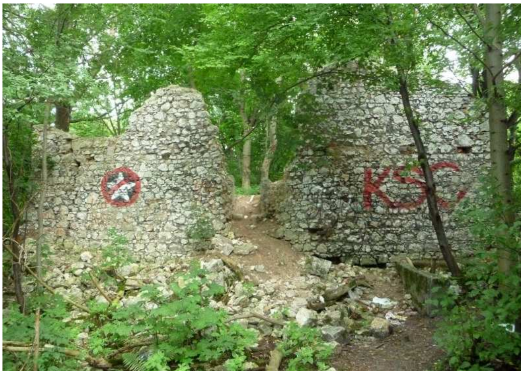
Fot. nr 50. Kolejna ruina budynku gospodarczego z sąsiedztwa stawu. (14.08.13)
