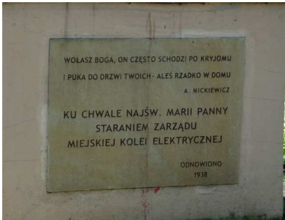
Fot. nr 15. Tabliczka w cokole lica. Można tylko przypuszczać, że sama kapliczka powstała w II połowie XIX-go wieku z przekształcenia dawnej latarni. (17.04.13)
