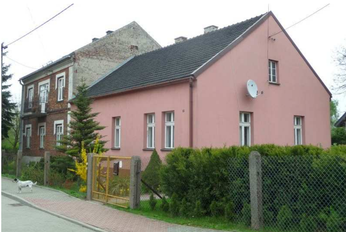
Fot. nr 68. Fragment podmiejskiej zabudowy z ulicy Darasza 12-14. (30.04.13)
