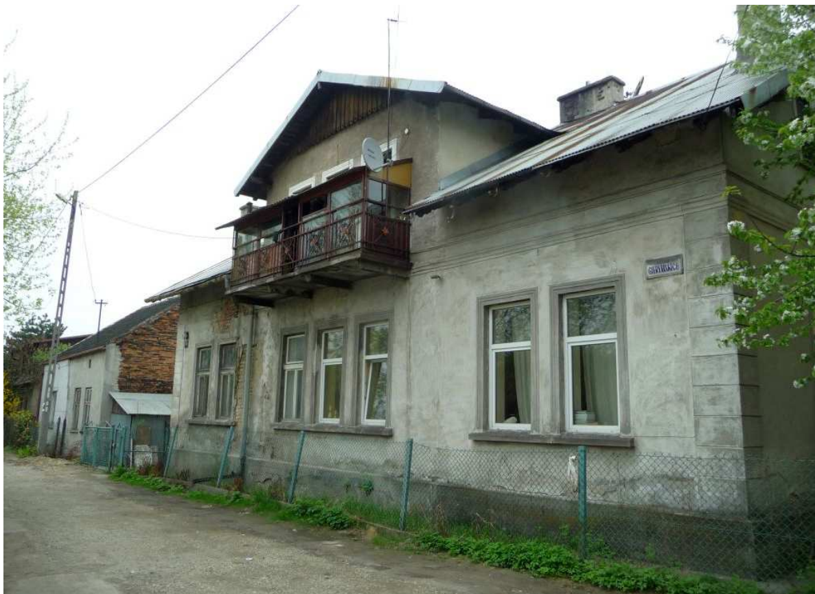
Fot. nr 64. Końcowy fragment ulicy Braci Gierymskich, od ulicy Legionów. (30.04.13)
