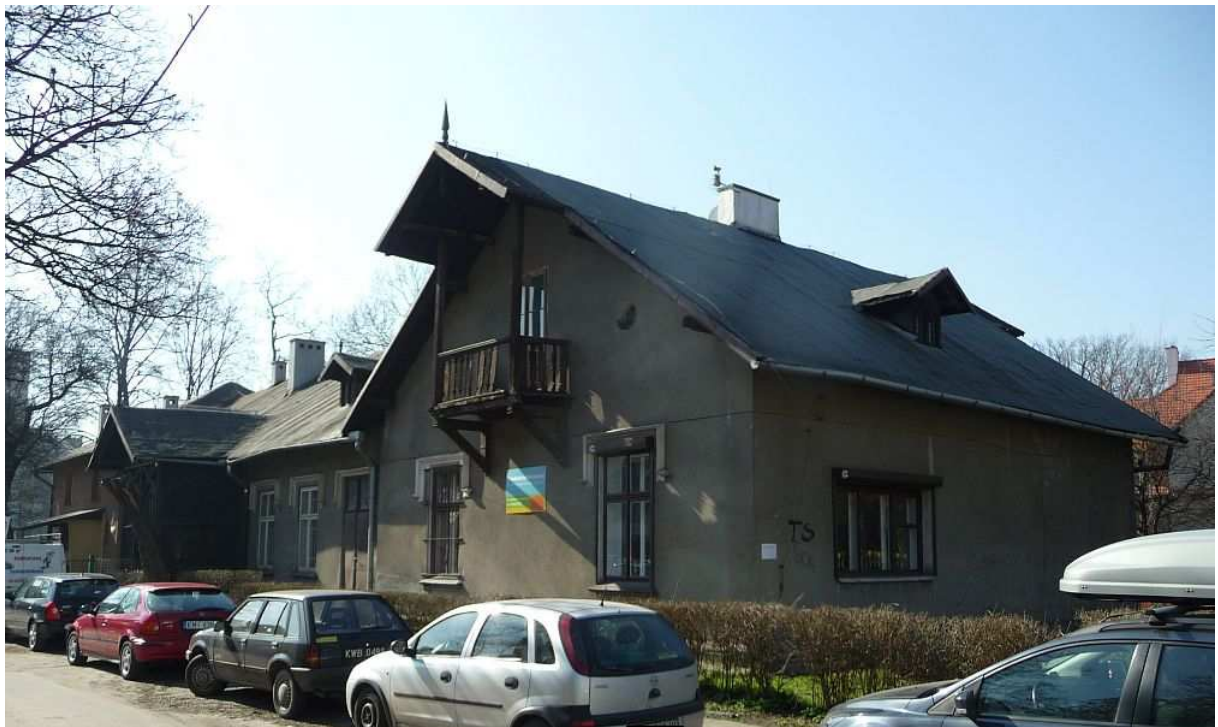
Fot. nr 7. Tylna część podmiejskiej willi z końca XIX-go wieku, wybudowanej dla Heleny Modrzejewskiej przez jej brata Adolfa Opida. Szybko niszczeją jej drewniane detale. (17.04.13)
