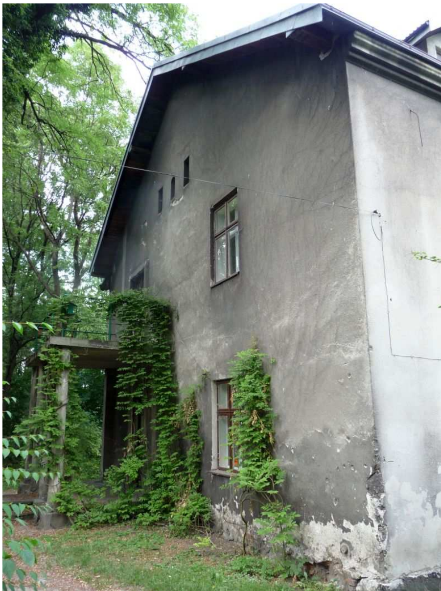
Fot. nr 39 (39-41). Ściana boczna od strony ulicy Estońskiej. (30.08.13)
