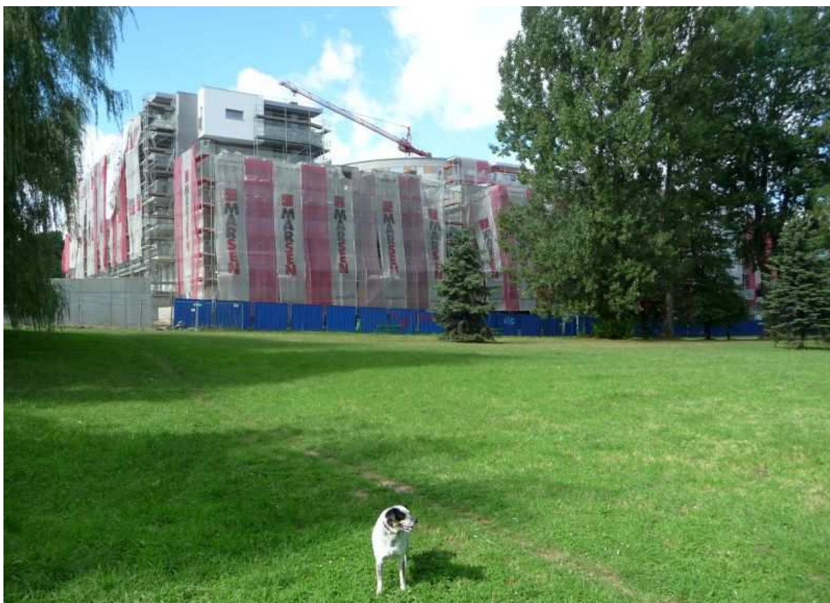
Fot. nr 99. Widok od strony parku. (03.09.2013)
