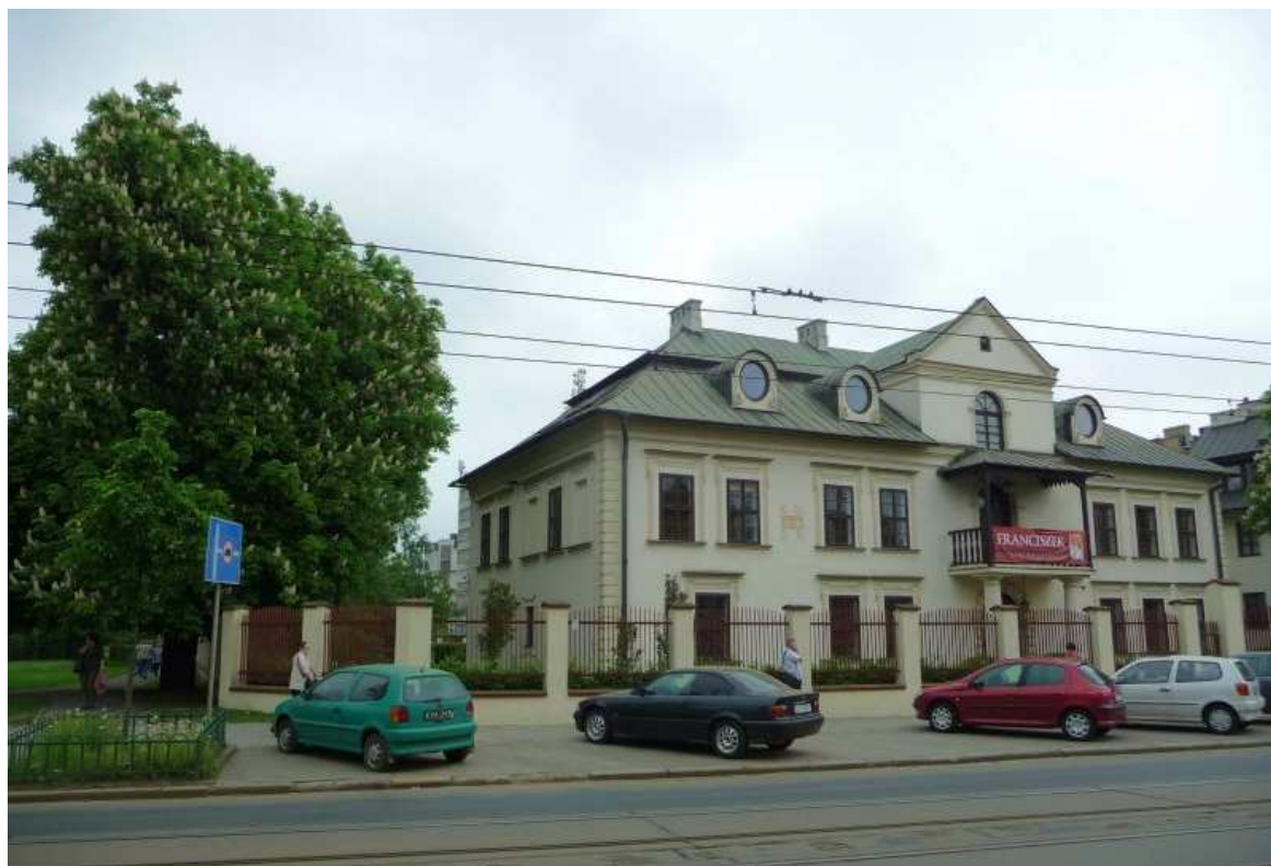
Fot. nr 26. Fasada od strony ulicy Kościuszki. (11.05.13)
