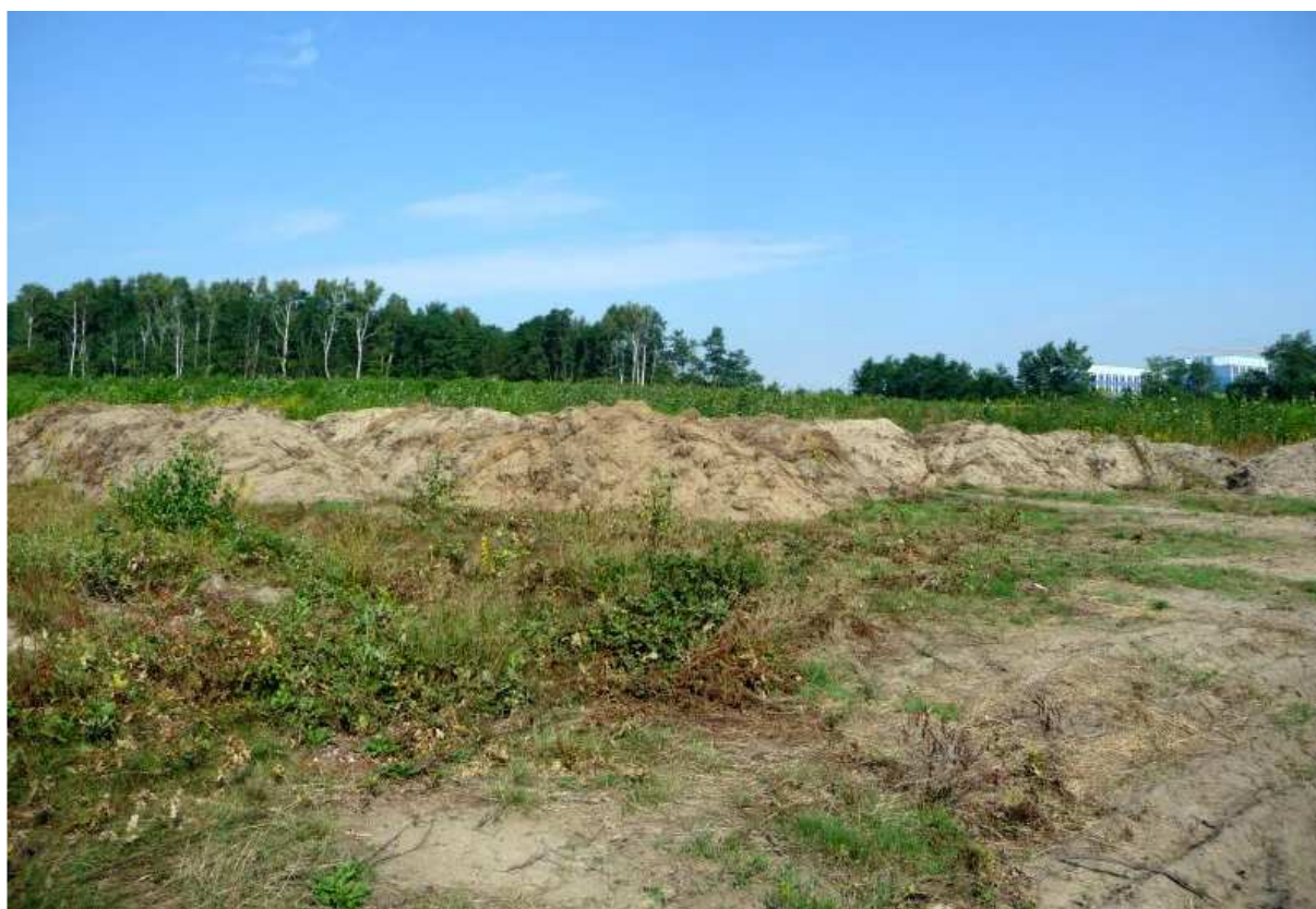
Fot. nr 1b. Z wolna ruszyły prace ziemne przy budowie nowego kompleksu szpitalnego AM w miejscu 40-letniego lasu brzoźowego. W tle szpital pediatryczny. (30.08.13)
