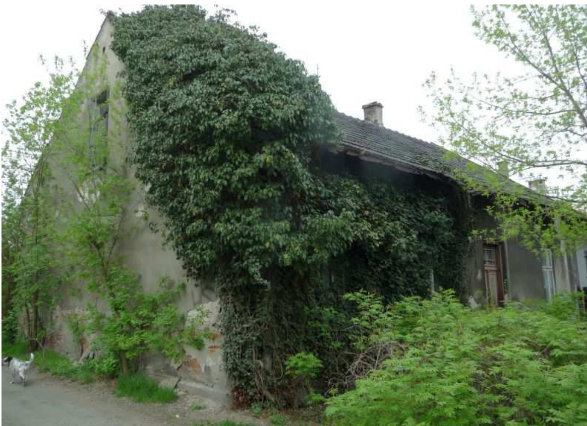
Fot. nr 67. Widok od strony podwórka. Wino powoli zakrywa jego ściany. (30.04.13)
