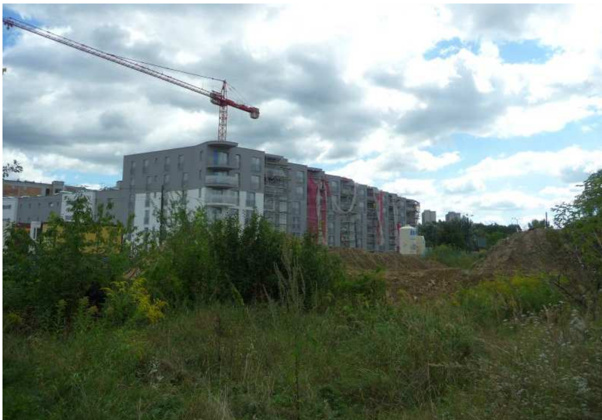
Fot. nr 100. Widok od strony ulicy Żniwnej. (03.09.2013)
