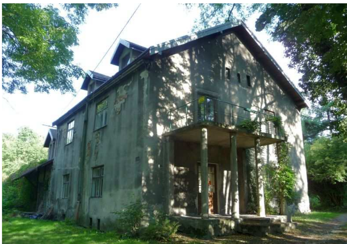
Fot. nr 42 (42-43). Widok dworu z drogi dojazdowej z ulicy Estońskiej. (14.08.13)
