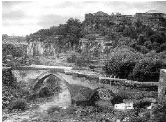
[il.33] Asztarak, trójprzęsłowy most na rzece Kasach, XVIII w.
