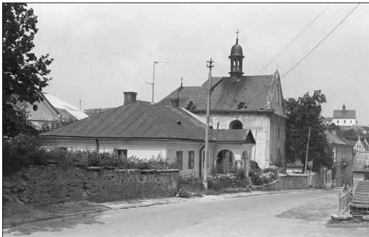
Brzeżany, widok z ulicy Ormiańskiej na plebanię i kościół ormiańskokatolicki. Na wzgórzu w tle kościół i klasztor bernardynów (obecnie więzienie). Fot. J.Chrzęszczewski, 1995.
