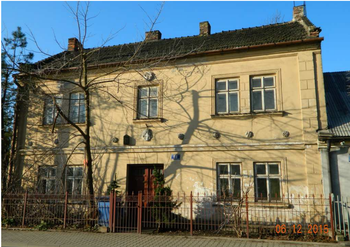
Fot. nr 48 (48-49). Oryginał spod nr 69, który powstał na początku XX wieku, a piętro zostało nadbudowane na początku lat 30-tych.
