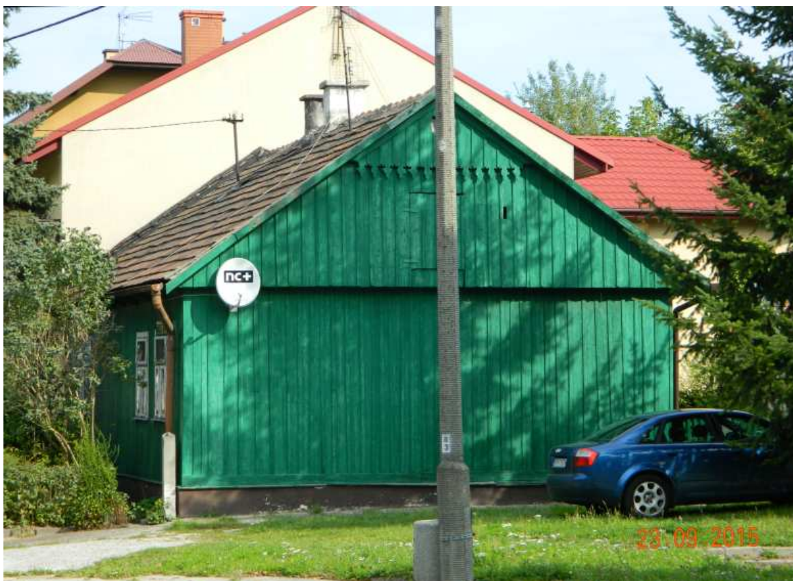
Fot. nr 78 (78-79). Uroczy, podmiejski domek z ulicy Ściegiennego 39.
