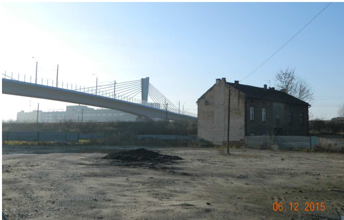
Fot. nr 54 (54-55). Dawny budynek kolejowy z ulicy Żołnierskiej 62, dziś w nowym otoczeniu estakady.
