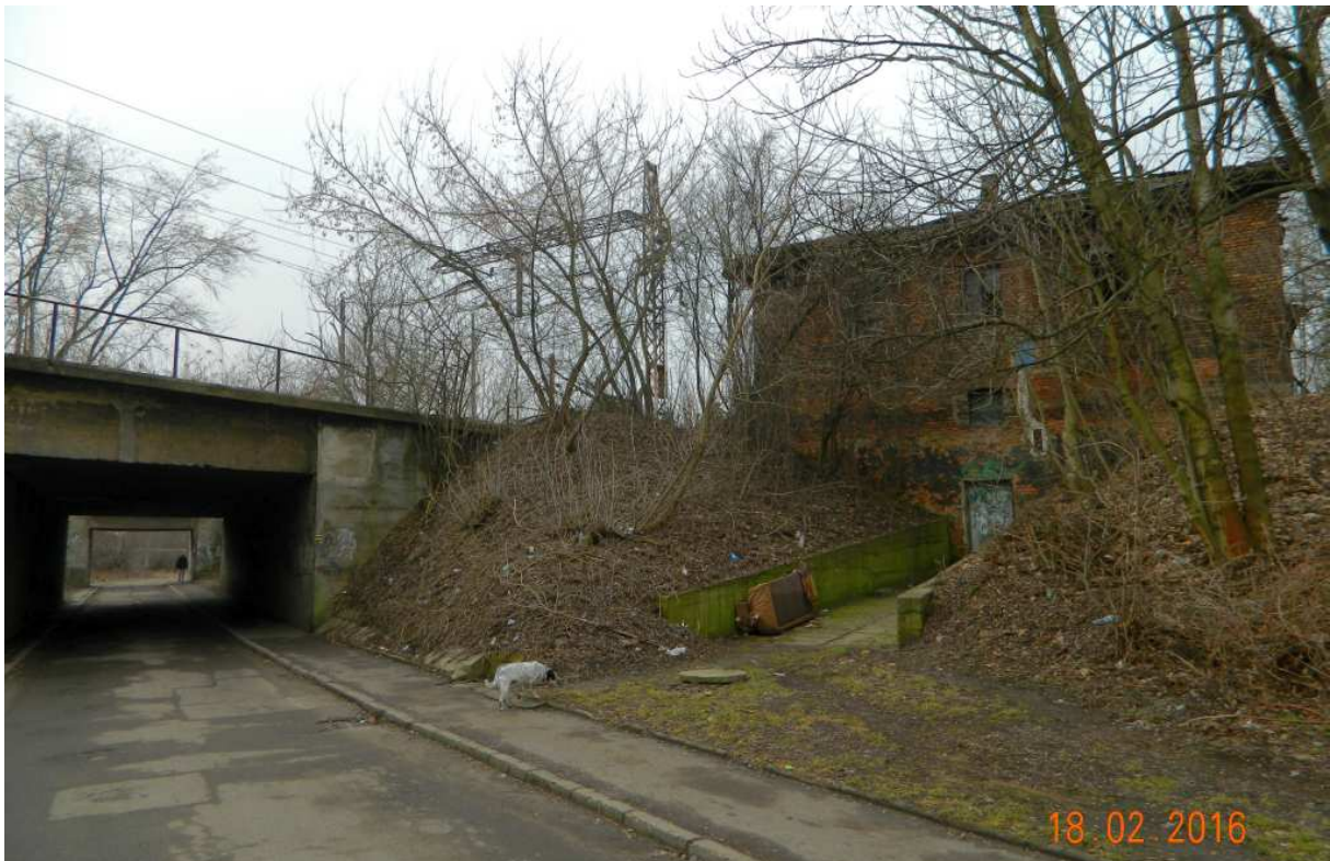
Fot. nr 94. Kolejne przejazdy pod torami wzdłuż ulicy Morawiańskiego na terenie zamierającej stacji rozrządowej w Prokocimiu.
