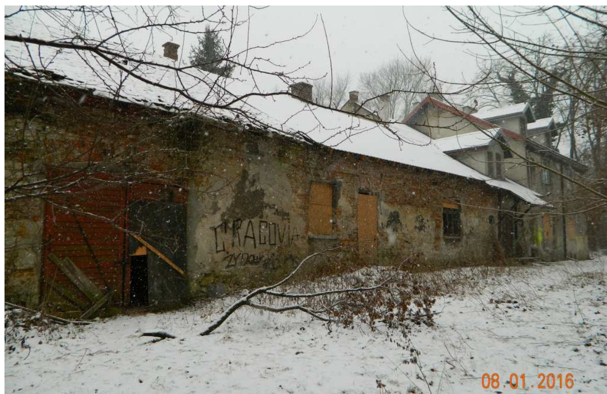
Fot. nr 12c. Dawna wozownia – widok od strony parku.
