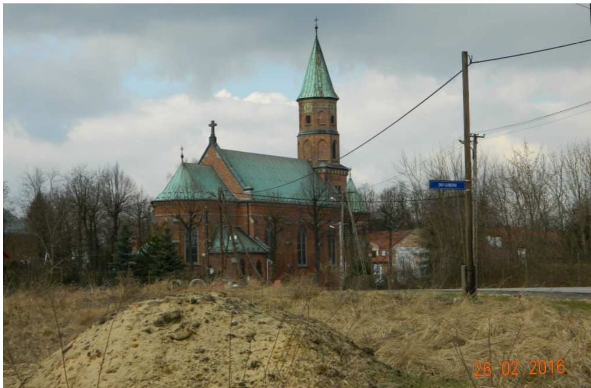
Fot. nr 136. Widok od strony ulicy Do Luboni.
