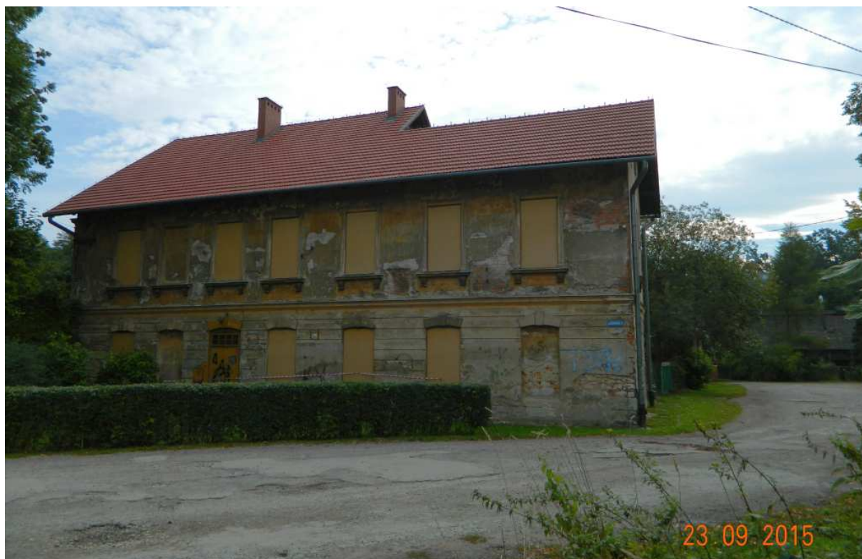
Fot. nr 62 (62-64). Zabudowania tzw. rządówki majątku Jerzmanowskich przy ulicy Górników 29, które powstały w trakcie przebudowy z końca XIX wieku.
