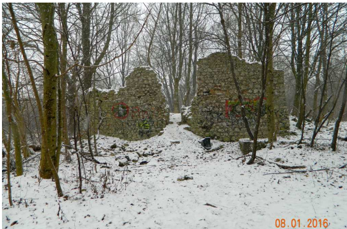
Fot. nr 13. Ruina jednego z pomieszczeń gospodarczych (od strony ulicy Macedońskiej).
