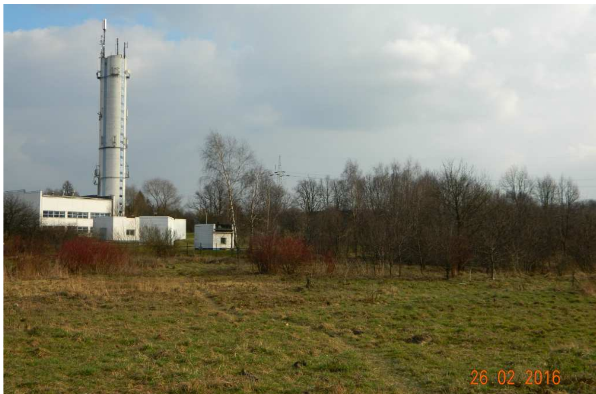
Fot. nr 148. Budynek i wieża rurociągu Raba przy zarośniętym szańcu IS VII/1 z lat 1896-1902, zlokalizowanym przy dawnym przysiółku Poręba, dziś ulicy Biernata z Lublina.
