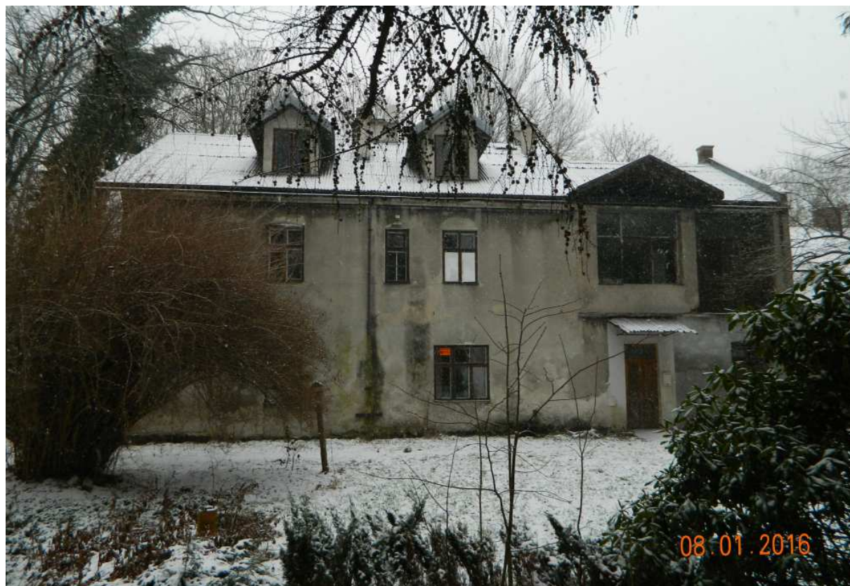
Fot. nr 11(11-12c). Stary dwór Bemów, przebudowany z pomieszczeń dawnego folwarku. Fot. nr: 11-11b. Fasada od strony ulicy Laszczyki
