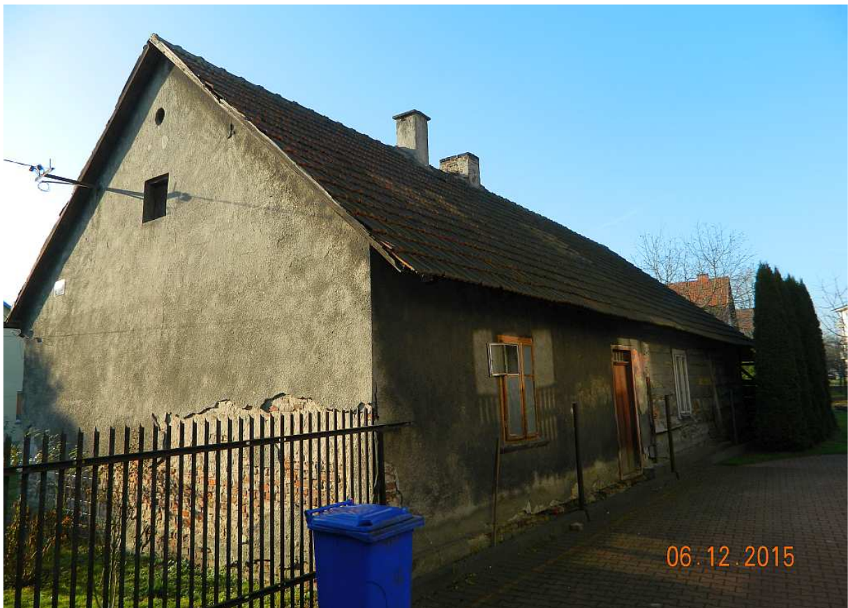
Fot. nr 25 (25-28). W klimacie Płaszowa zapewne z początku XX wieku, a może jeszcze wcześniejszym. Dom z ulicy Gromadzkiej 15, pod którego tynkiem kryje się dawna faktura chałupy, zbudowanej z poziomo ułożonych belek drewnianych.
