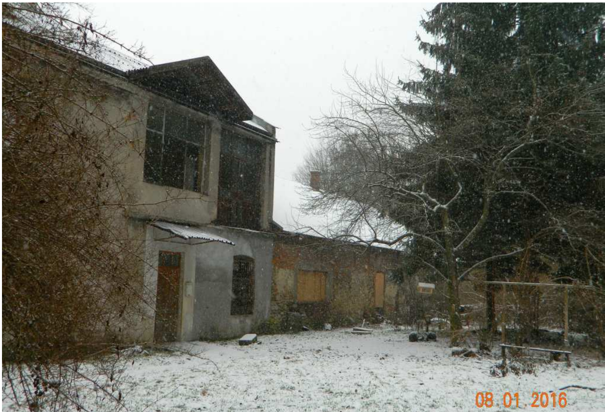
Fot. nr 11b. Dawna wozownia w prawej czesci budynku.
