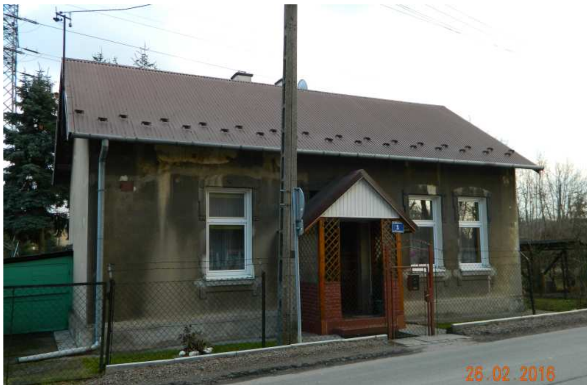
Fot. nr 137 (137-138). Zapewne „dyżurka” z okresu Twierdzy Kraków na początku ulicy Niebieskiej, przy pobliskim schronie amunicyjnym.
