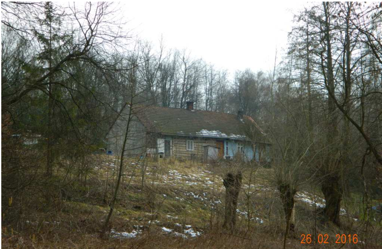
Fot. nr 152 (152-154). Kilka ujęć archaicznej chałupy z ulicy Szczawnickiej 50(?).
