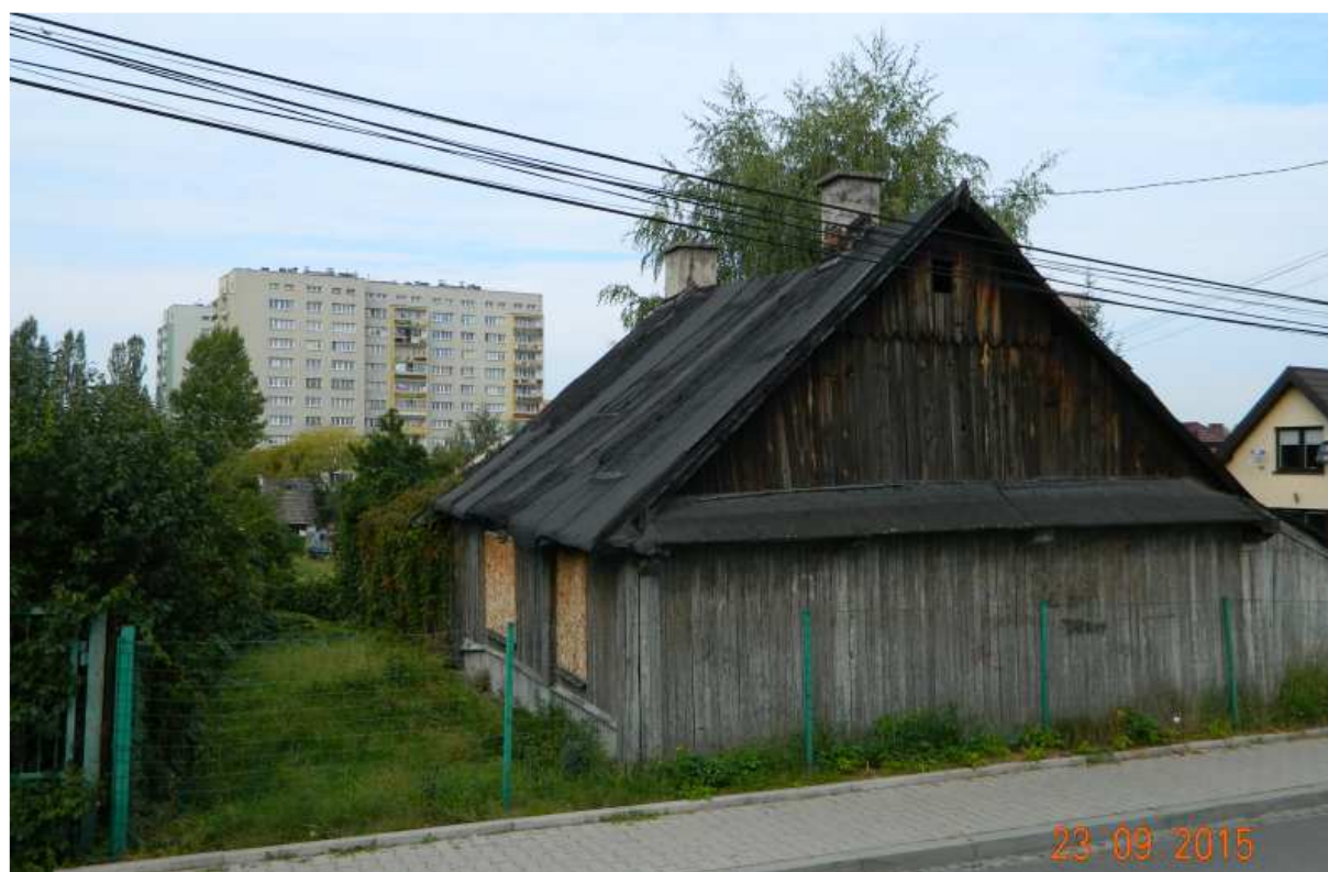
Fot. nr 76 (76-77). Mocno już podupadła chałupa z ulicy Ściegiennego 12.
