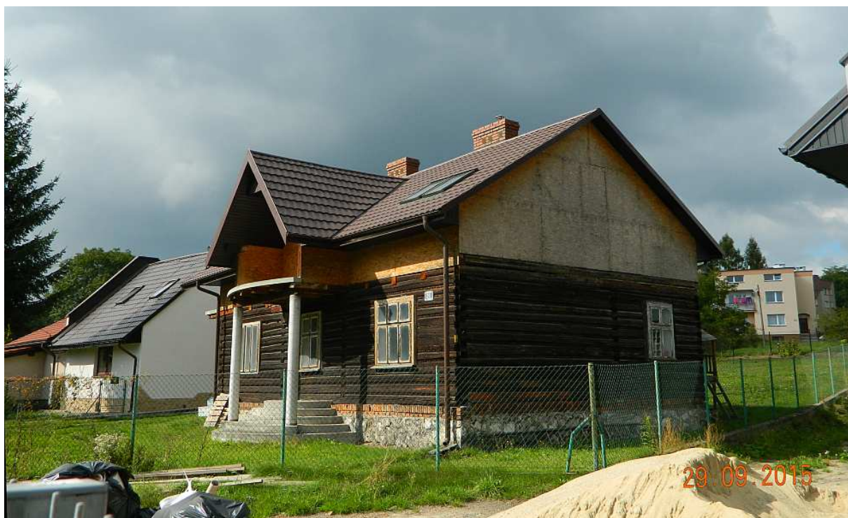
Fot. nr 104 (104-105). Solidny, zapewne międzywojenny dom z ulicy Kosocickiej 20 w trakcie generalnej przebudowy.
