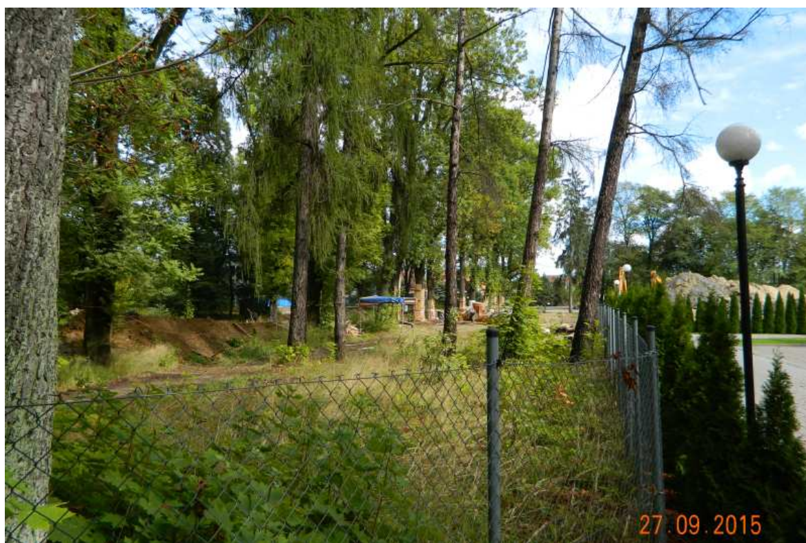
Fot. nr 254. Pod koniec września przy strzelnicy trwały dopiero prace ziemne.
