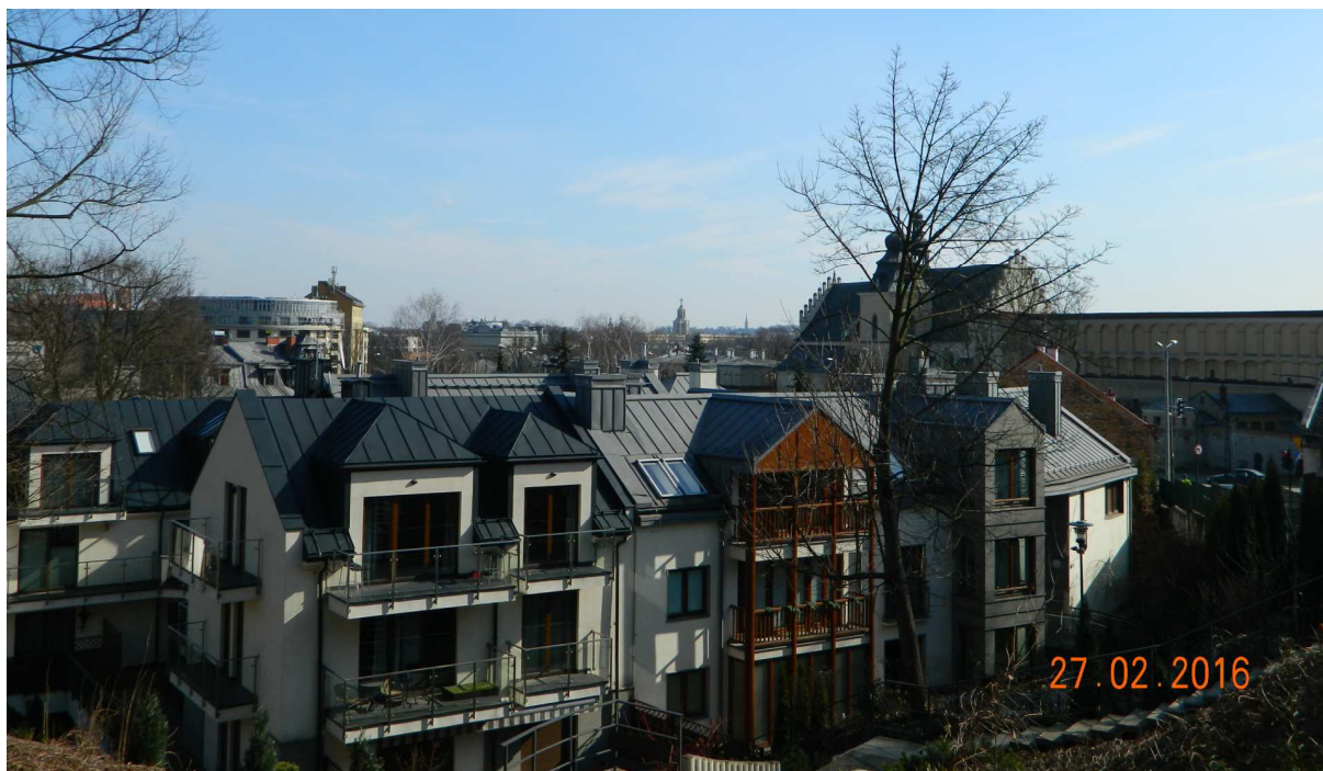
Fot. nr 19. Współczesny fragment ulicy Królowej Jadwigi pod nr 6, która to zabudowa wryła się we wzgórze kościelne (św. Salwatora), naruszając jego stabilność. Wcześniej, jeszcze w latach 90-tych, stał tu stylowy dom pana Boby, miejscowego dekarza. Kiedy inwestor musiał się tłumaczyć, że wrył się w stok i spowodował niebezpieczne jego pęknięcia, miał odpowiedzieć, że to wina zakonników, że budowali kościoły na wzgórzach. Tyle tytułem anegdoty usłyszaną od Pana Michała Koziola.
