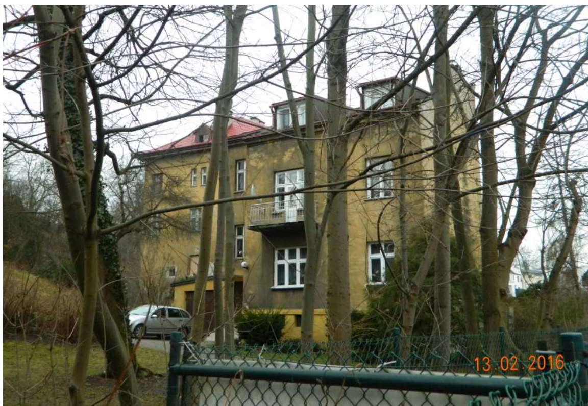
Fot. nr 145. Przedwojenne kamienice pod numerami: 92 i 94.
