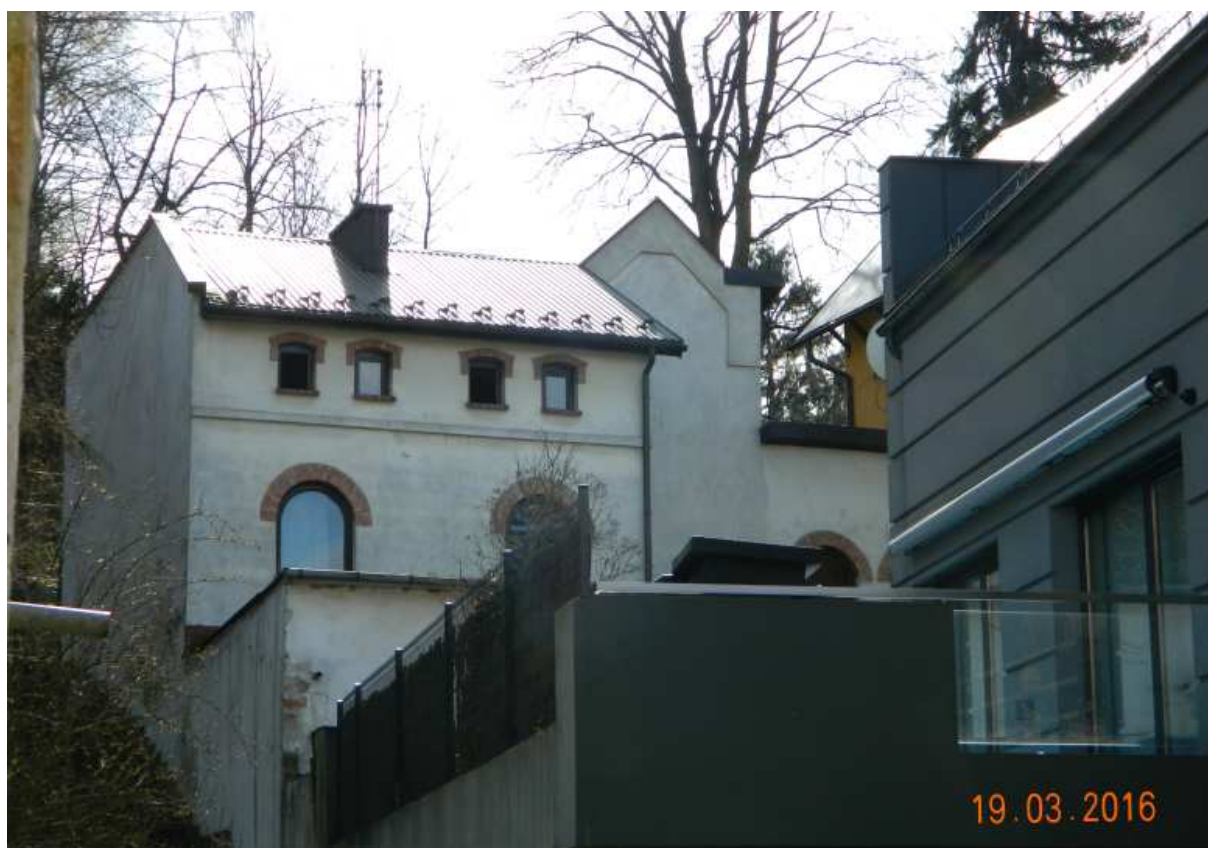
Fot. nr 140 (140-141). Nieodległa od oryginału romantyczna willa pod nr 76, która powstała w latach 1905-1912 wg projektu Józefa Wilczyńskiego. Niełatwo dostrzec ją w całości z ulicy, skąd kiedyś przyciągała wzrok
