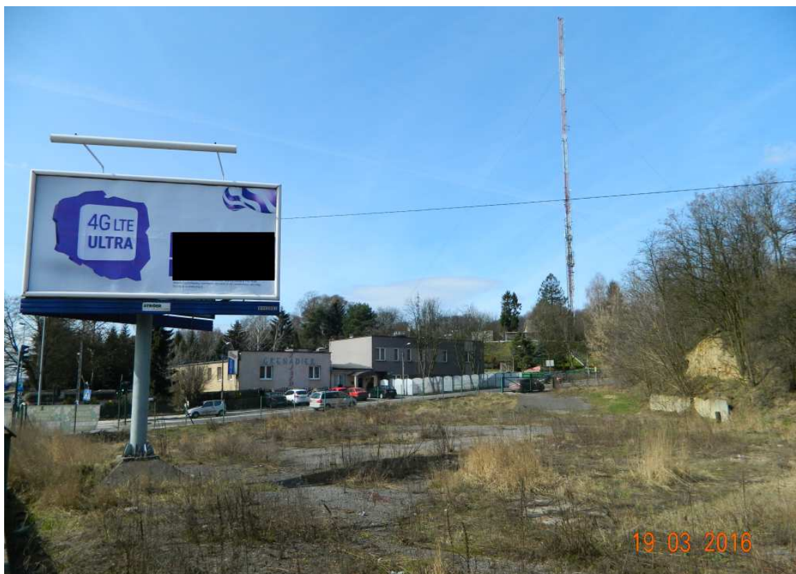
Fot. nr 58. Widok na maszt krakowskiej radiostacji, wybudowanej w roku 1927.
