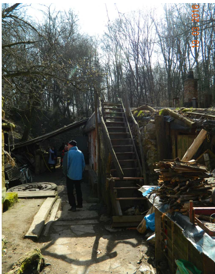
Fot. nr 208 (208-209). Schody na dach bunkra.
