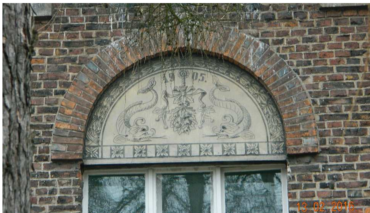
Fot. nr 280. Sgraffiti nad oknem I piętra ryzalitu. (1905)
