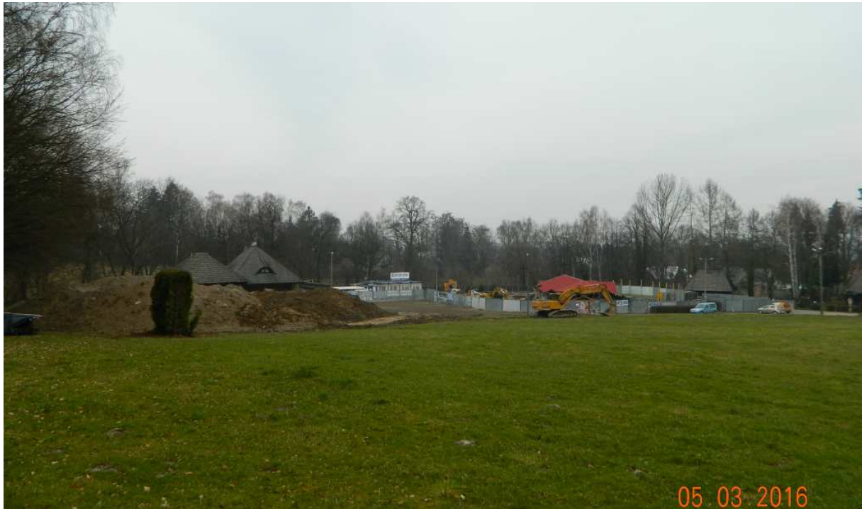
Fot. nr 291 (291-293). Plac Budowy – widoki z ulicy Cisowej.
