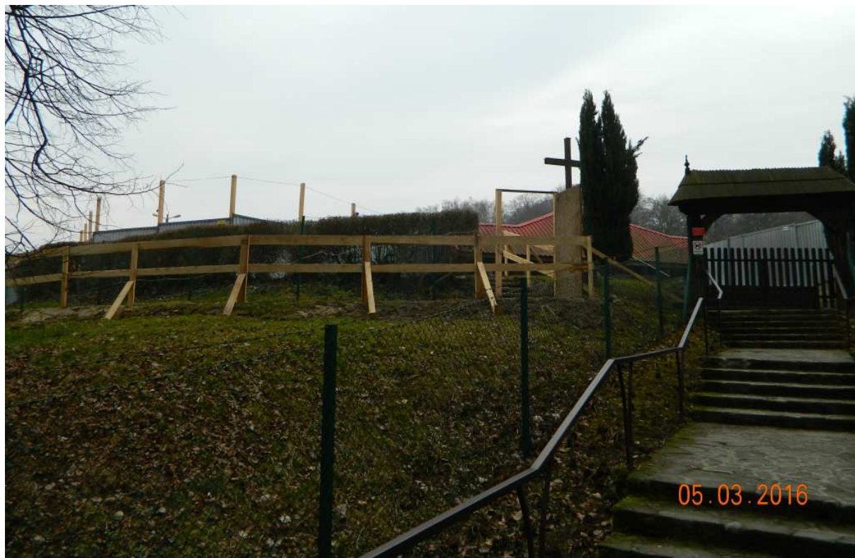
Fot. nr 289. Mimo oporów i protestów wielu krakowskich środowisk, rozpoczęła się budowa nowego kościoła, który stanie na miejscu dwukrotnie spalonych, drewnianych świątyń i będzie konstrukcją murowaną. W bliskości powstanie też murowana plebania.
