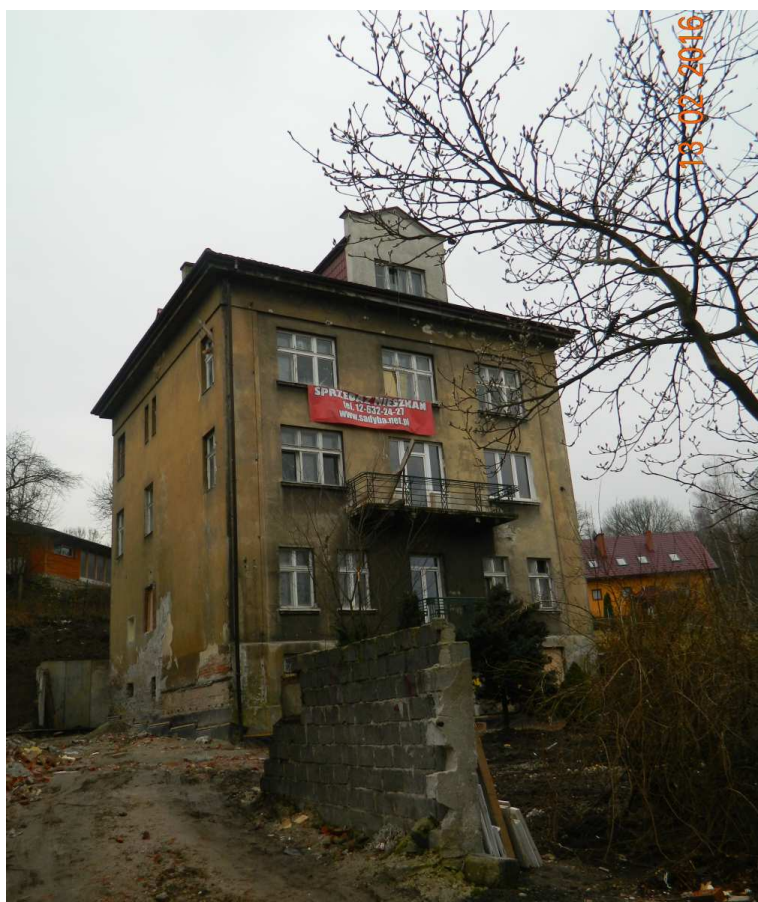
Fot. nr 146 (146-147). Fasada międzywojennej kamienicy spod nr 94.
