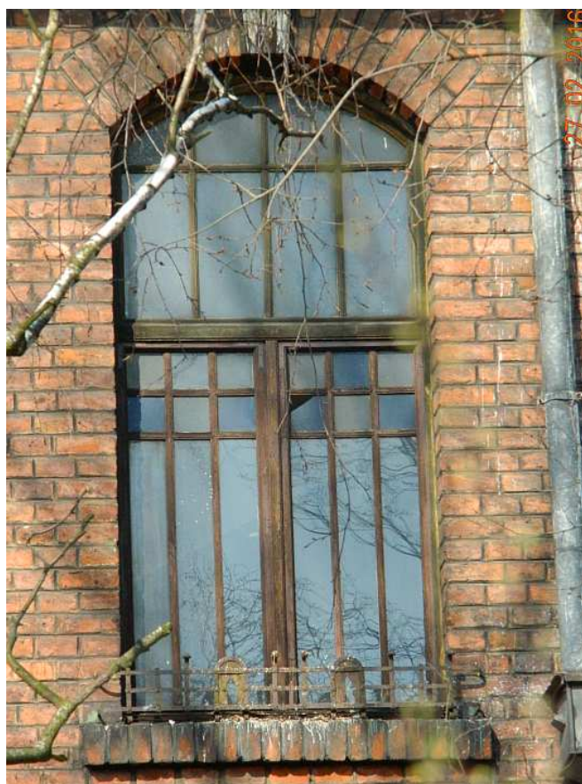
Fot. nr 9 (9-10). Oryginalne okna mozaikowe.
