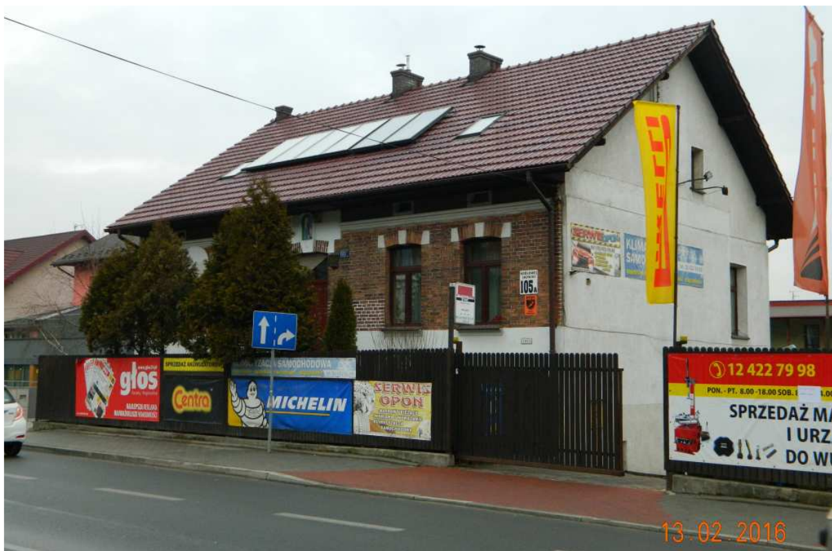
Fot. nr 156 (156-158). Ponad stuletni, bliski oryginałowi dom spod nr 105a, wybudowany około 1900 roku.
