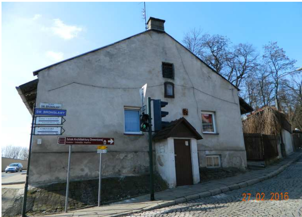
Fot. nr 29 (29-31). Dom „Pod Motylami” z ulicy św. Bronisławy 1/Księcia Józefa 1. Okienko na parterze przypomina o funkcjonującym w nim kiedyś warsztacie szewca. Nazwa pochodzi od malowidła nad drzwiami wejściowymi od strony ulicy Ks. Józefa.
