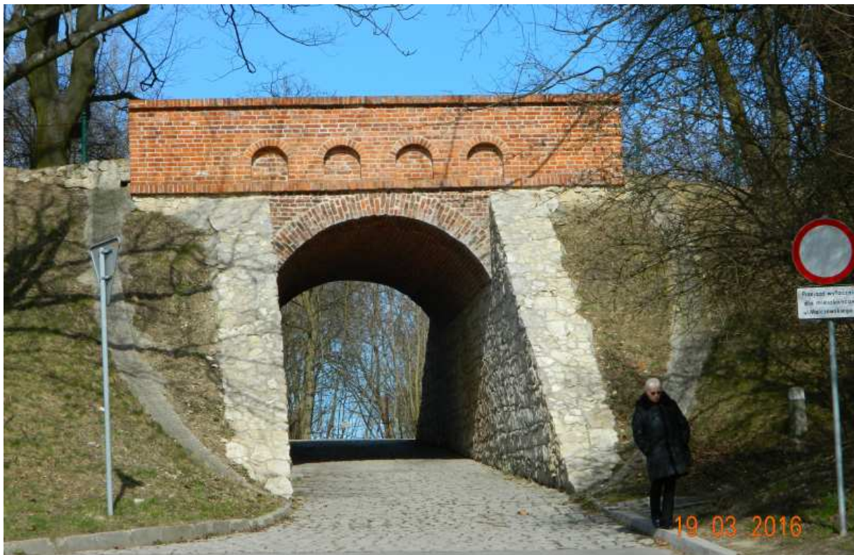
Fot. nr 65 (65-66). Diabelski Most pod Aleją Waszyngtona – dwupoziomowe skrzyżowanie z czasów Twierdzy Kraków.
