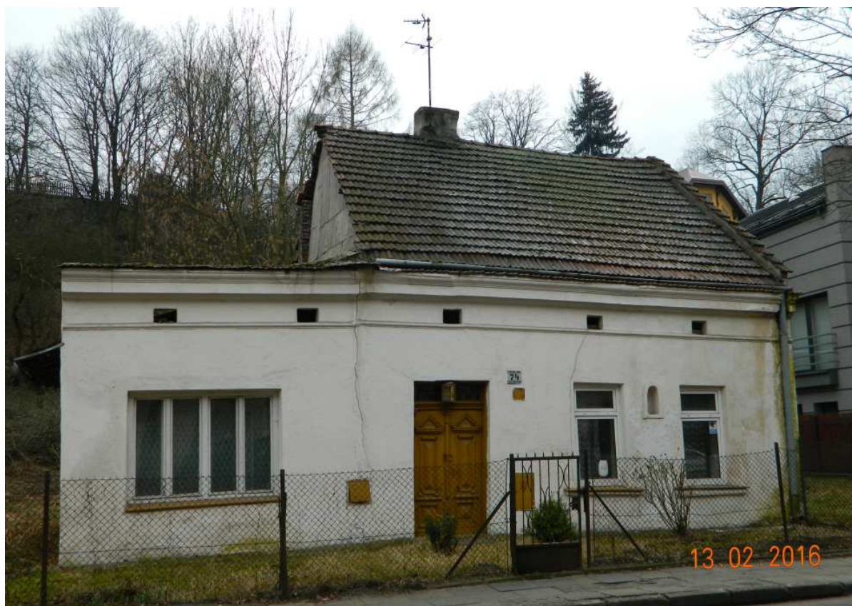
Fot. nr 138 (138-139). Ciągłe zamieszkały domek Bobów spod nr 74, w którym tylko drzwi są oryginalne. Wg Staszka Malika jeszcze w latach 90-tych wypasali oni krowy na Błoniach.
