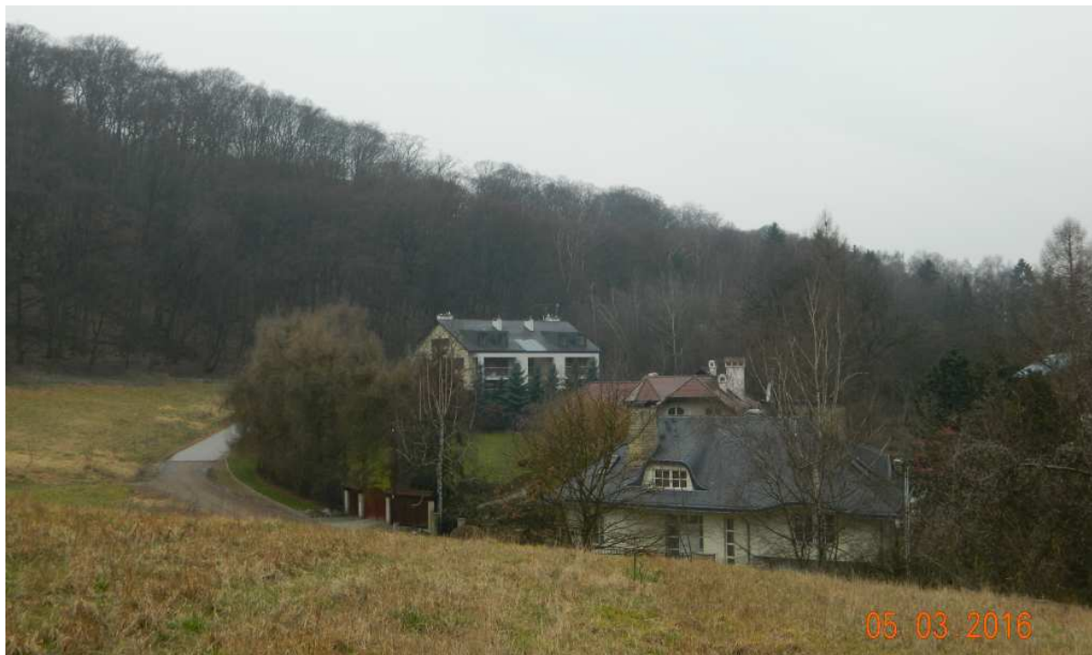
Fot. nr 275. Zabudowa ulicy Kopalina niemal wdziera się do Lasu u stóp Wesołej Polany.
