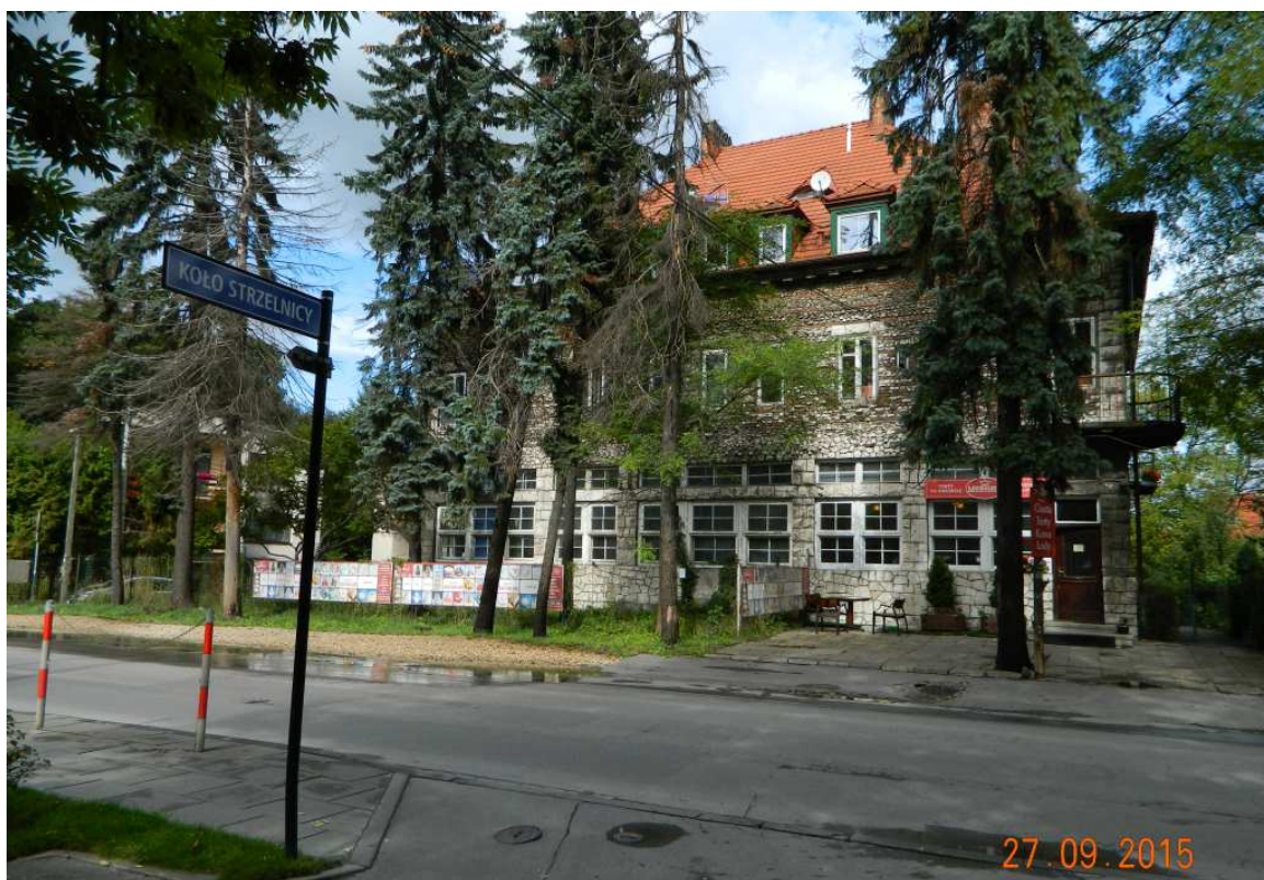
Fot. nr 253. Przedwojenna willa być może autorstwa Szyszko-Bohusza z ulicy Królowej Jadwigi 195 w narożu z ulicą Czeremchową 1.
