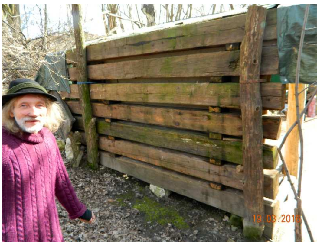
Fot. nr 202. Ściana oporowa na podworku.
