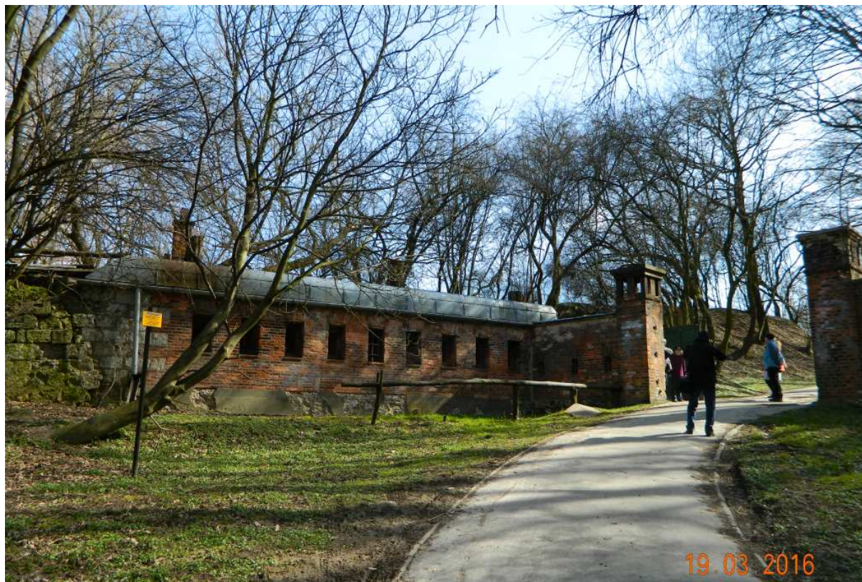
Fot. nr 78. Gdyby jeszcze istniała dawna, metalowa brama.....
