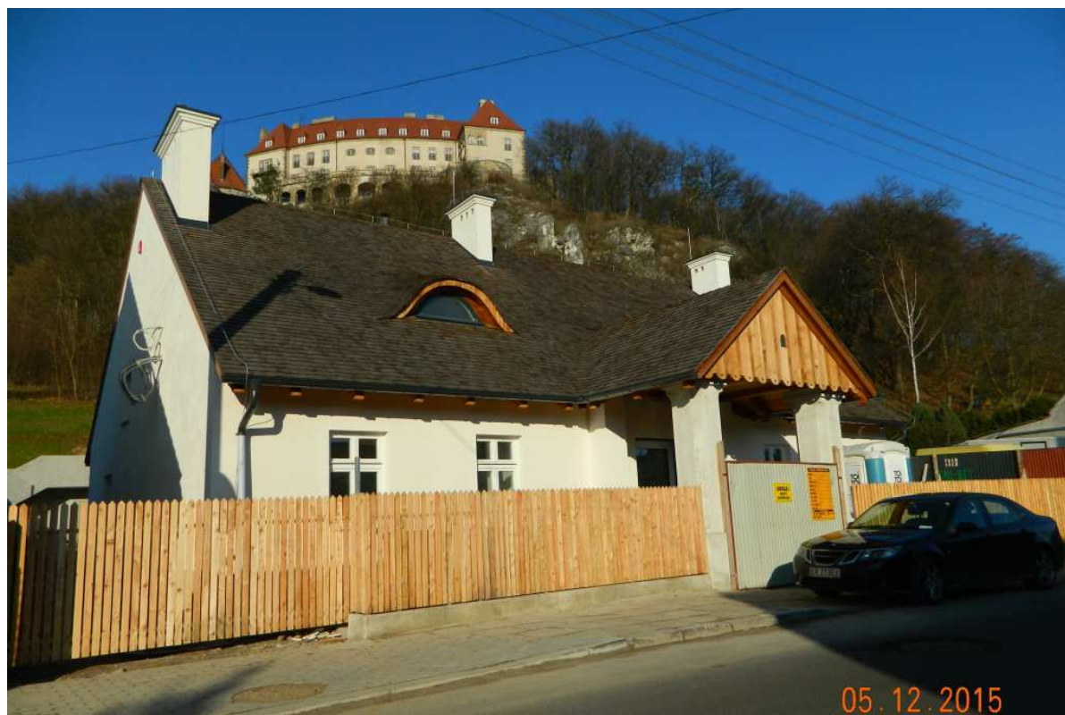
Fot. nr 296(296-298). Po latach zaniedbań stara przegorzalska karczma odzyskuje blask.
