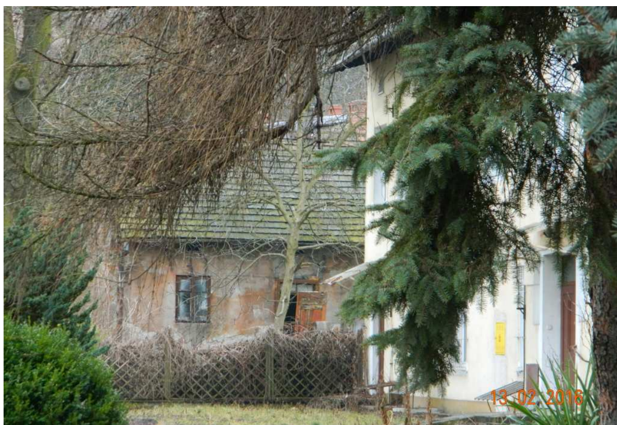
Fot. nr 120. Tylna część domu. Widok z ulicy Emaus.
