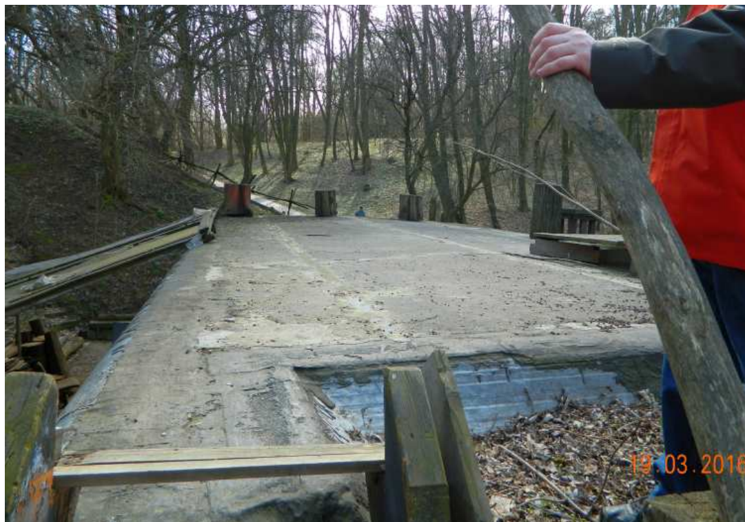
Fot. nr 80. Dach ostrogu.
