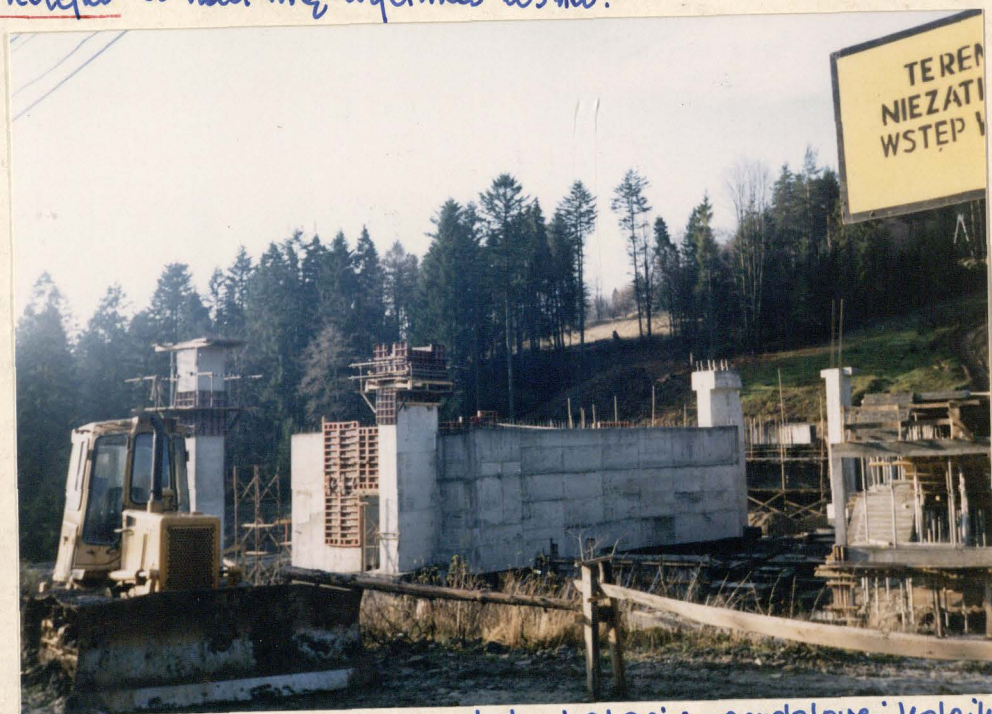
10 list. 1996r. Budowa dolnej stacji gondolowej kolejki.
