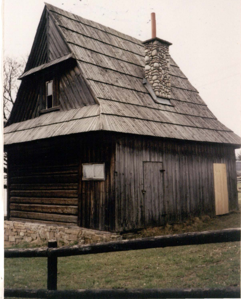
..... dom drewniany ale komin z kamienia!
