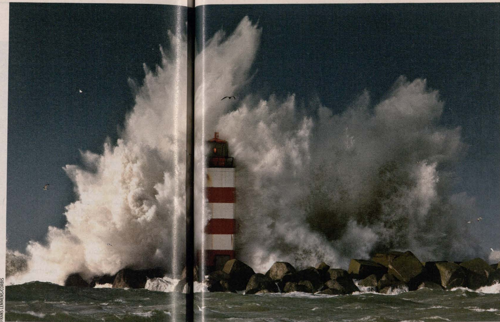
Północny Atlantyk wyprzedza zmiany klimatyczne na globie. I niemal na pewno je przyspiesza. Czekają nas niszczące wybrzeża powodzie sztormowe.
