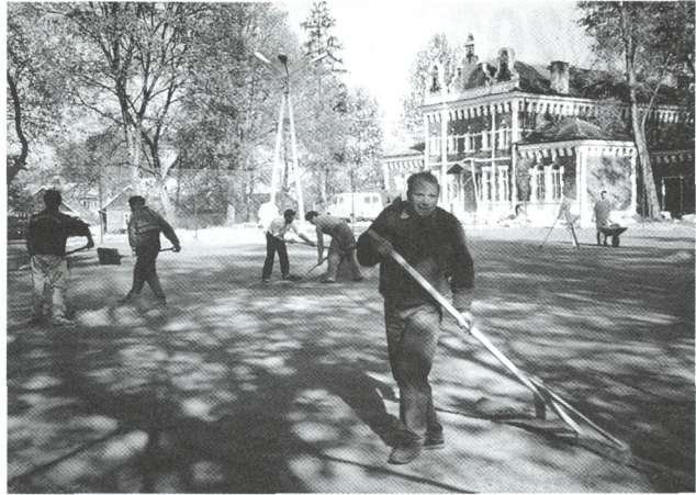
Budowa kortów tenisowych przy Sokolni
