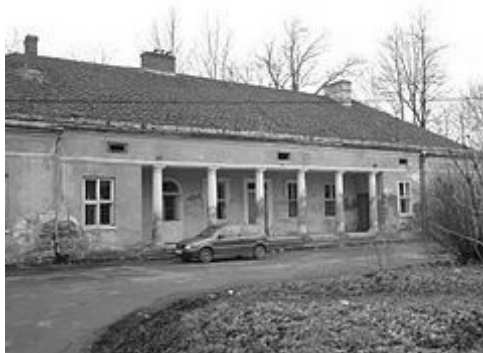
Dworek w Tarnowcu – stan obecny
