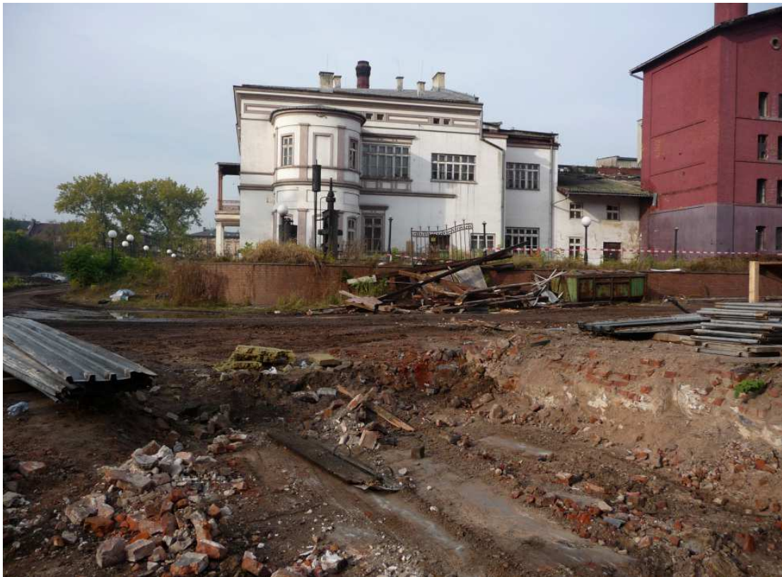
Fot. nr 229 (229-235). Ujęcia różnych faz budowy z ulicy Strzeleckiej, z sąsiedztwa szpitala dziecięcego im. św. Ludwika. (27.10.2011)
