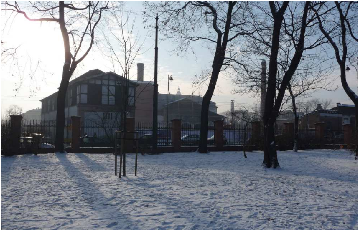
Fot. nr 302 (302-304). Ujęcia przestrzeni dawnego Browaru Kraków z Ogrodu Strzeleckiego. Tu na etapie burzenia. (23.12.2011)
