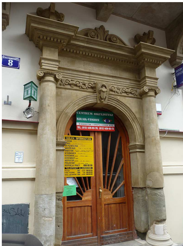
Fot. nr 66. Wykonany z kamienia portal drzwi wejściowych. (26.07.2011)
