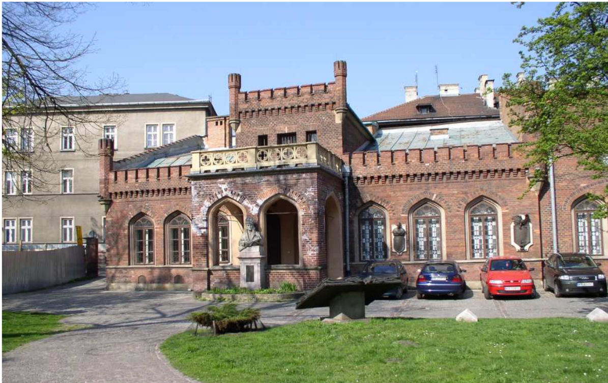
Fot. nr 309 (309-313). Kilka ujęć detali fasady. (21.04.2011)
