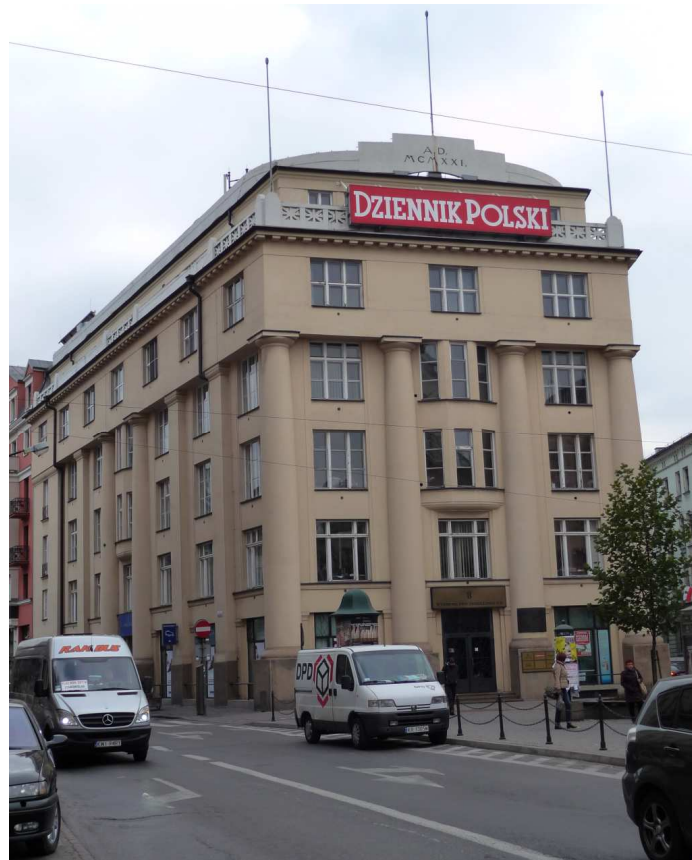
Fot. nr 43 (43-43a). Pałac Prasy spod nr 1, czyli popularny „Kurierek”. Data jego powstania (a.d. 1921) widoczna jest na zwieńczeniu fasady. Zwyczajowa nazwa – „Kurierek”, jest wspomnieniem Ilustrowanego Kuriera Codziennego (IKC), koncernu prasowego zwanego „Ikacem”, który pierwotnie miał tu swoją siedzibę. (10.11.2011)
