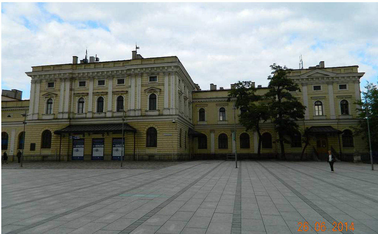
Fot. nr 281. Prawe skrzydło.
