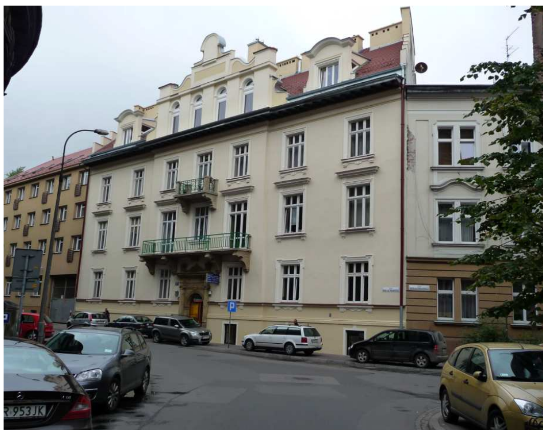
Fot. nr 65 (65-66). Kamienica o cechach neorenesansowych spod nr 8, wybudowana w latach 1905-1906 wg projektu Józefa Pakiesa. (26.07.2011)
