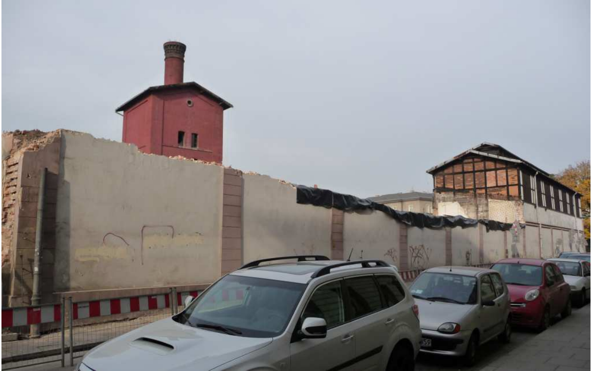
Fot. nr 244 (244-245). Ujęcia z ulicy Strzeleckiej przez burzony mur. (27.10.2011)
