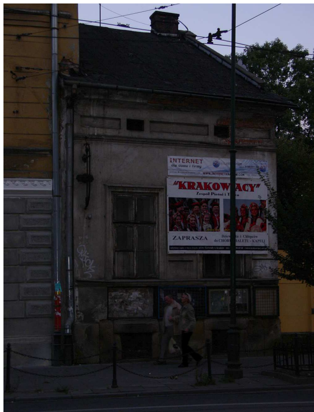
Fot. nr 10 (10-15a). Niestniejacy już domek spod nr 5, który powstał na początku XX w. Jego urok wynikał z prostoty i oryginalnych okien o cienkich szprosach. (25.09.2011)
