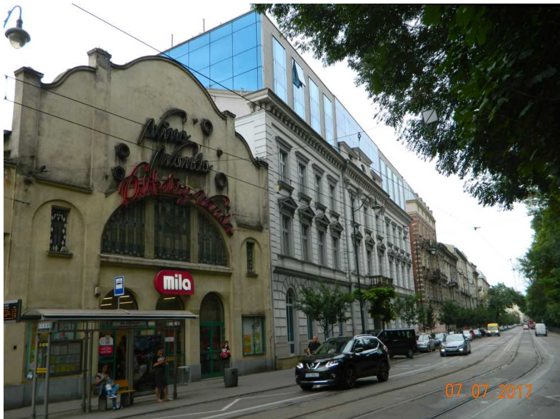
Fot. nr 20. Fragment ulicy Gertrudy od dawnego kina Wanda po ulicę Sarego. Na pierwszym planie kamienica pod nr 7, z dobudowanym szklanym „pióropuszem”, gdzie funkcjonuje hotel Monopol (kiedyś Kleina). Oryginał pochodził z roku 1876 i został zaprojektowany przez Filipa Pokutyńskiego i Józefa Niedźwieckiego.
