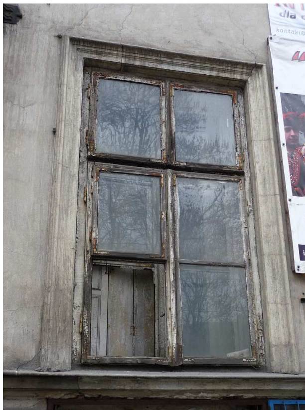
Fot. nr 12a. Oryginalne okno otwierana na zewnątrz z uchylną środkową kwaterą. Rzadkość była to wyjątkowa. (23.11.2011)
