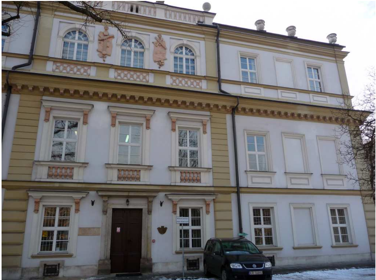
Fot. nr 218. Prawe skrzydło. (23.12.2011)
