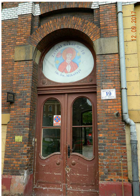
Fot. nr 348. Wizerunek patrona nad wejściem do budynku.
