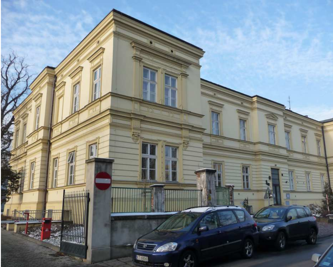
Fot. nr 224. Lewe skrzydło. (23.12.2011)
