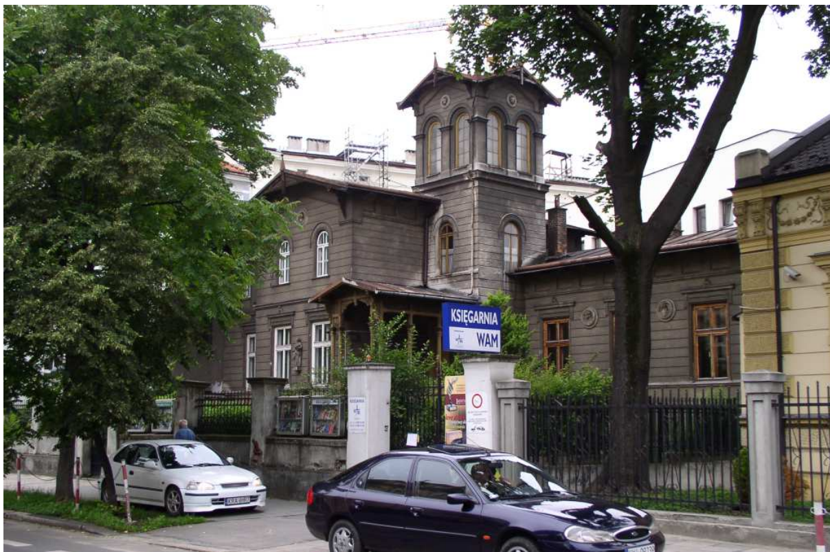
Fot. nr 152. Stan fasady sprzed remontu. (29.06.2009)
