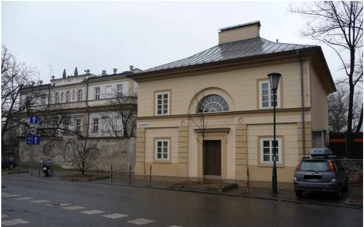
Fot. nr 211 (211-212). Widoki na Collegium Śniadeckich UJ i prawą oficynę. (09.03.2012)
