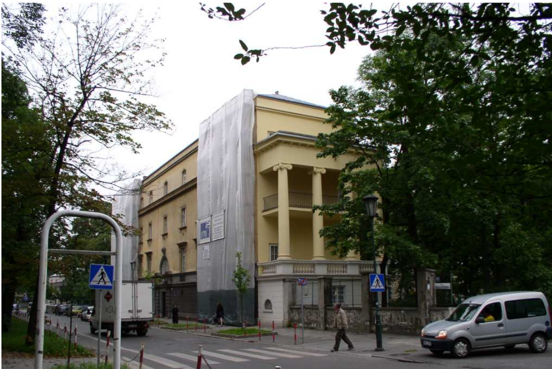
Fot. nr 203 (203-206). Szkoła pielęgniarek spod nr 25, wybudowana w latach 1923-24 Jerzego Struszkiewicza i Maksymiliana Burstina. (29.06.2009)
