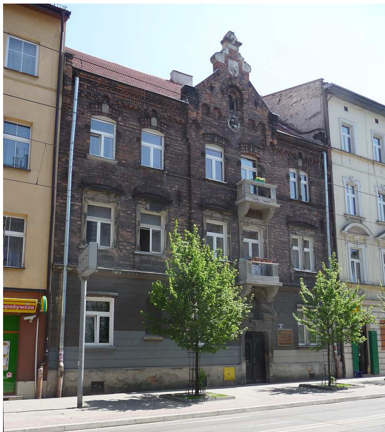
Fot. nr 336. Kamienica z przełomu wieków XIX i XX z ulicy Rakowickiej 21, której projektantem był Teodor Talowski. Została oddana do użytku w roku 1891. (18.05.12)
