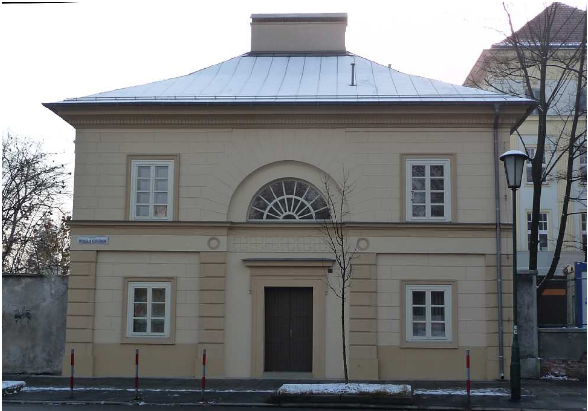
Fot. nr 208 (208-210). Prawa oficyna pod nr 27. (23.12.2011)
