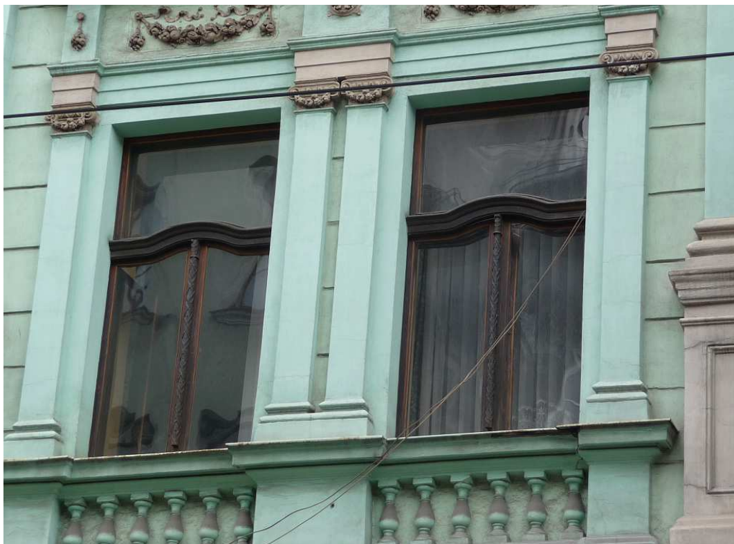
Fot. nr 24c. Rzecz niezwykła – po remoncie zostały zachowane oryginalne okna drewniane z detalami. Brawa dla inspektora nadzoru. (16.07.2012)
