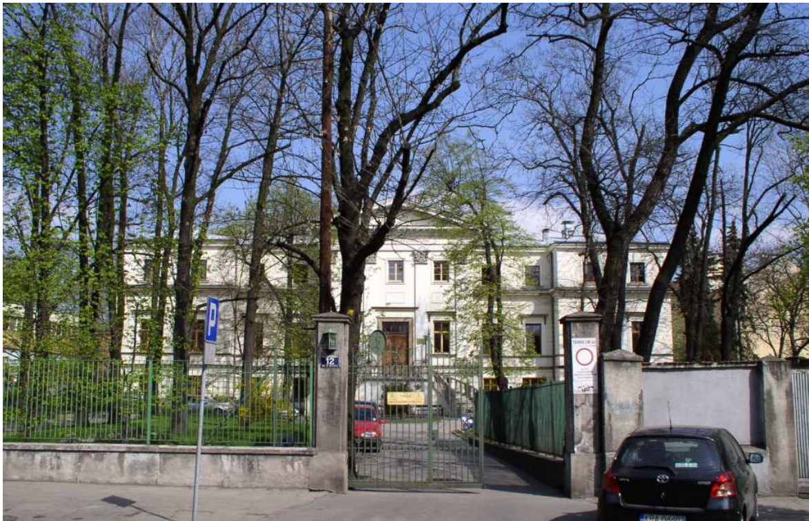
Fot. nr 117. Budynek Theatrum Anatomicum UJ spod nr 12. Początkowo jednopiętrowy powstał w latach 1869-1872 według projektu Feliksa Księżarskiego. (17.04.2009)
