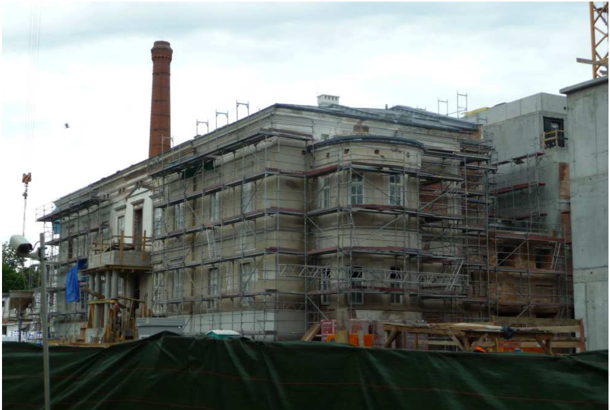
Fot. nr 238. Remont pałacu. (12.06.2013)
