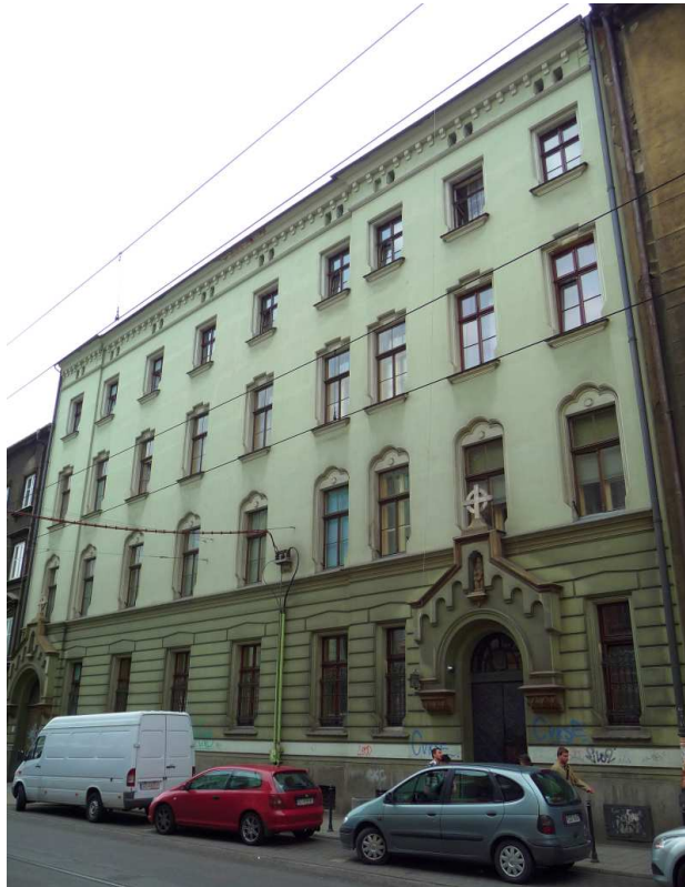
Fot. nr 36. Budynek klasztorny sióstr Urszulanek spod nr 9, który powstał w latach 1894-94 wg projektu Rajmunda Meusa i Bronisława Górskiego. (16.07.12)
