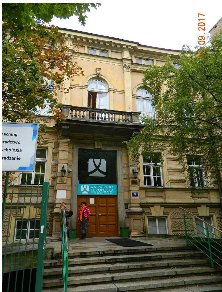
Fot. nr 88. Nieprzysłonięty drzewami fragment pałacu Walerego Rzewuskiego, znanego krakowskiego fotografa, z ulicy Westerplatte 11, którego neorenesansowa bryła powstała w latach 1864-67 wg projektu Feliksa Księżarskiego.
