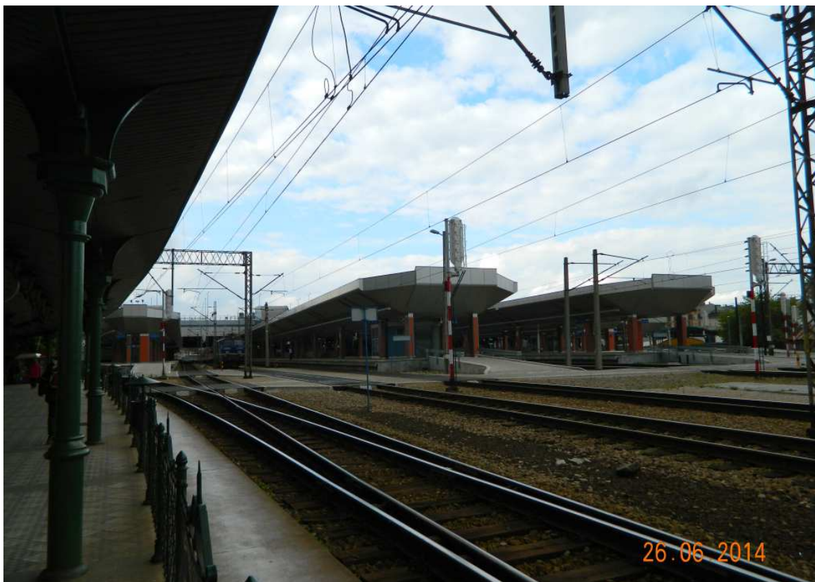
Fot. nr 283 (283-288). Widoki z peronów. Tu zadaszone perony nowego dworca.
