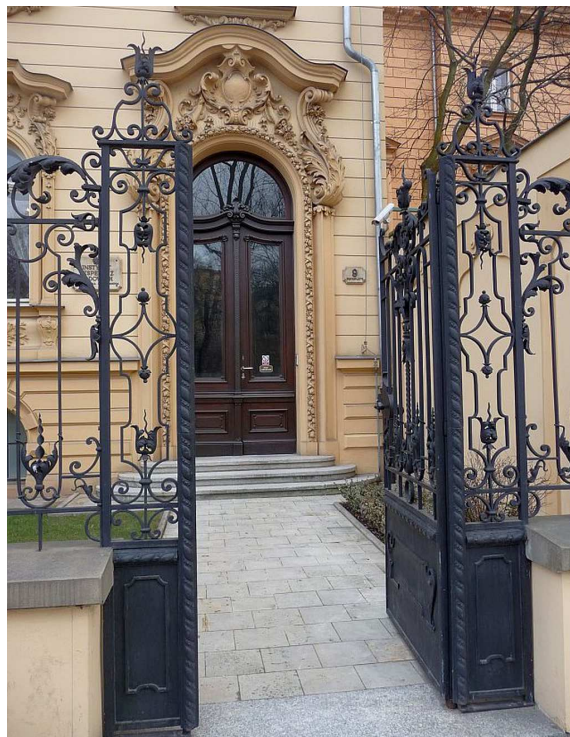
Fot. nr 93. Neorokokowe detale pałacu Jutkiewiczów. (27.02.2012)
