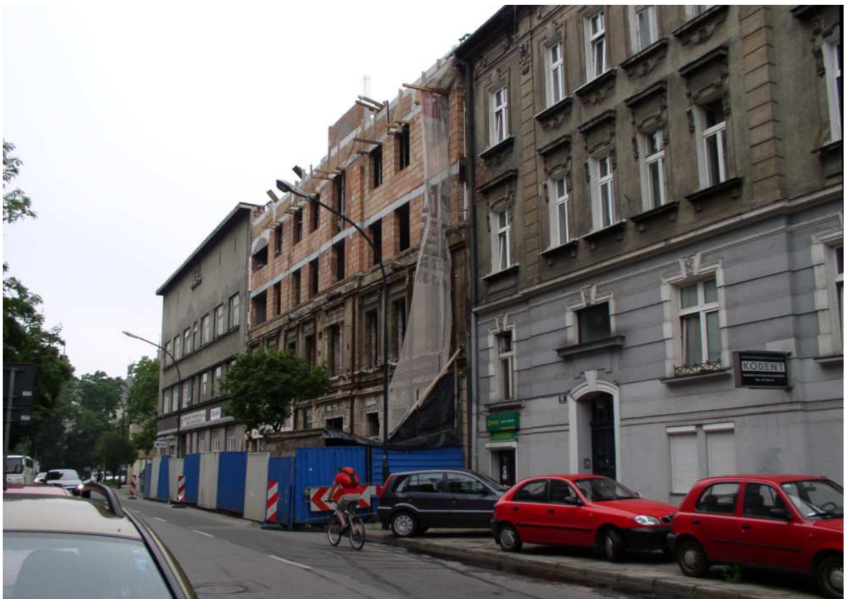
Fot. nr 117. Nowa kamienica spod nr 4 na etapie budowy. (29.06.2009)
