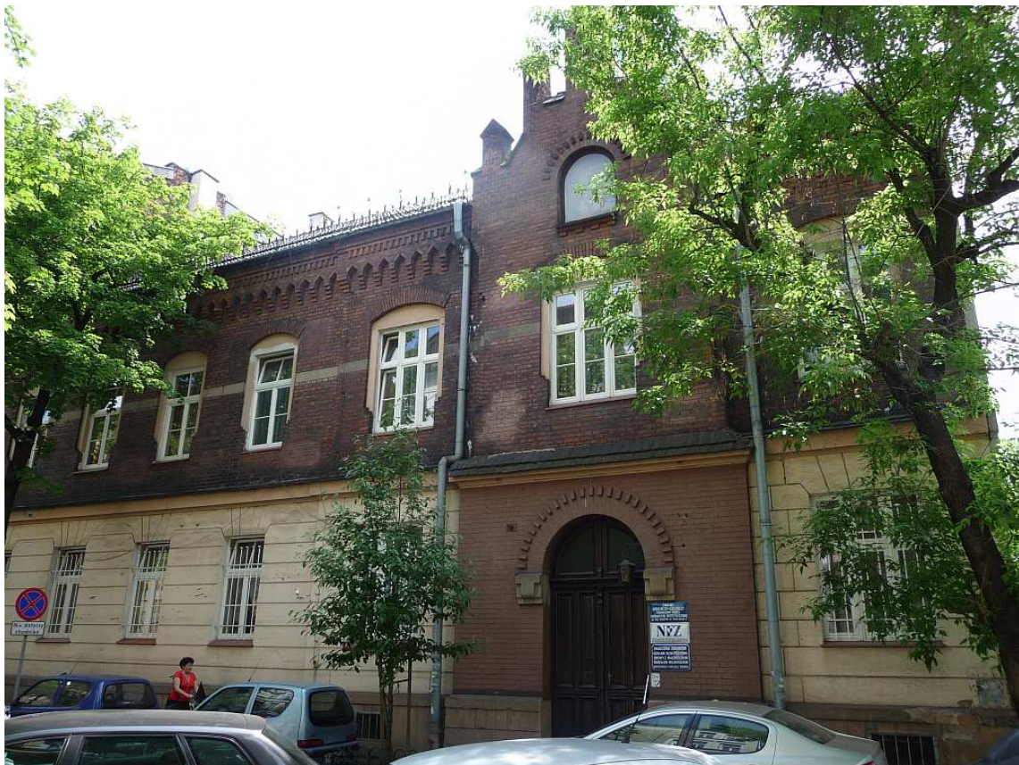
Fot. nr 79. Eklektyczny budynek dawnego Zakładu Opiekuńczo- Wychowawczego sióstr Felicjanek z ulicy Kołłątaja 7, pochodzący z końca XIX wieku. (22.05.12)
