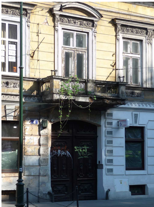
Fot. nr 9a. Detale kamienicy spod nr 4. (28.05.2012)
