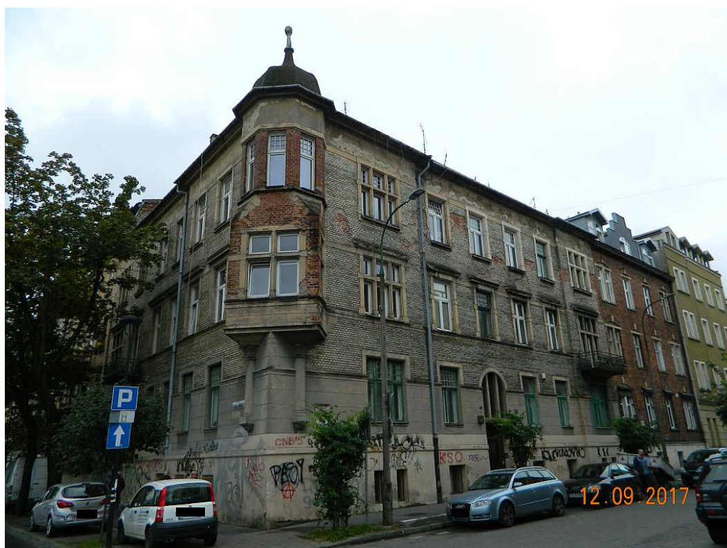
Fot. nr 353. Kamienica z naroża ulic: Ariańskiej (nr 17) i Lubomirskiego (nr 33), która została ukończona w roku 1907 wg projektu Władysława Kleinbergera.
