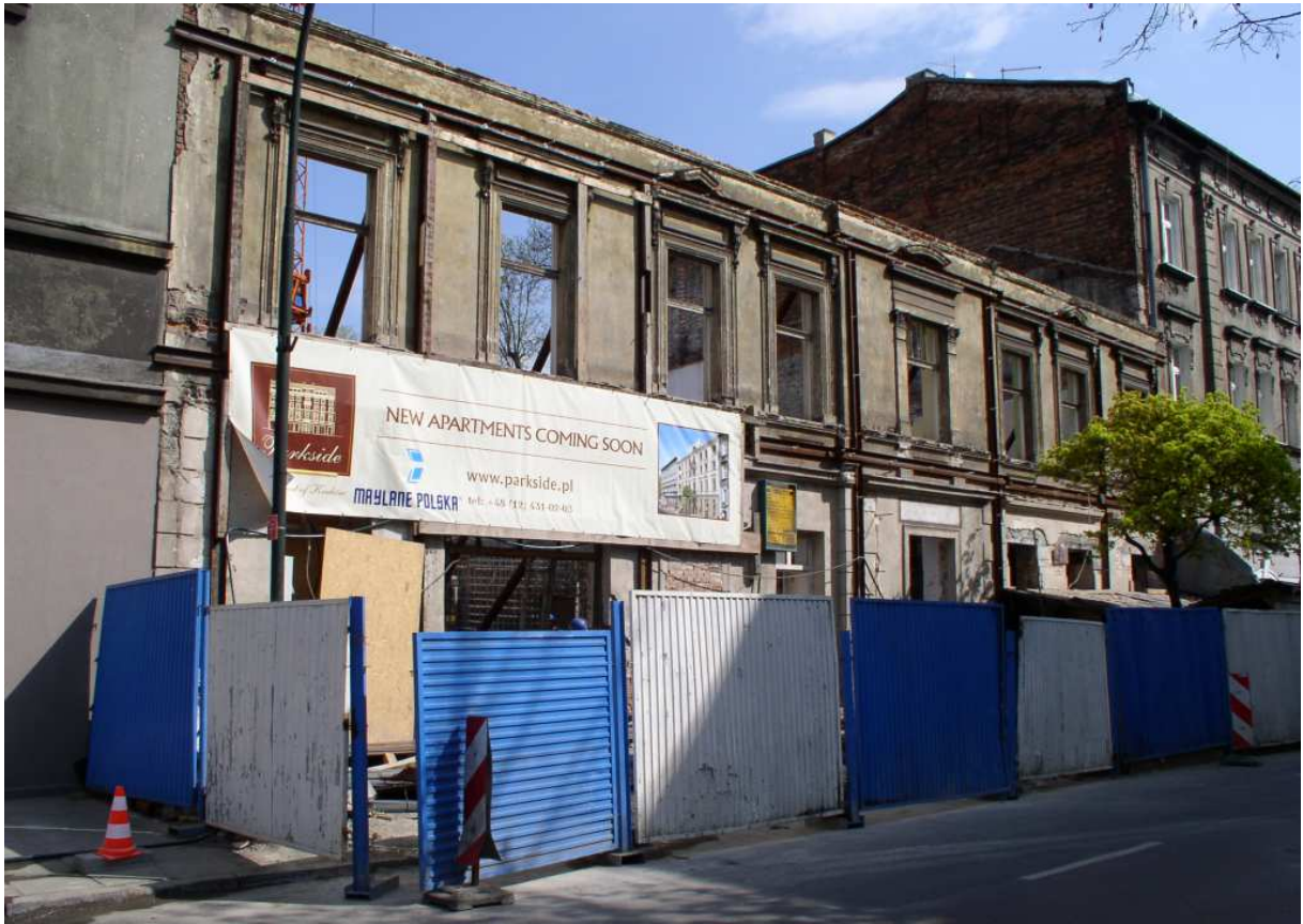
Fot. nr 116 (116-118). Kamienica spod nr 4 w trakcie wyburzania. (17.04.2009)
