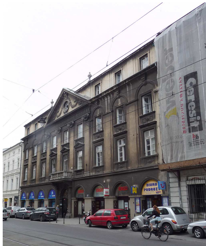
Fot. nr 40a. Kamienica o cechach klasycystycznych spod nr 17, która pochodzi z roku 1923; powstała wg projektu Janusza Zarzeckiego. (29.06.2012)
