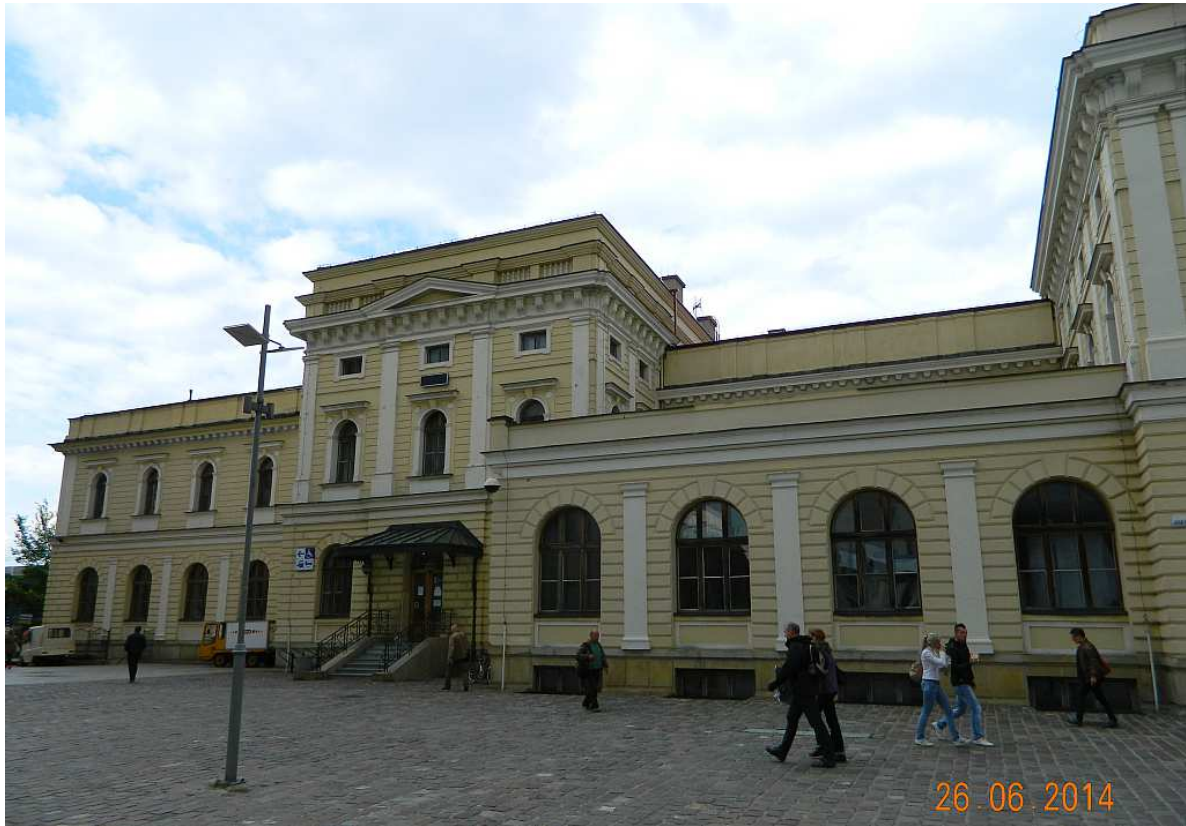
Fot. nr 282. Lewe skrzydło.
