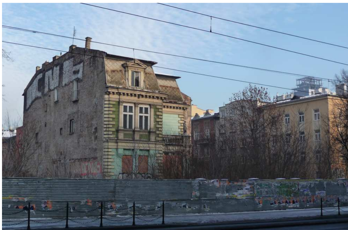
Fot. nr 325 (325-327). Ekletyczna willa spod nr 40, zapewne pochodząca z końca XIX wieku, na etapie remontu. (23.12.2011)
