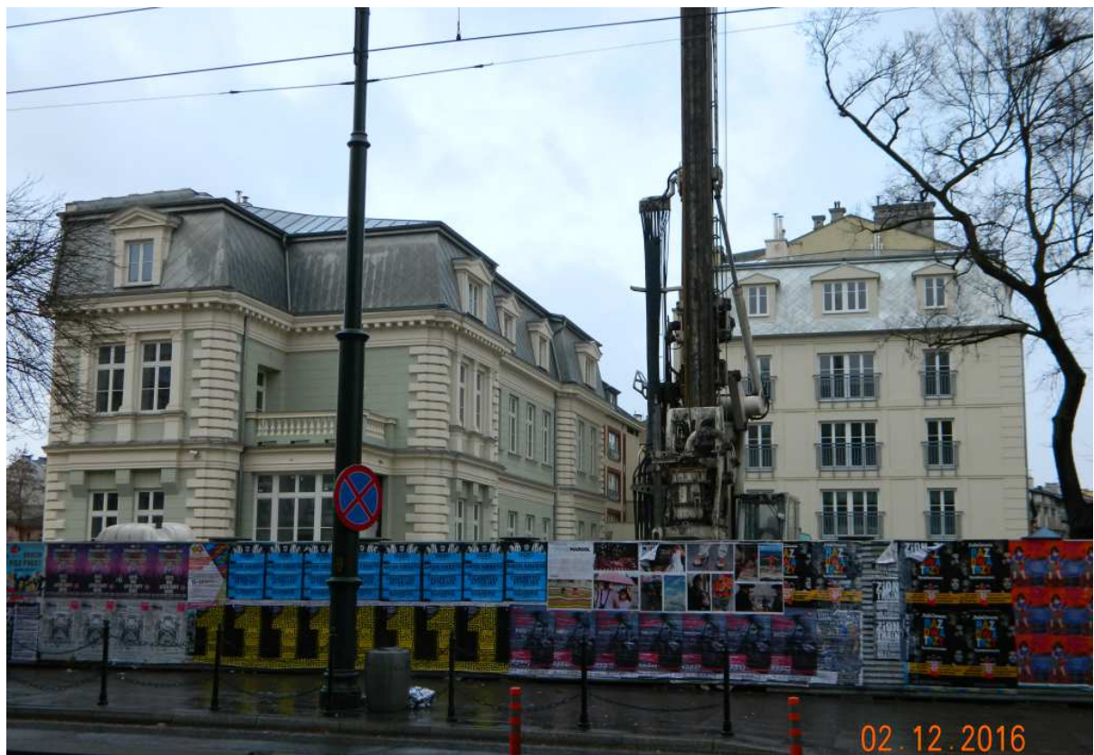
Fot. nr 327. Stan po zabudowie sąsiedniej działki pod nr 42.
