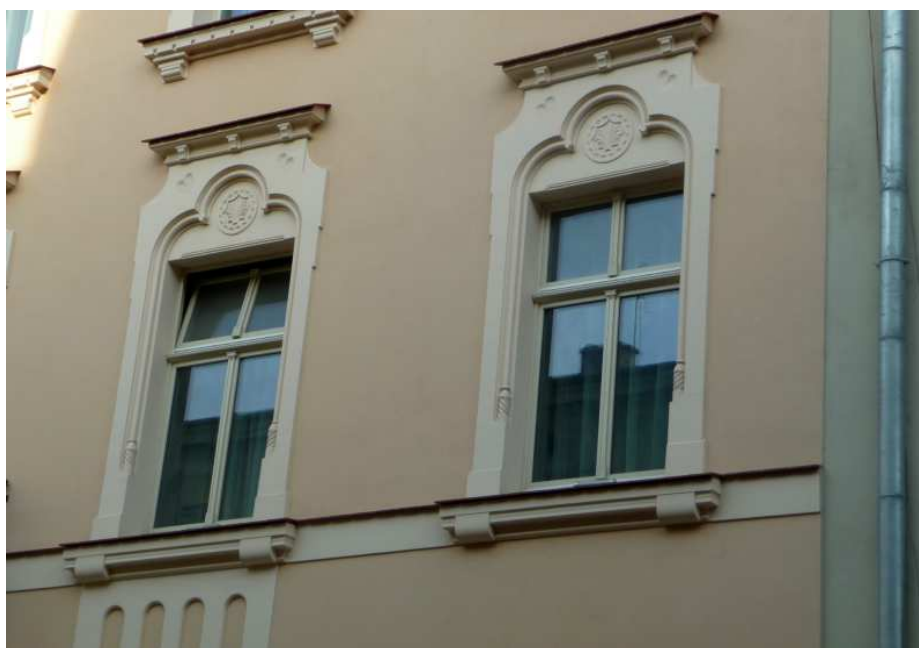
Fot. nr 54. Podczas remontu kamienicy zadbano o zachowanie detali okien, choć są one plastikowe. (04.12.2013)
