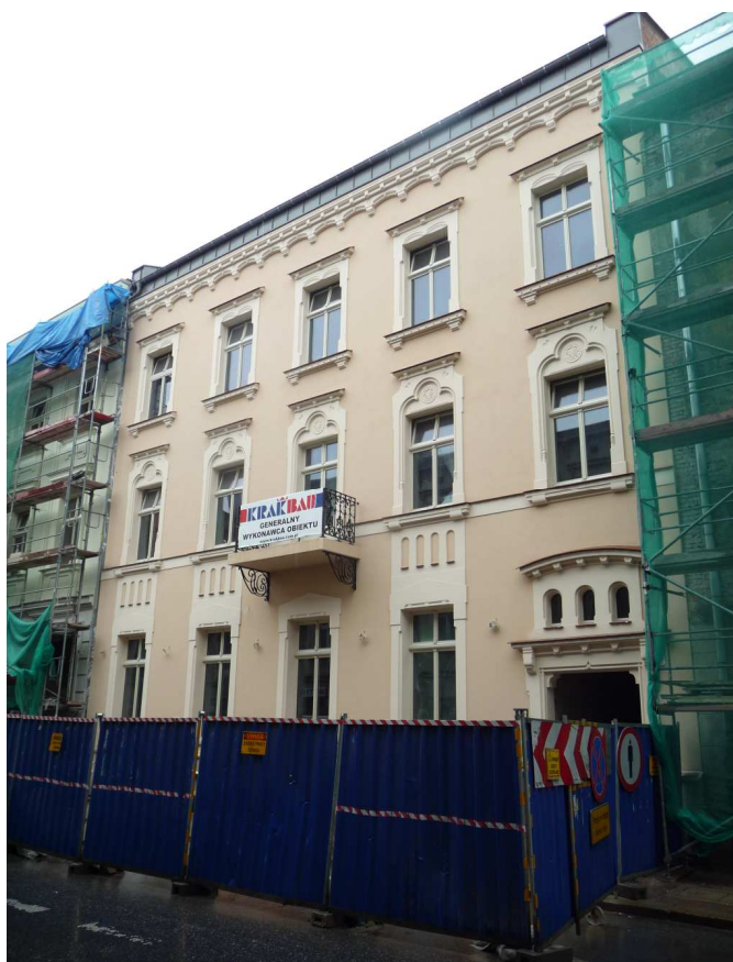
Fot. nr 52 (52-54). Obiekt na etapie przystosowywania na cele hotelowe. (13.09.2013)
