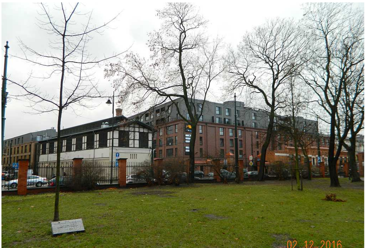
Fot. nr 303 (303-304). Nowa zabudowa terenu dawnego browaru.
