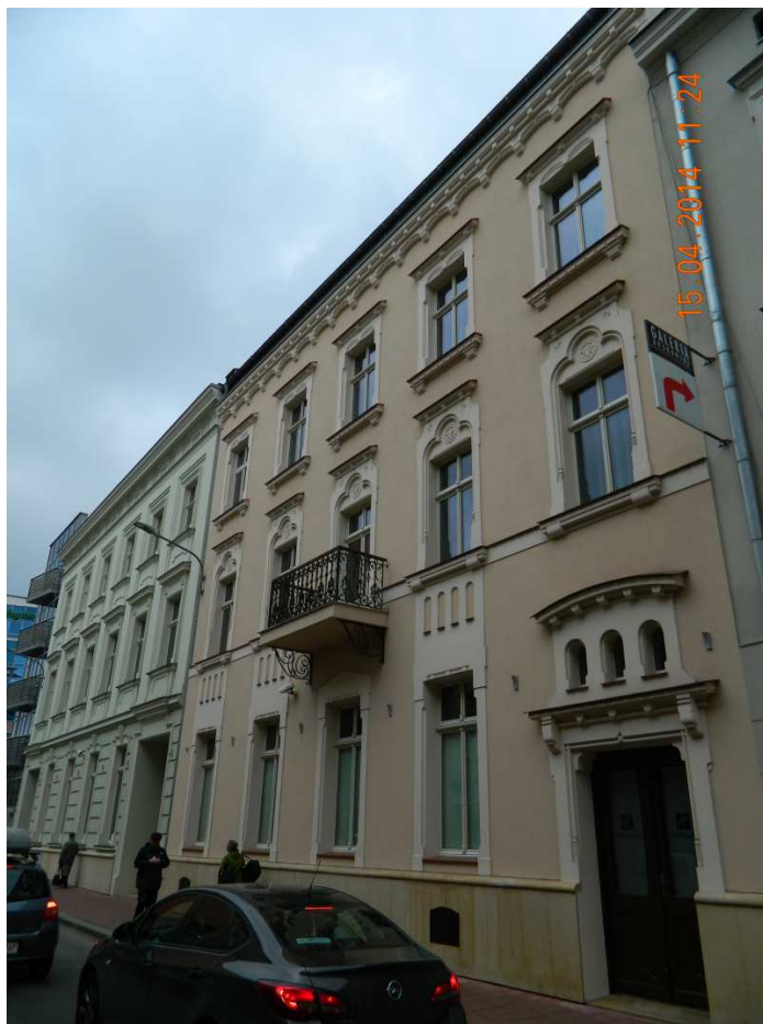
Fot. nr 55 (55-56). Kamienice pod nr 6 i 8 tuż po zakończonym remoncie. (15.04.2014)
