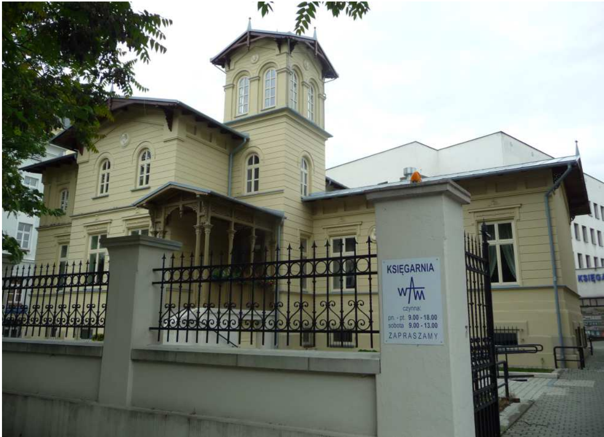
Fot. nr 156 (156-158). Stan po remoncie obiektu. (12.06.2013)
