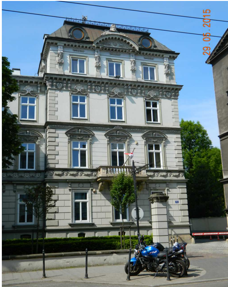
Fot. nr 38d. Prawe skrzydło pałacu.
