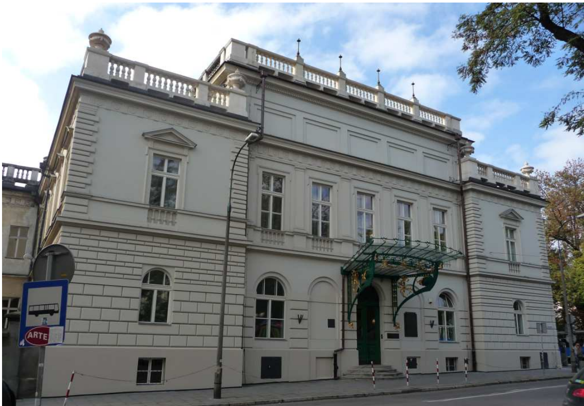
Fot. nr 61 (61-62). Fasada budynku. (21.10.2011)
