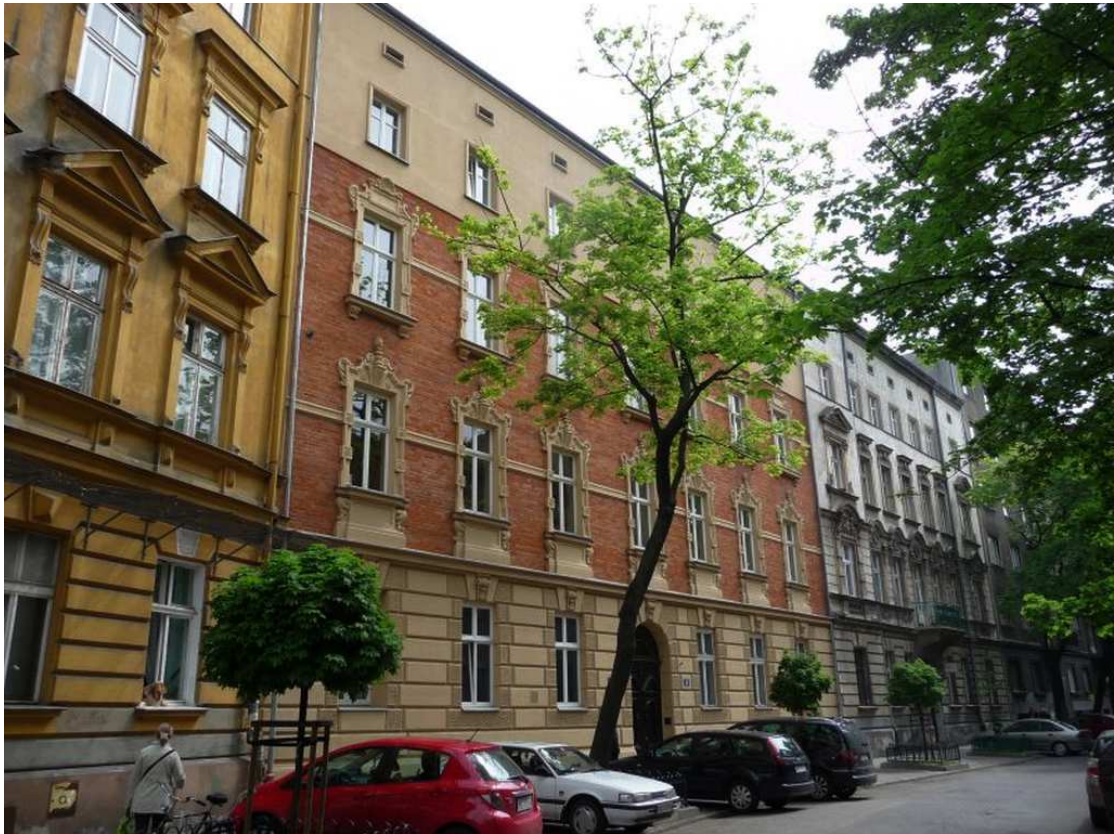
Fot. nr 21 (21-21a). Kamienice z ulicy Sarego 18 i 20. (16.05.2012)
