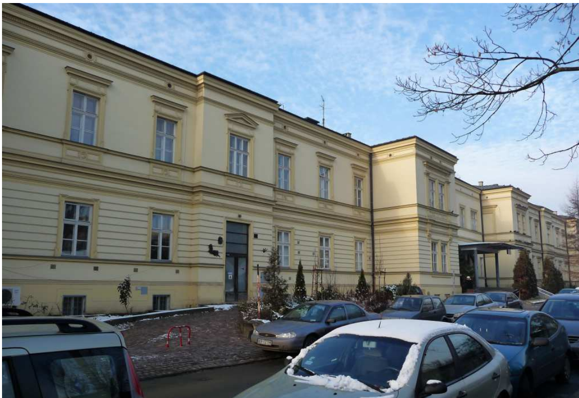
Fot. nr 225. Fasada z ryzalitami. (23.12.2011)
