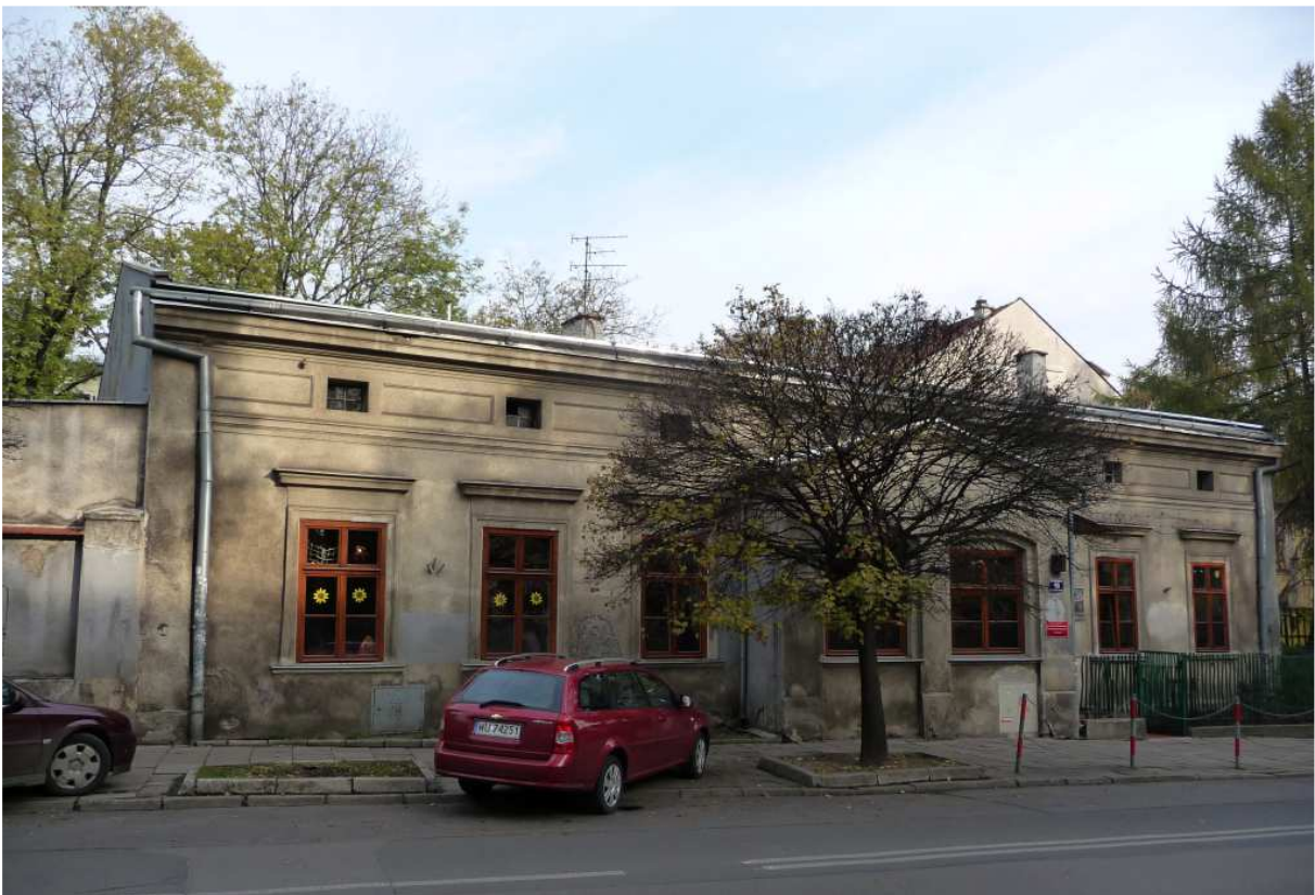
Fot. nr 139 (139-141). Stan po wymianie okien. (27.10.2011)
