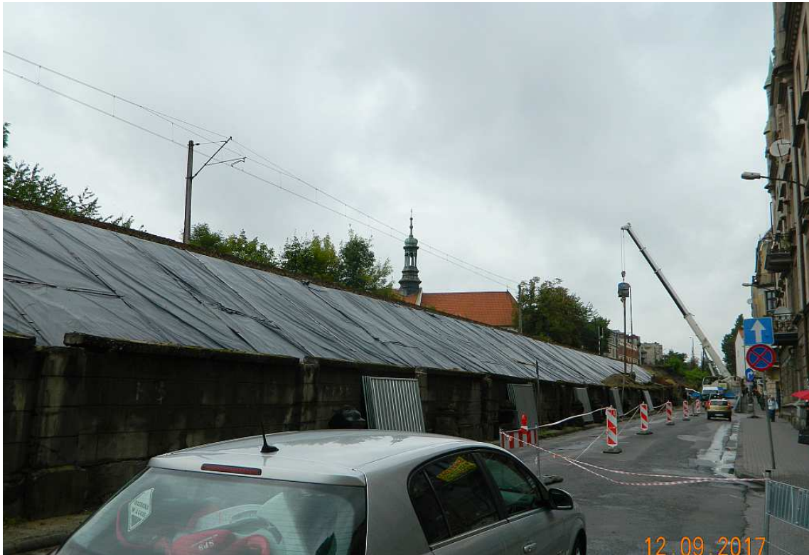
Fot. nr 78. Prace remontowe przy nasypie kolejowym biegnącym wzdłuż ulicy Blich.
