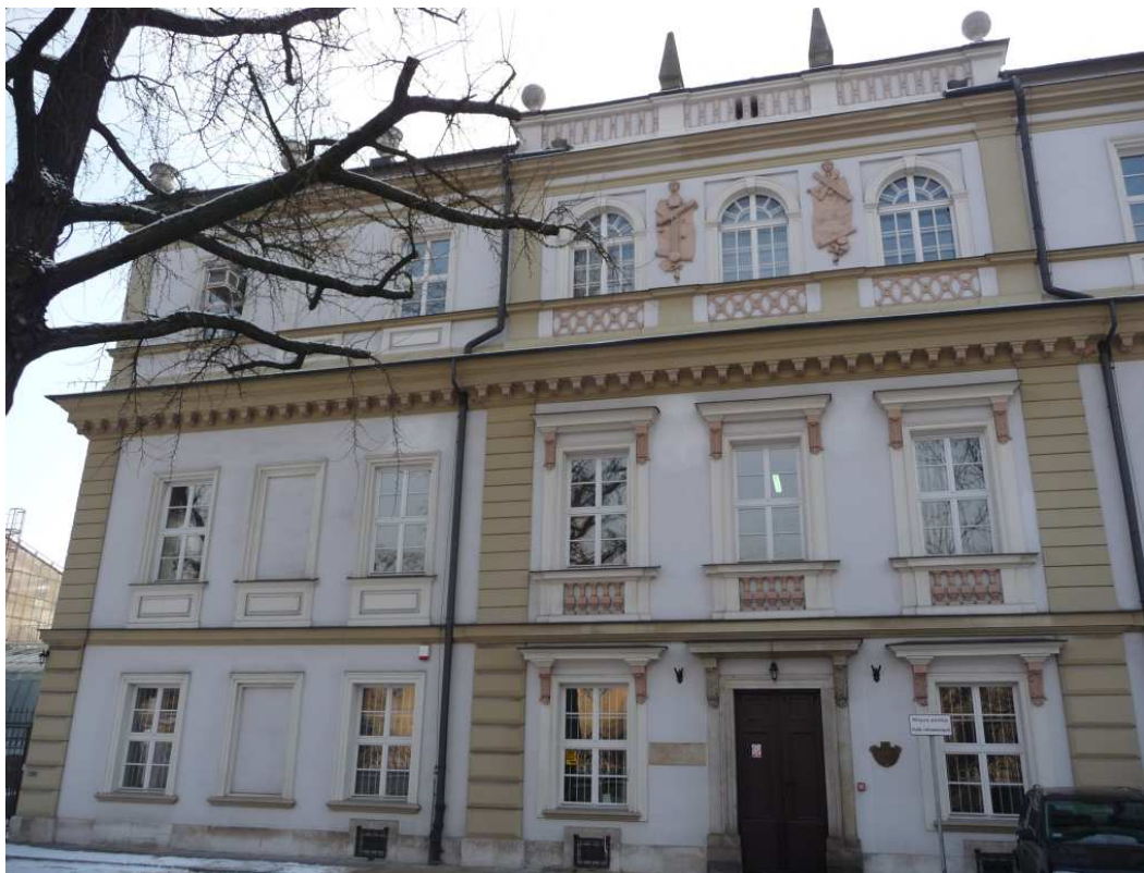
Fot. nr 217. Lewe skrzydło. (23.12.2011)
