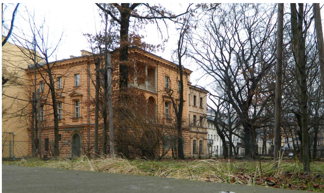
Fot. nr 89 (89-91). Pałac (wiilla) Pusłowskich spod nr 10 i przylegający do niej ogród. Budynek powstał w roku 1821 wg projektu Szczepana Humberta. (08.02.2016)
