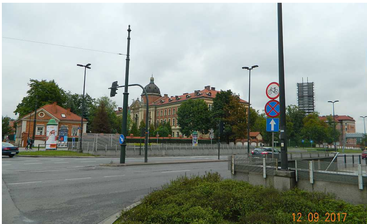
Fot. nr 337. Widok z naroża ulic: Rakowickiej i Lubomirskiego w stronę dawnej Olszy. Z lewej dawny zakład opiekuńczy fundacji Lubomirskich, obecnie siedziba UE, a z prawej „szkieletor” rozebrany do stalowego szkieletu.
