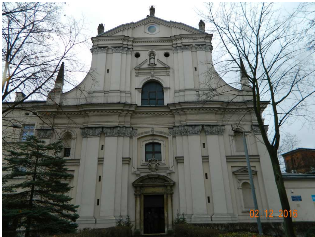
Fot. nr 171. Fasada kościoła.
