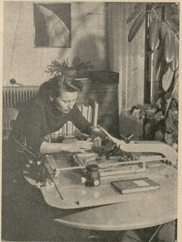
Ryc. 3. Dalszym aparatem obserwatorium przy którym widzimy asystentkę Irinę Bochníkovą, jest narzędzie służące do pomiaru współrzędnych gwiazd na kliszach fotograficznych. Przy jego pomocy można wyznaczyć położenie gwiazdy na kliszy z dokładnością do 1/10000 mm
