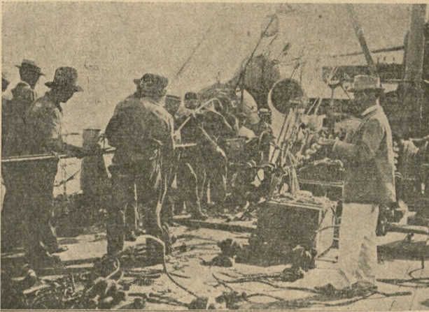
Ryc. 1. Splatanie na pokładzie statku dwóch końcówek telegraficznych kabli podmorskich kładzionych równocześnie od brzegów dwóch kontynentów (zdjęcie fotograficzne z lat 90 wieku ubiegłego)
